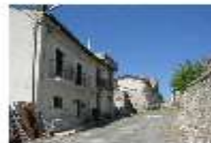
Rispetto fotografico prima e dopo gli interventi
