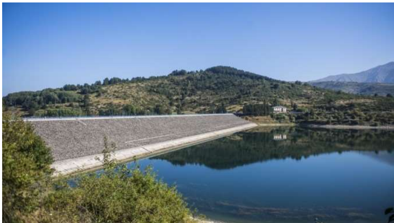
Diga di Poggio Cancelli – Campotosto (Aq).
