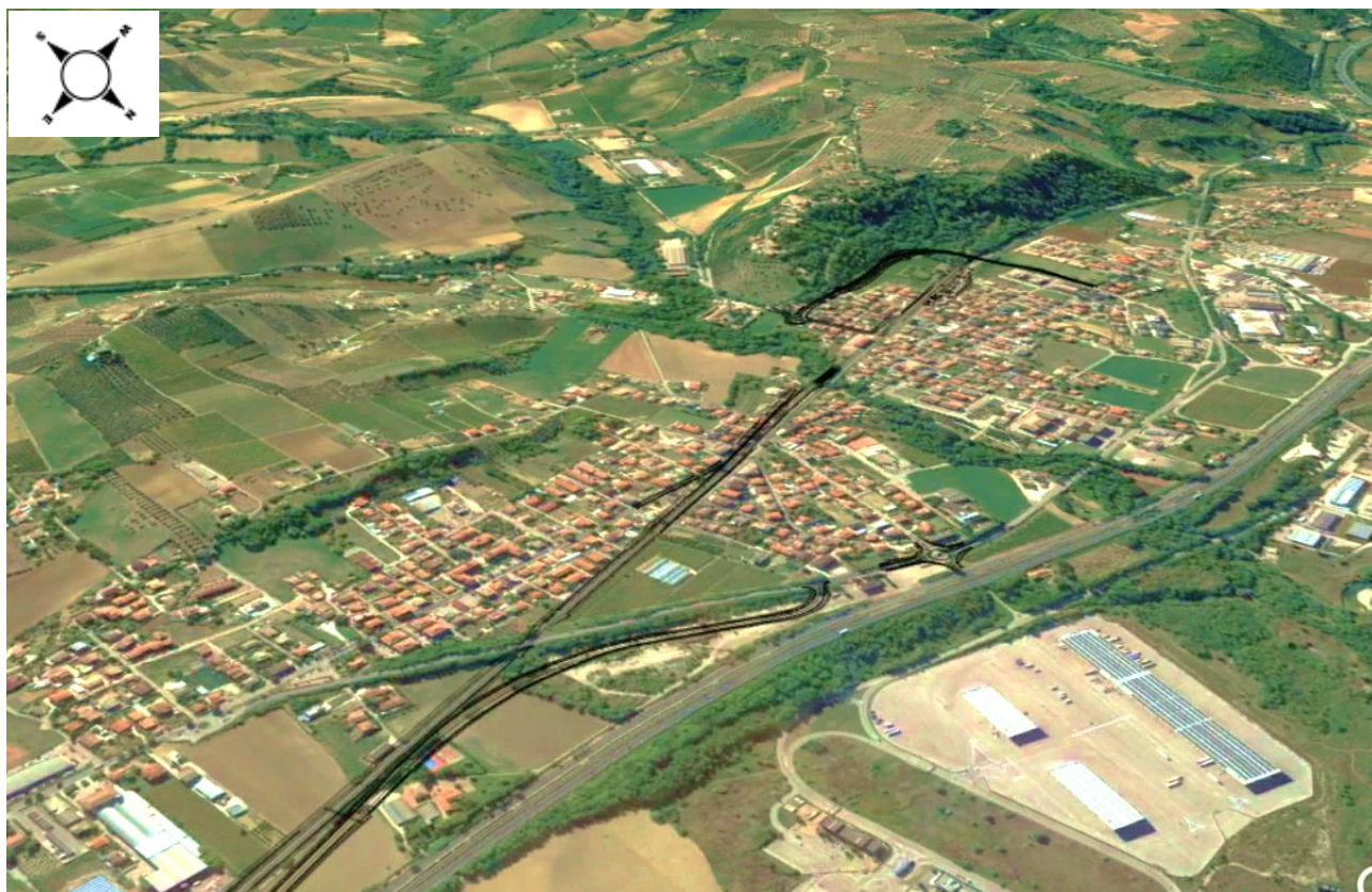
Figura 2-29 - Panoramica del tratto di intervento sul contesto rurale territoriale insediativo Comune di Manoppello
