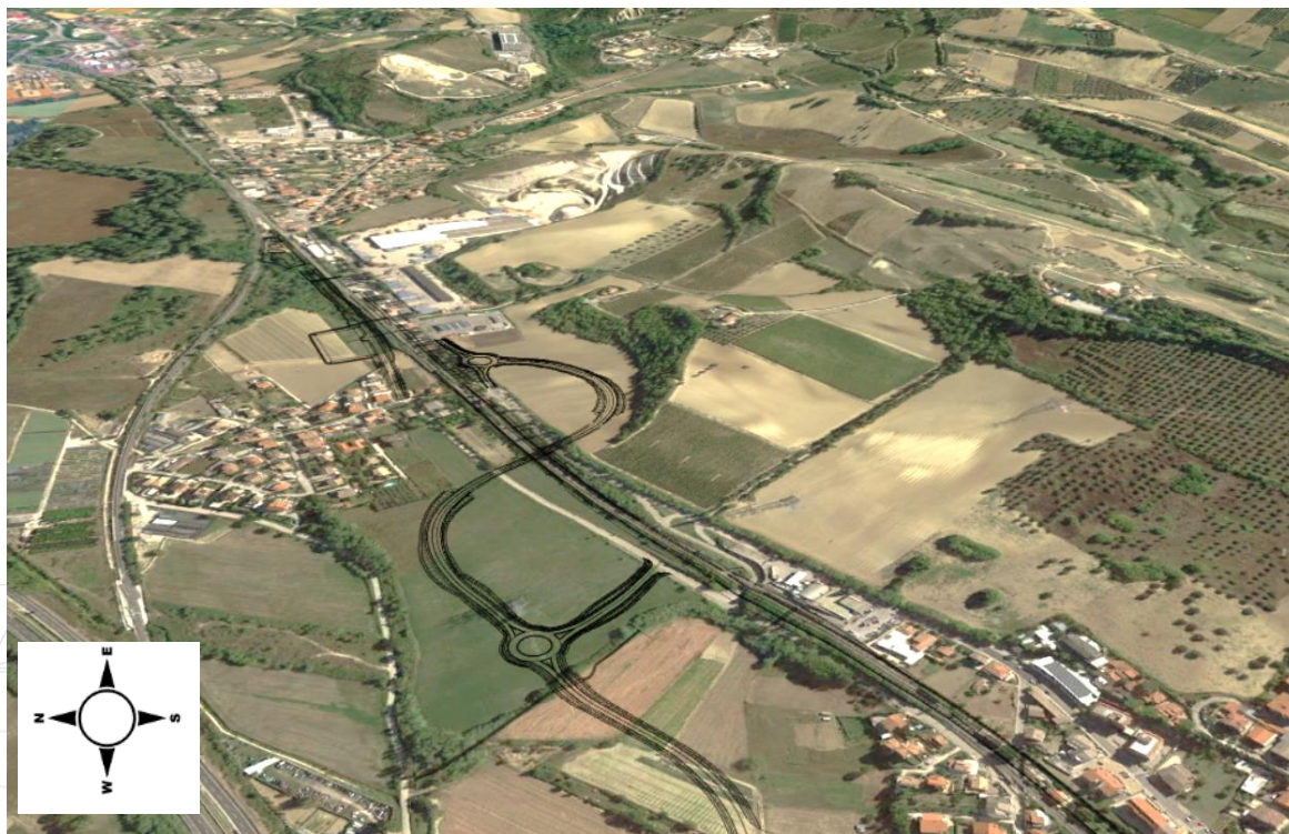
Figura 2-23 - Panoramica del tratto di intervento a Nord sul contesto territoriale rurale nella frazione di Brecciarolo (Comune di Chieti)
