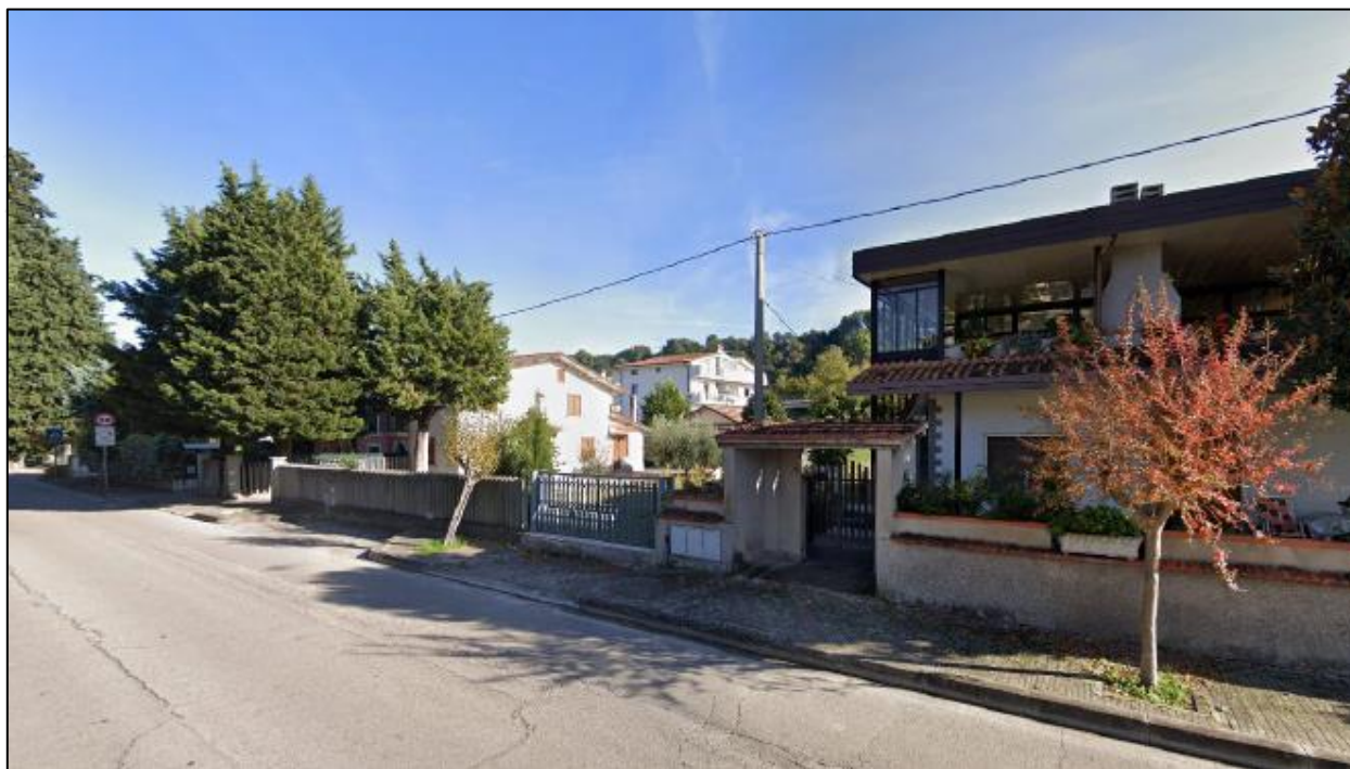
FRONTE EDIFICATO LUNGO VIA GIACOMO MATTEOTTI, ALTEZZA VIA TIRINO, MANOPPELLO SCALO
