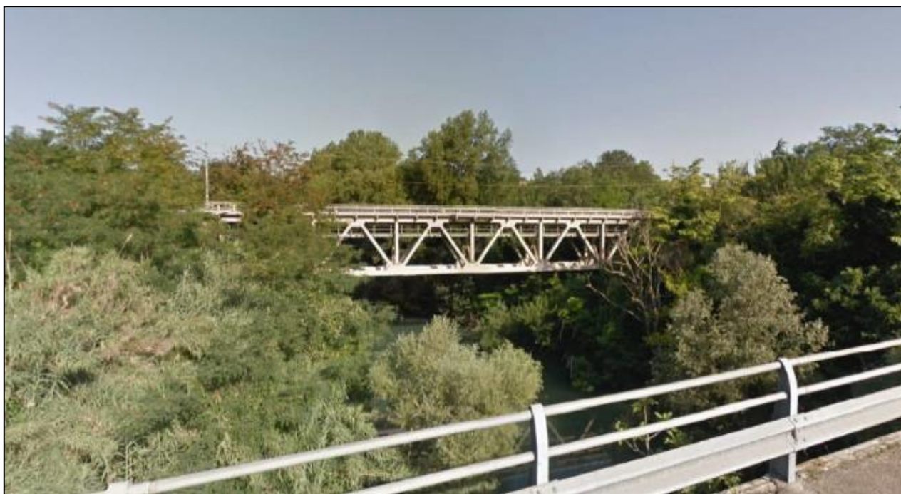
TRATTO DI ATTRAVERSAMENTO DEL FIUME PESCARA AD EST DI SCAFA, LUNGO LA SP64
