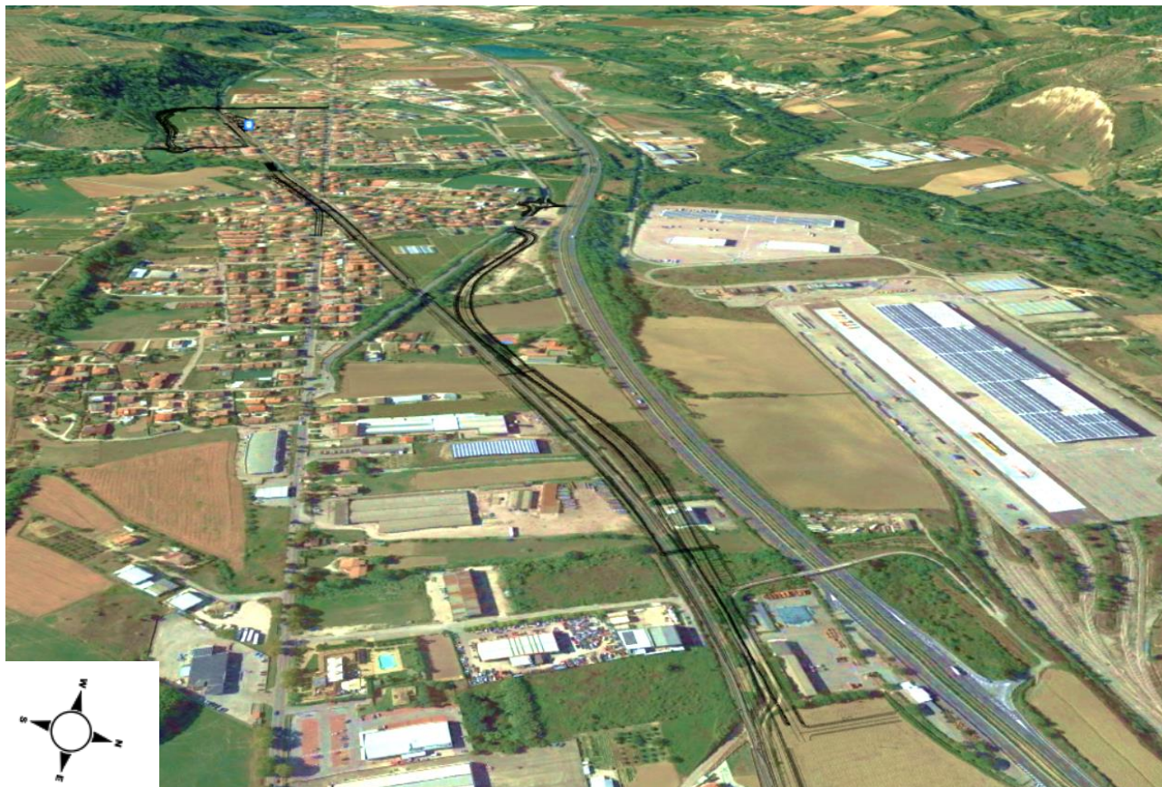
Figura 2-27 - Panoramica del tratto di intervento sul contesto rurale territoriale insediativo Comune di Manoppello
