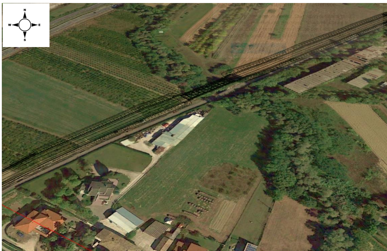
Figura 2-25 - Panoramica del tracciato in corrispondenza dello scavalco del torrente Calabrone
