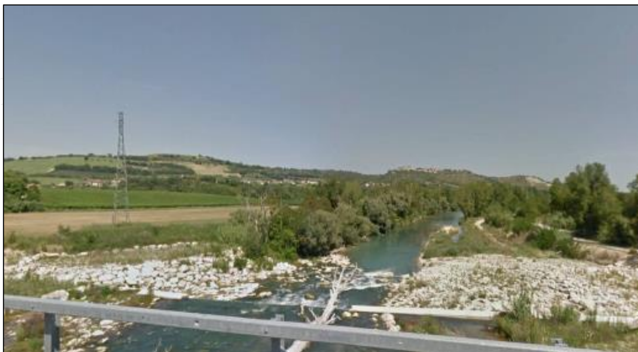
ATTRAVERSAMENTO DEL FIUME PESCARA, PONTE DI ROSCIANO, IN DIREZIONE NORD
