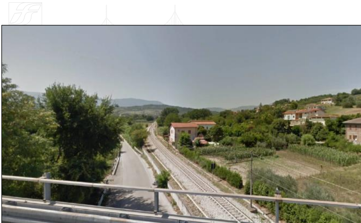
ATTRAVERSAMENTO FERROVIARIO SU VIA FIUME PESCARA, ALANNO, IN DIREZIONE SUD
