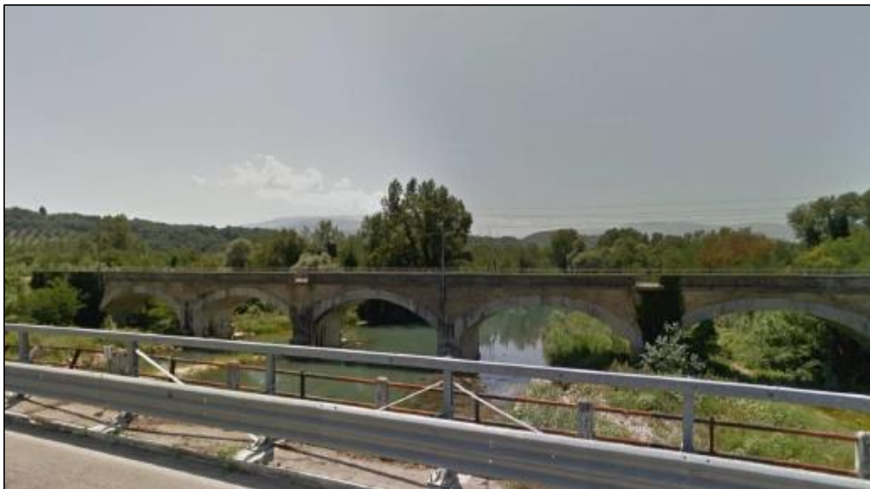
ATTRAVERSAMENTO FERROVIARIO DEL FIUME PESCARA, PONTE DI ROSCIANO, IN DIREZIONE SUD
