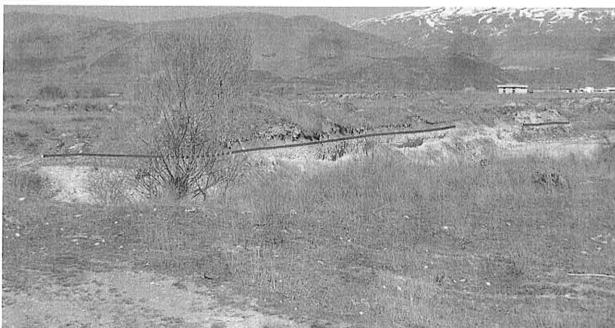
Figura 2: Nell'immagine è evidenziato il limite (linea rossa), tra substrato geologico (ghiaie) e il sovrastante accumulo di rifiuti di varia natura misto a terreno
