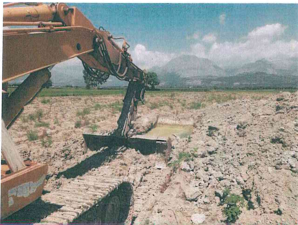
Foto 7 – Fucino Strada N.16 – Fonte: Dipartimento Agricoltura
