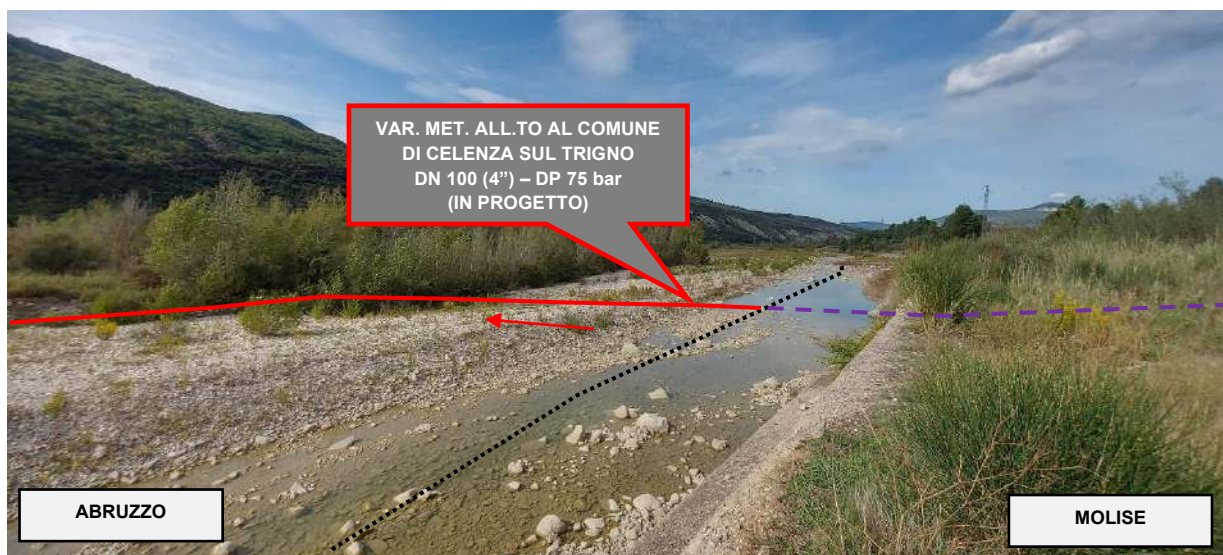
Foto 1 – Percorrenza tratto V2-V3 attraversamento del fiume Trigno con T.O.C. a confine tra Regione Abruzzo e Regione Molise
