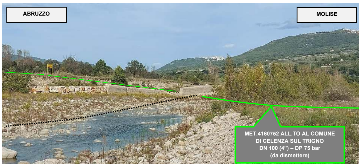
Foto 6 – Attraversamento fiume Trigno da dismettere da V10 al P.I.D.S. n. 4160752/1 a confine tra Regione Abruzzo e Regione Molise
