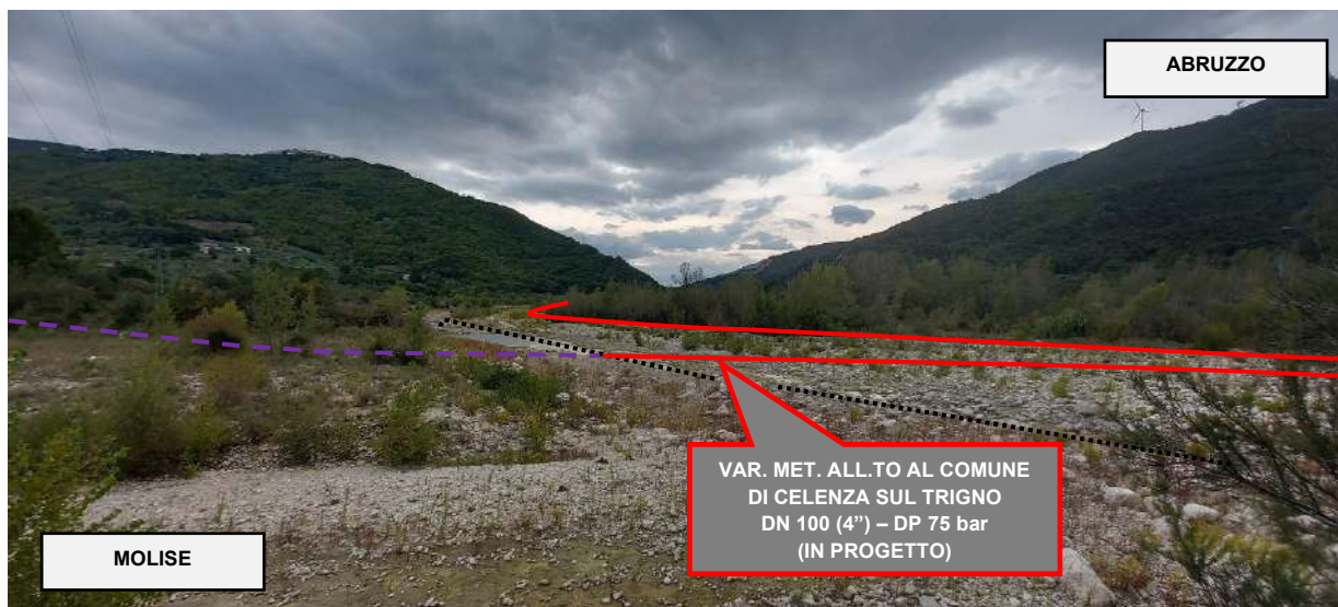
Foto 2 – Percorrenza tratto V2-V3 attraversamento del fiume Trigno con T.O.C. a confine tra Regione Abruzzo e Regione Molise
