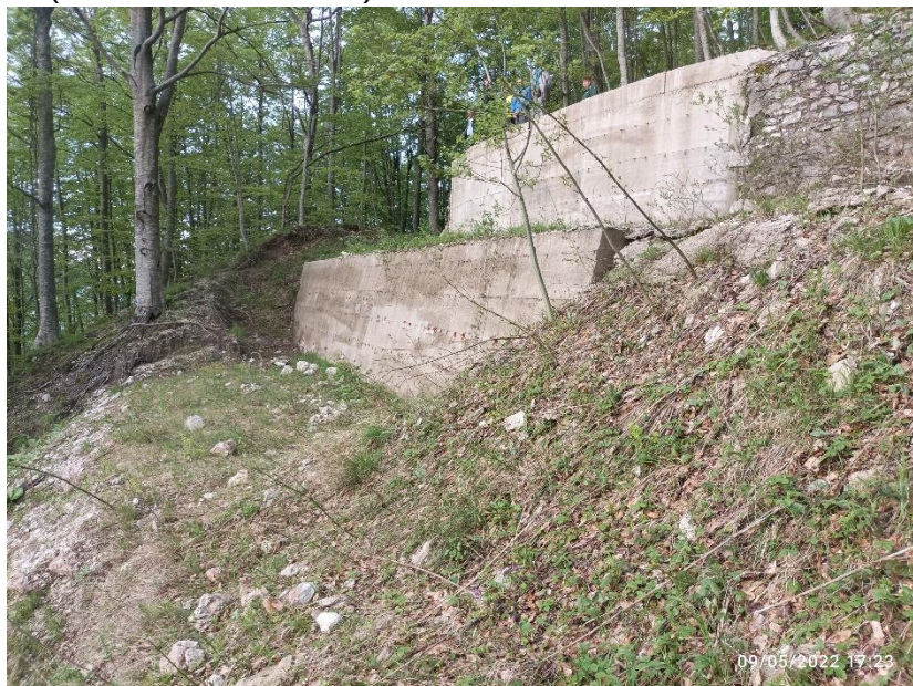
Figura 58 – Superfici da rivestire in pietrame
