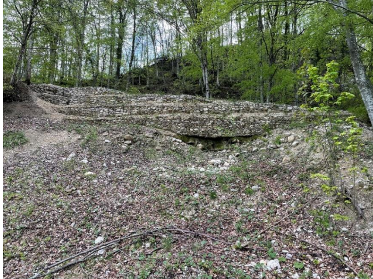
Figura 53 – Gabbionata lungo la strada di accesso per Fonte Nera
