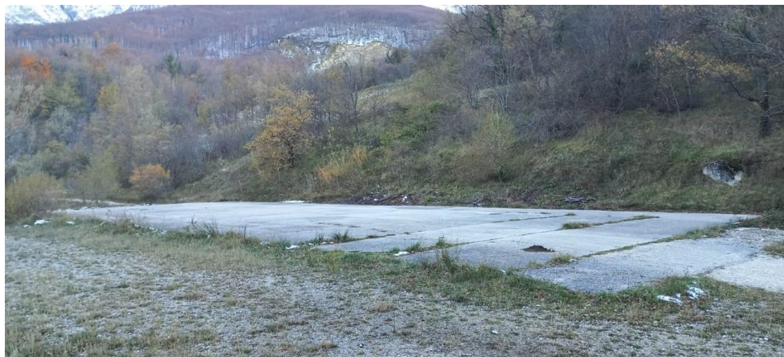
Figura 92 - Cantiere Piazzale Cementato
