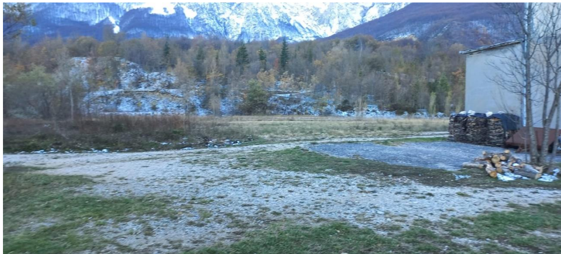
Figura 94 – Cantiere Piazzale Sterrato nord – vista verso il massiccio del Gran Sasso (inquadramento da est verso ovest)
