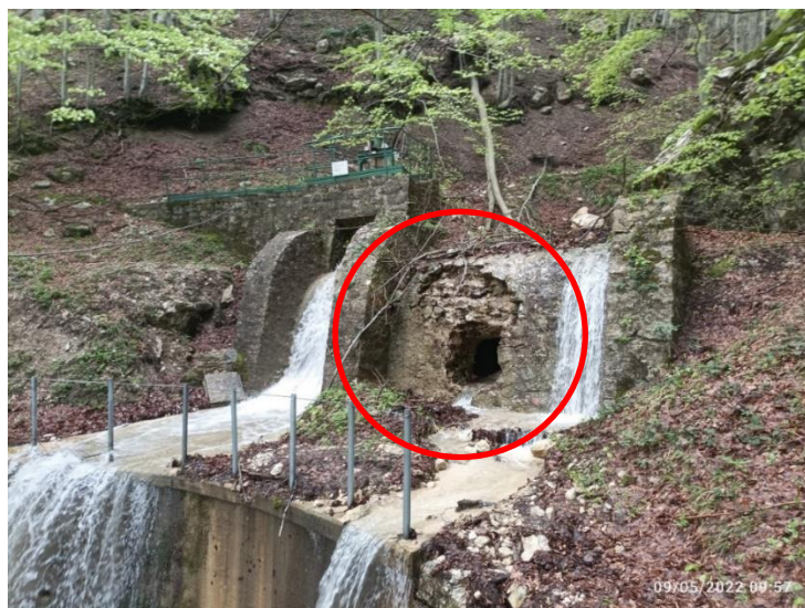
Figura 76 - Breccia da sistemare
