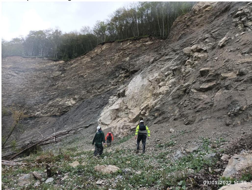
Figura 1 - Dissesto che ha interessato una parte del canale di gronda Ruzzo Mavone
