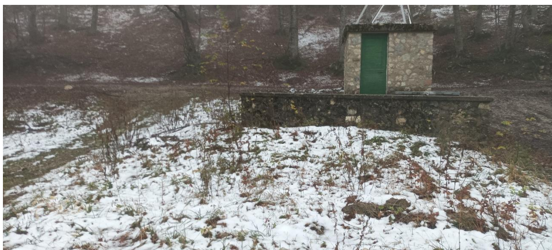
Figura 87 - accessi cantiere (orientamento: da est verso ovest)
