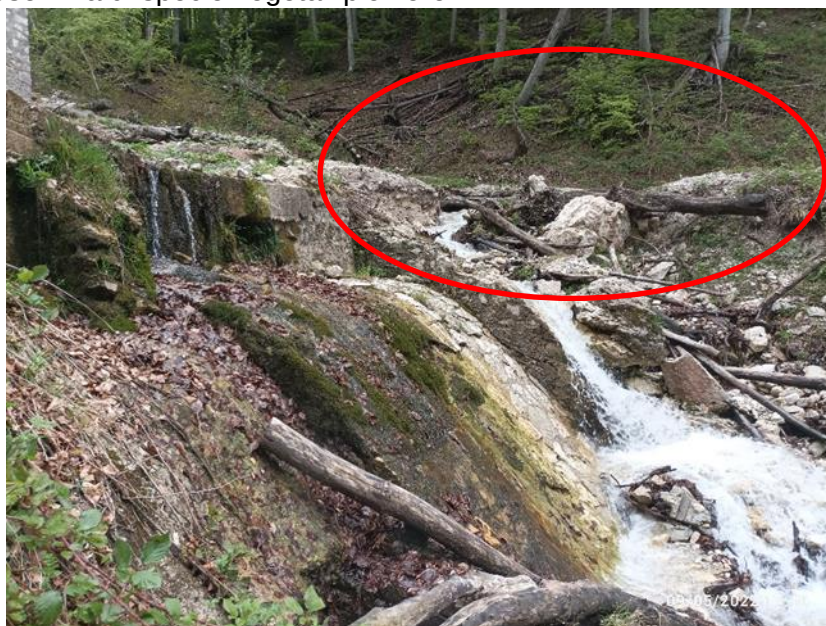
Figura 66 - Tratto di strada da ripristinare – vista da valle
