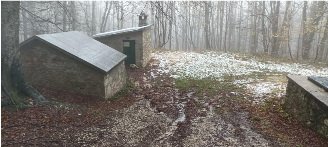
Figura 83 - Accesso nord area cantiere (orientamento: da ovest verso est)
