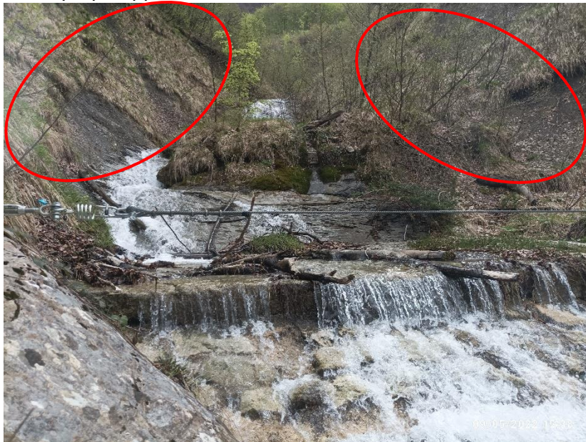
Figura 71 – Porzioni di versante in erosione a destra ed a sinistra dell'alveo
