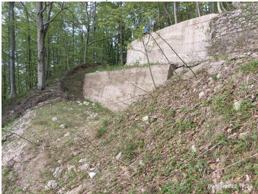
Figura 18 - gronda (sopra) e muro (sotto) di cls da rivestire
