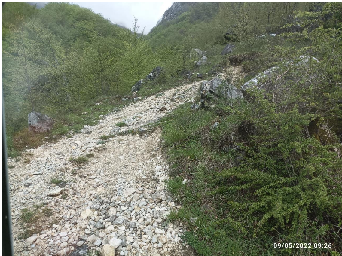
Figura 111 – Accumulo di sedimenti ed incisioni localizzate di un tratto di pista forestale
