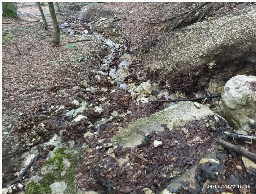
Figura 57 – Area dell'impluvio interessata dalla sistemazione
