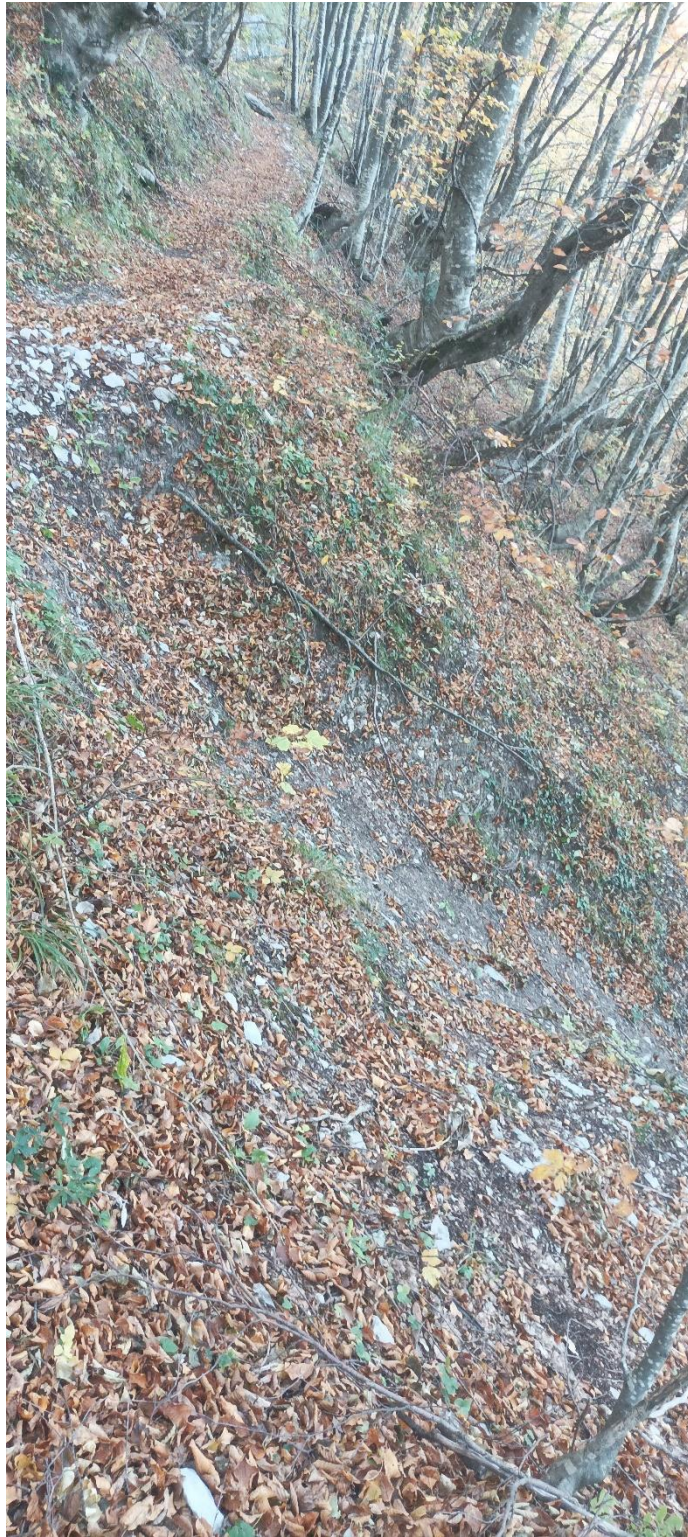
Figura 114 – Erosione del versante sul quale passa il sentiero
