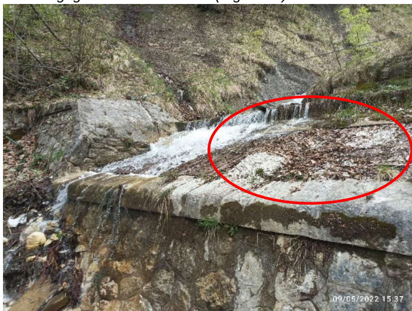
Figura 68 – Griglia dell'OP San Vittore 1 – particolare dell'accumulo di sedimenti in sinistra idraulica
