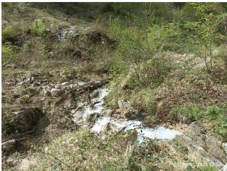
Figura 75 – Alveo di valle – da notarsi blocchi di calcestruzzo (derivanti dalla rottura della canalina di scarico della paratoia) in alveo
