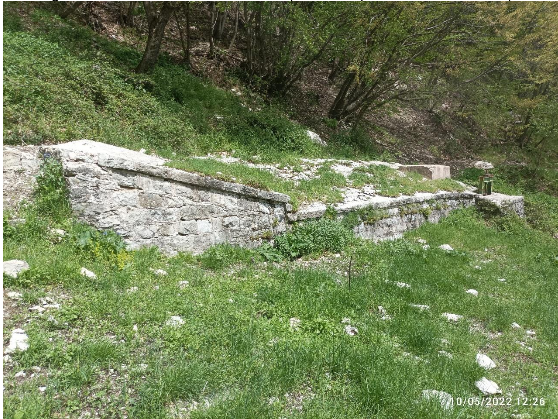
Figura 33 – porzione di opera civile in sinistra idraulica dell'OP Mavone 2
