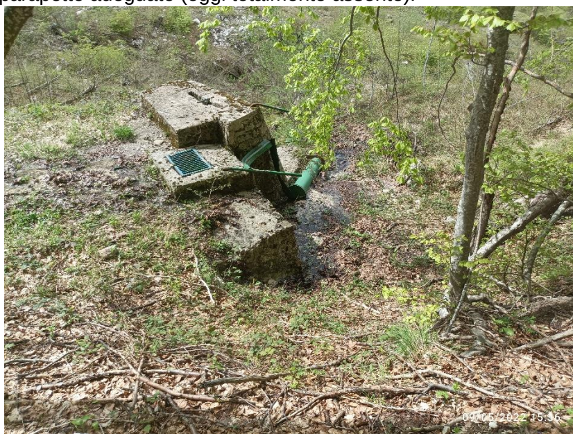
Figura 74 – Manufatto dove dovrà essere installato sia il volantino di manovra che il parapetto
