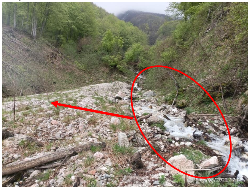
Figura 63 – Porzione di alveo, a monte della griglia dell'OP Fiumette, che dovrà essere risagomata. La freccia indica la posizione originaria dell'alveo
