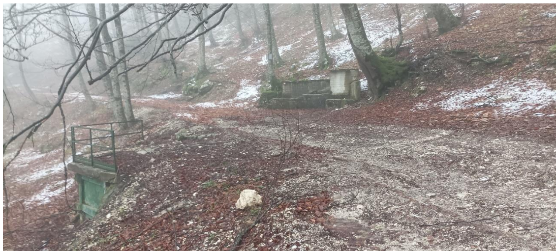
Figura 89 - accesso principale cantiere da valle (orientamento: da nord verso sud)
