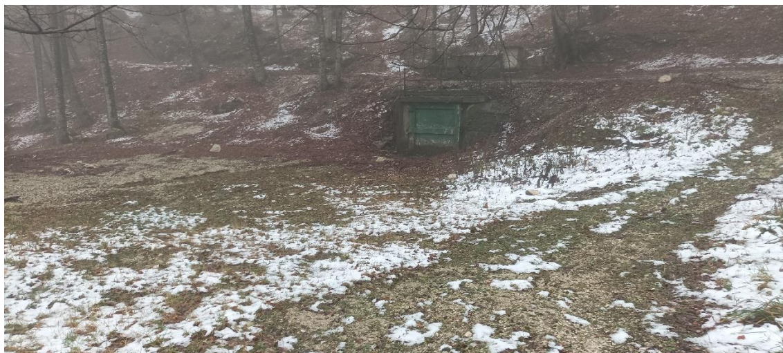
Figura 86 - accesso galleria (orientamento: da nord verso sud-est)
