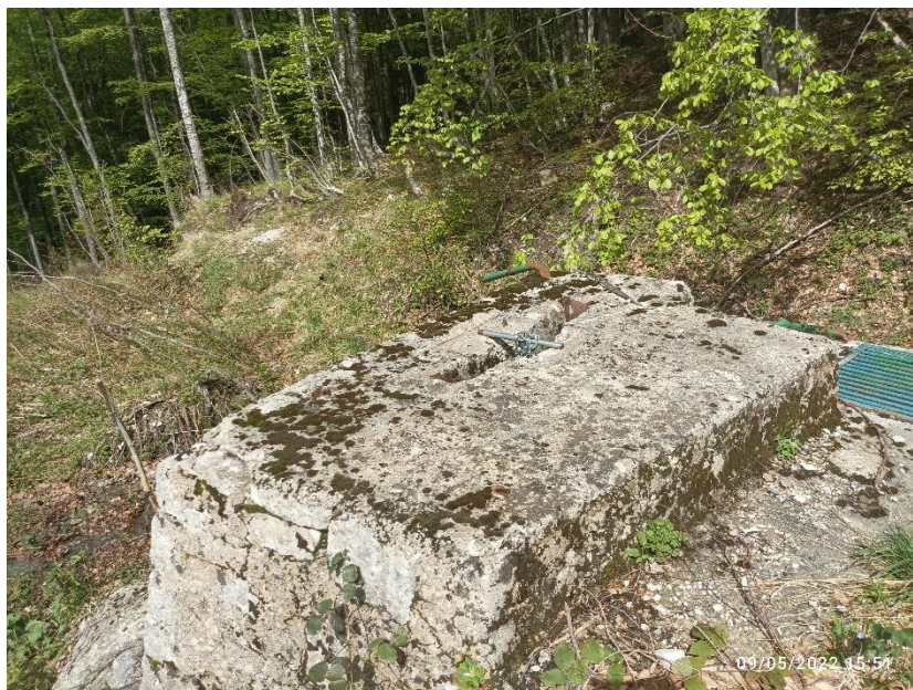
Figura 73 – Particolare della paratoia priva di volantino di manovra
