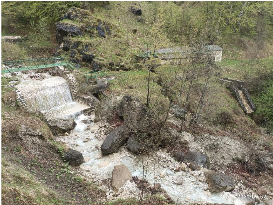
Figura 97 - OP San Nicola 2 – il deposito verrà effettuato nei pressi delle opere civili dell'opera di presa
