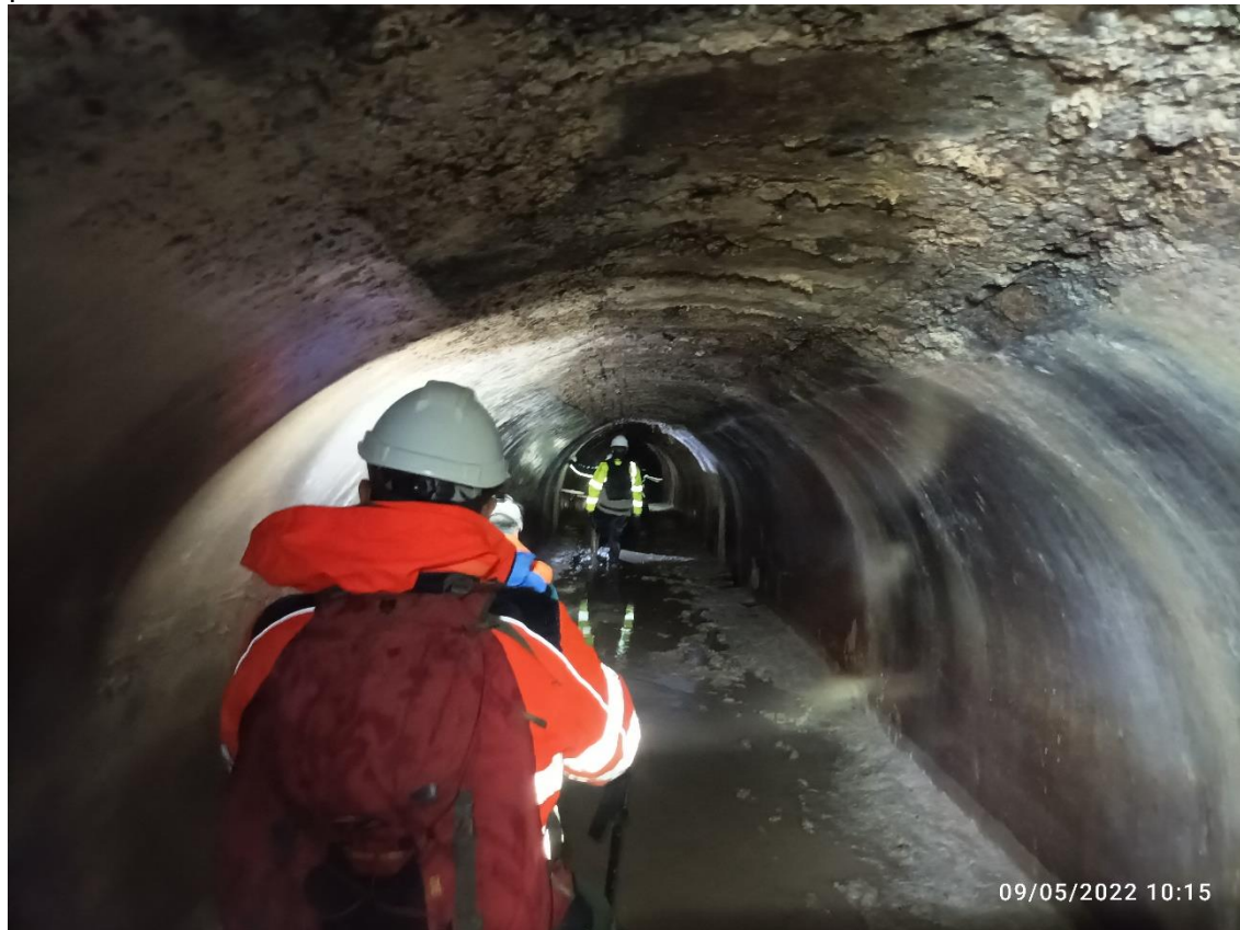
Figura 52 -Tratto di galleria a monte dell'OP San Nicola 1 – da notare il materiale inerte accumulatosi alla base dei piedritti della galleria
