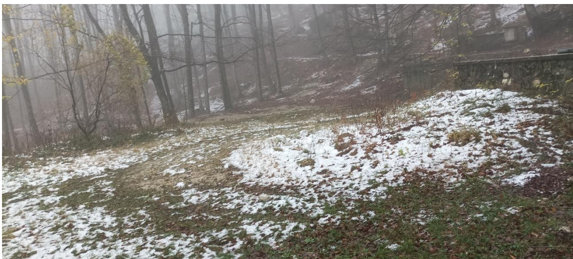
Figura 85 - area cantiere – sulla destra è visibile in lontananza l'accesso della galleria (orientamento: da nord verso sud)
