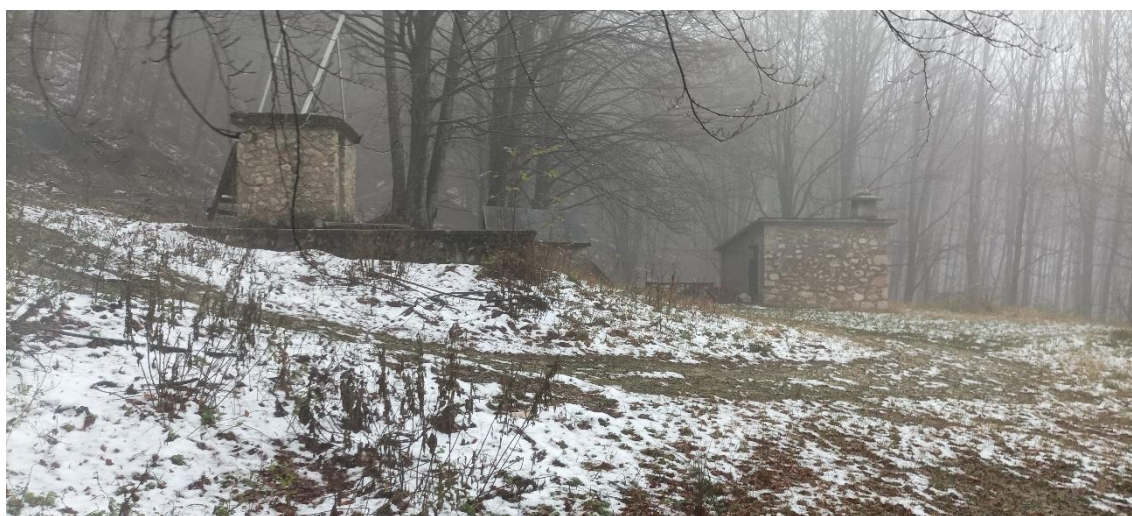
Figura 88 - edifici ed accesso cantiere (orientamento: da sud verso nord)
