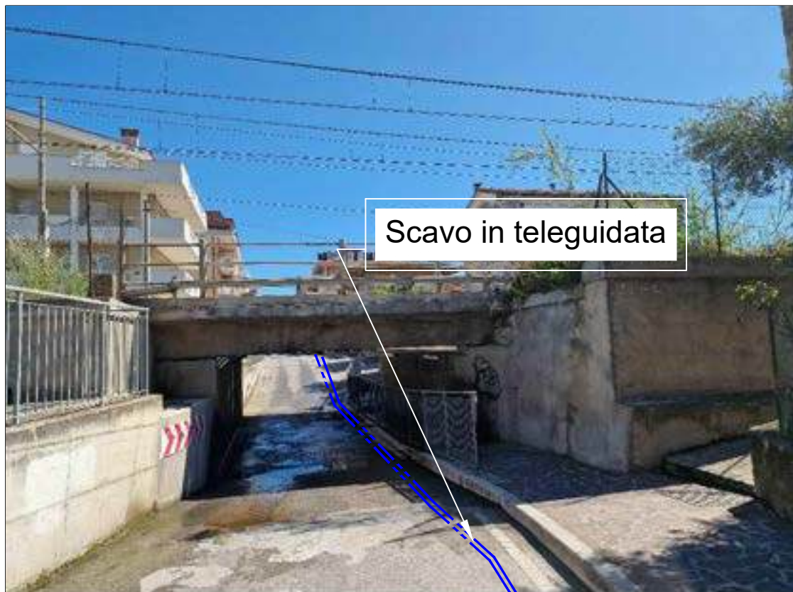
FOTOGRAFIA 10 Silvi - Attraversamento Ferrovia Adriatica
