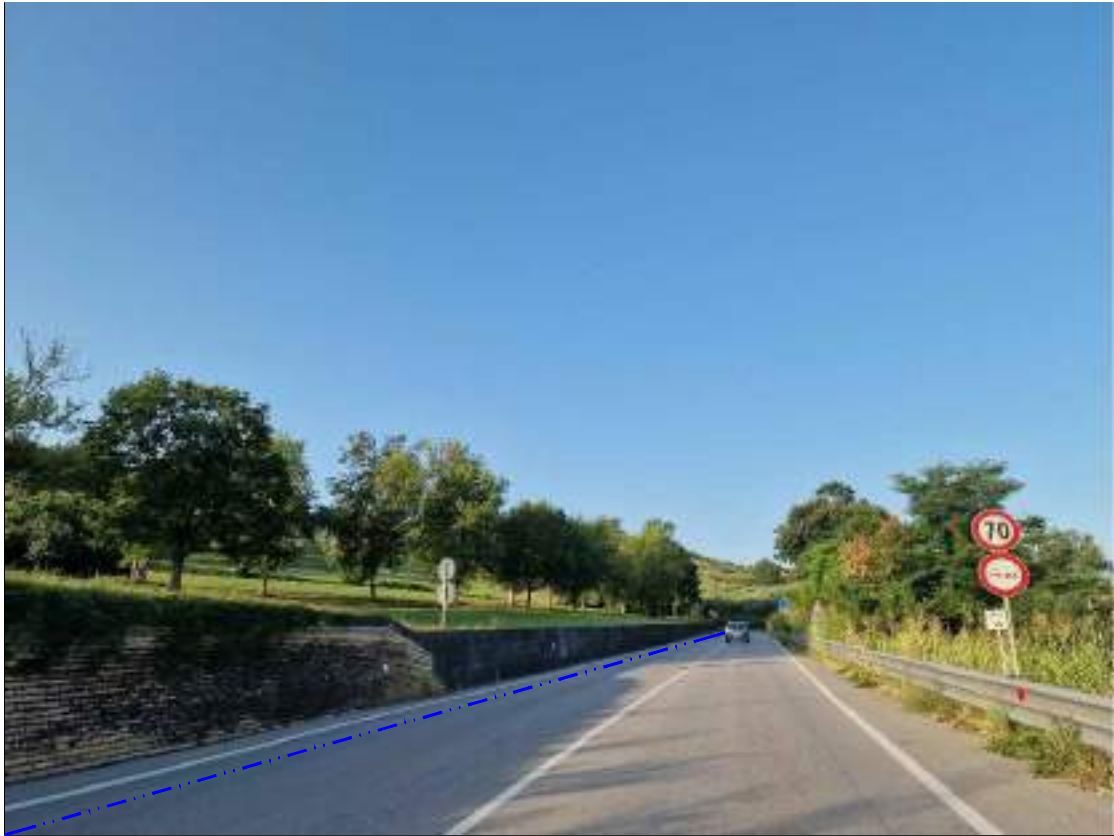
FOTOGRAFIA 47 - Strada Statale n. 150 (Comune di Montorio al Vomano)
