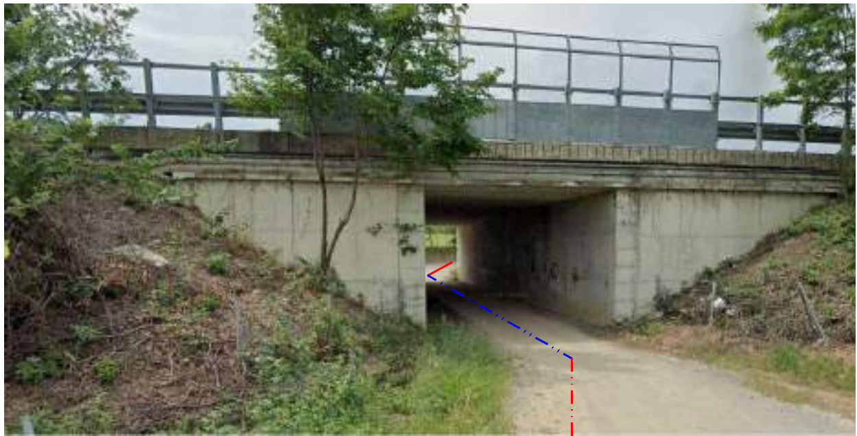
FOTOGRAFIA 62 - Attraversamento Autostrada A24 (Comune di Basciano)
