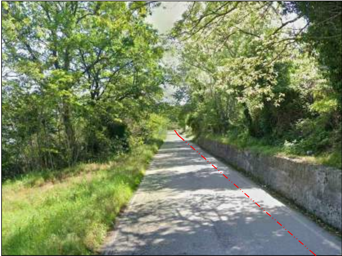
FOTOGRAFIA 65 - Via S. Giovanni (Comune di Basciano)
