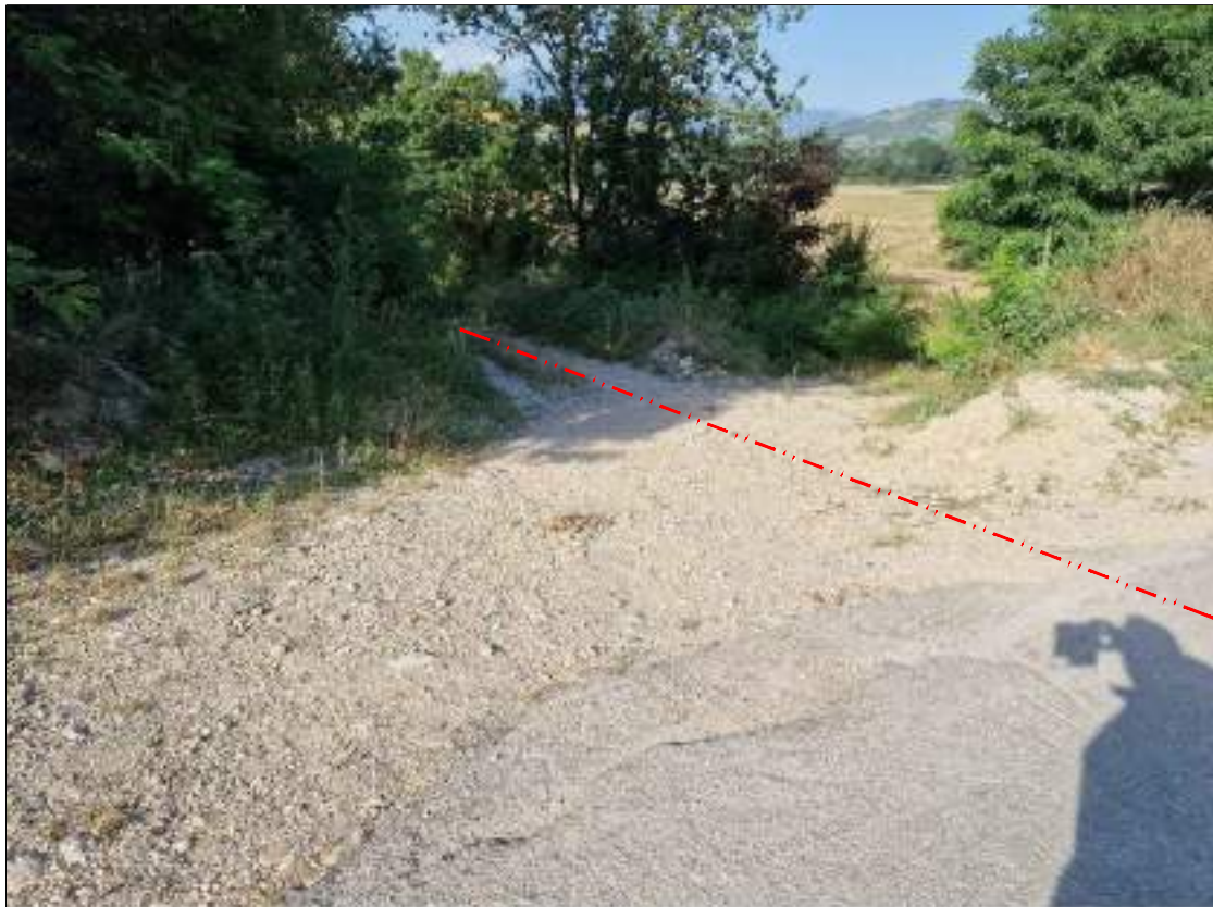
FOTOGRAFIA 14 - Strada comunale Taranta (Comune di Teramo)
