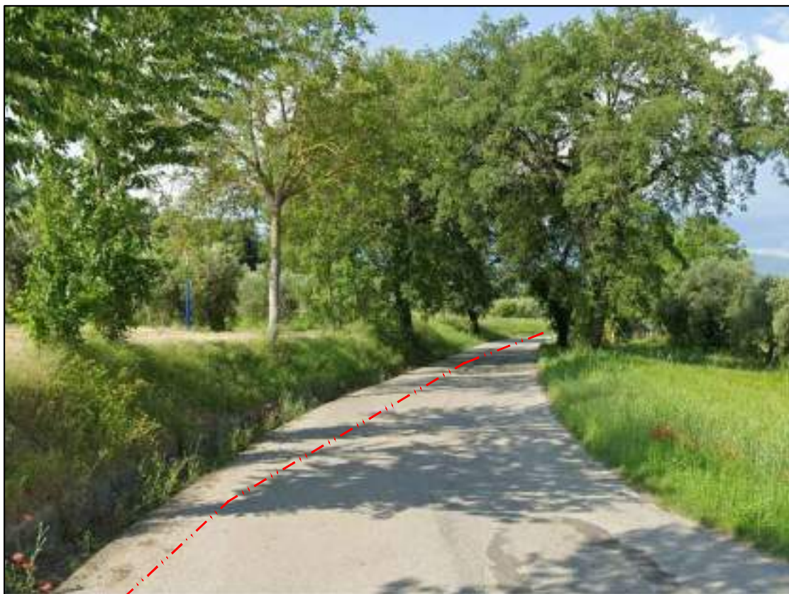
FOTOGRAFIA 64 - Via S. Giovanni (Comune di Basciano)
