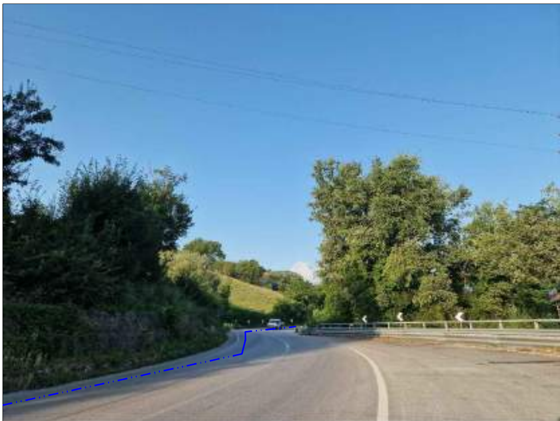
FOTOGRAFIA 48 - Strada Statale n. 150 (Comune di Montorio al Vomano)
