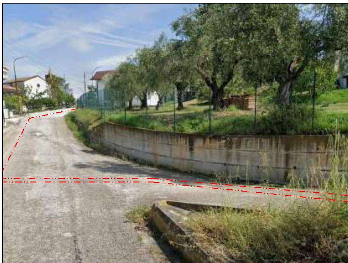
FOTOGRAFIA 74 - Strada comunale C.da S. Agostino (Comune di Basciano)
