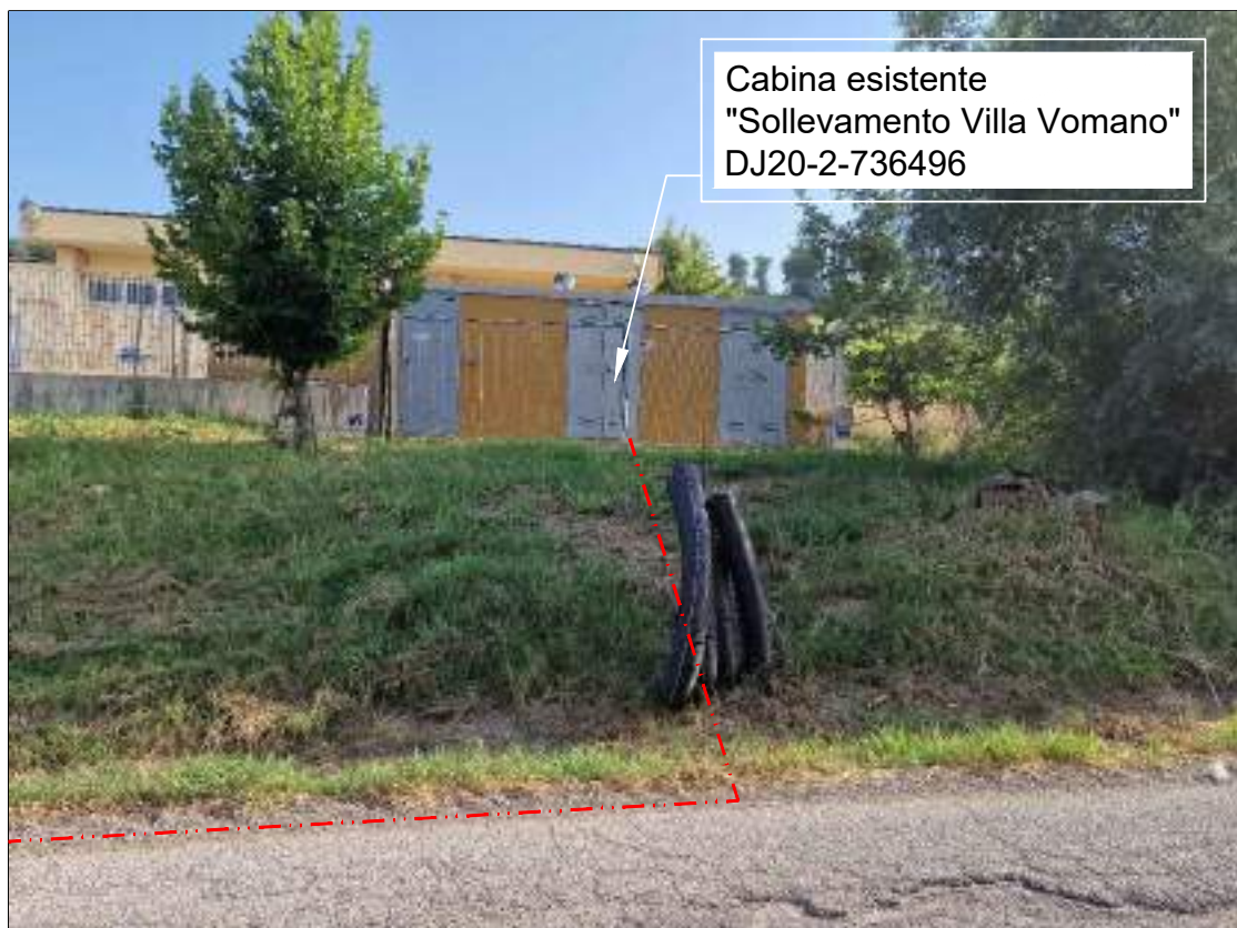
FOTOGRAFIA 20 - Strada Provinciale n. 19F (Comune di Teramo)
