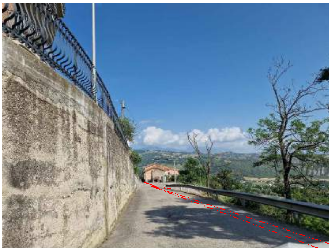
FOTOGRAFIA 68 - Strada Comunale Villa Portone (Comune di Basciano)
