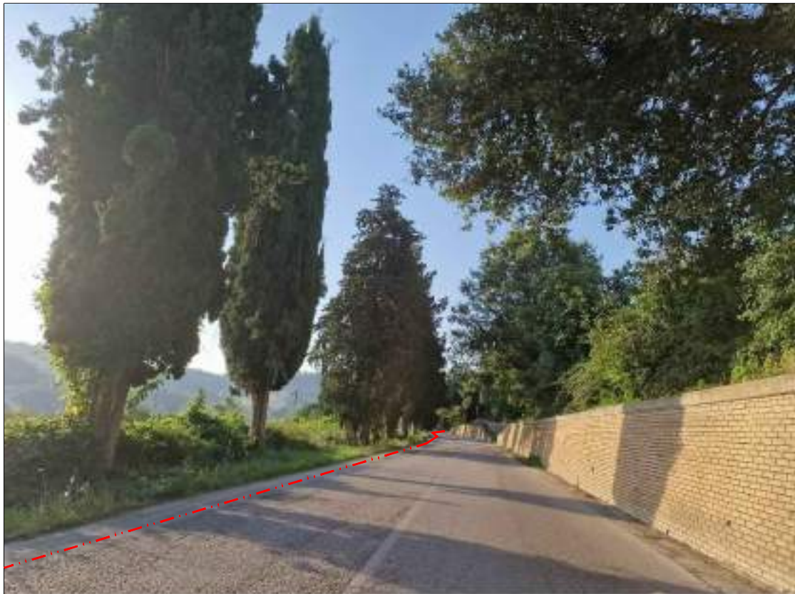
FOTOGRAFIA 56 - Strada Provinciale n. 491 (Comune di Montorio al Vomano)
