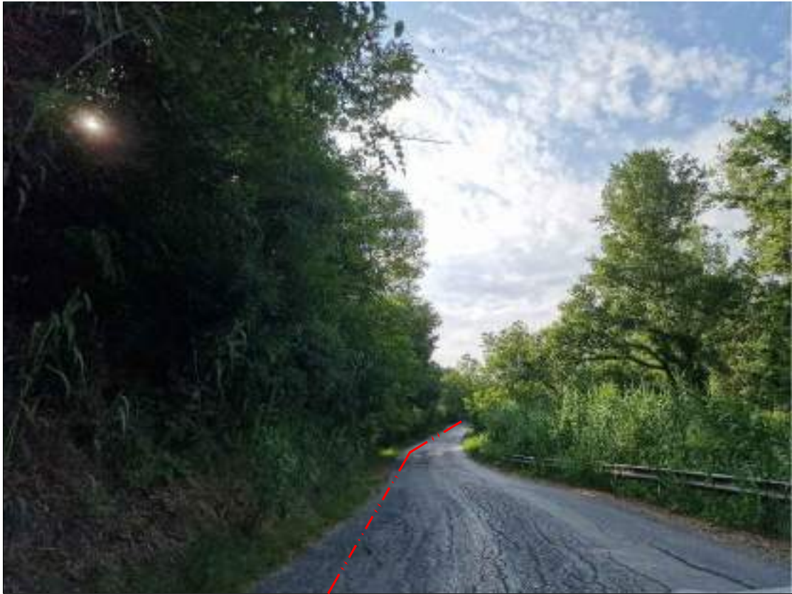
FOTOGRAFIA 17 - Strada Provinciale n. 19F (Comune di Teramo)
