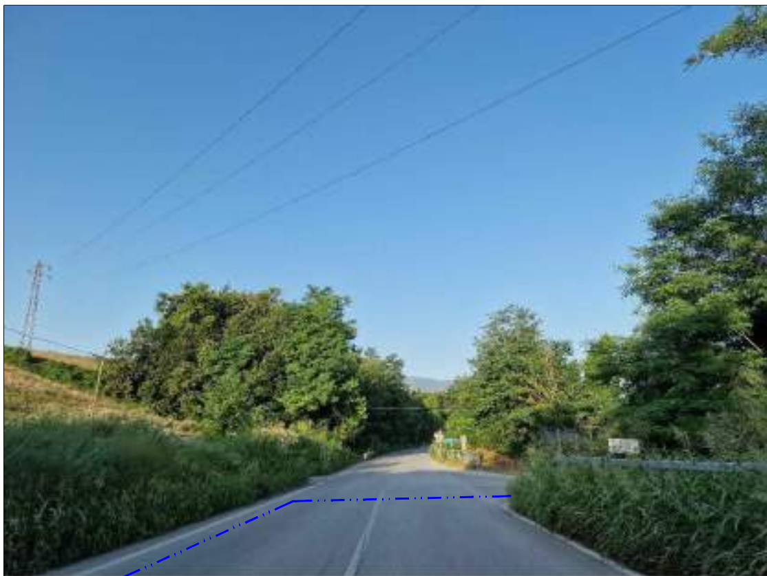
FOTOGRAFIA 50 - Strada Statale n. 150 incrocio Strada comunale per Rapino (Comune di Montorio al Vomano)
