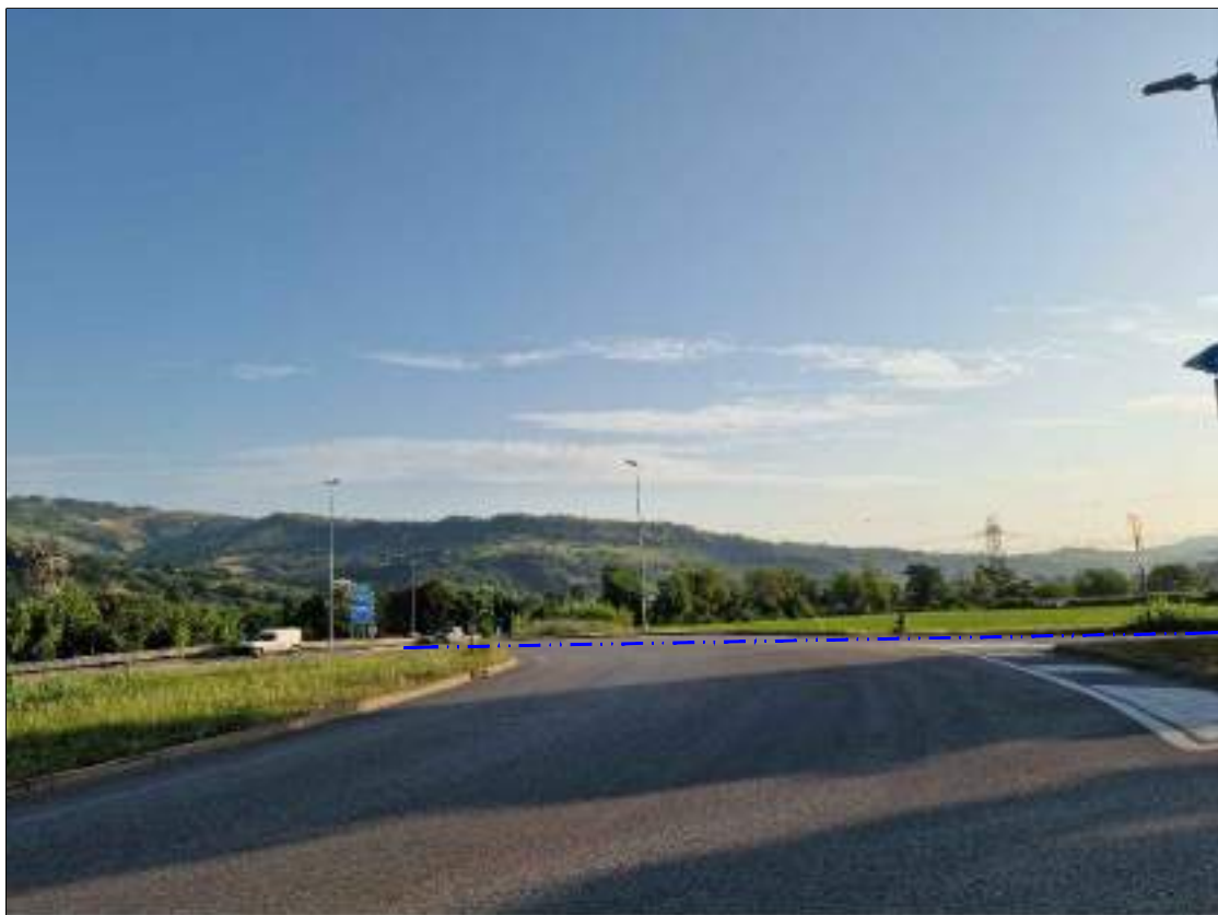
FOTOGRAFIA 54 - Strada Statale n. 150 (Comune di Montorio al Vomano)
