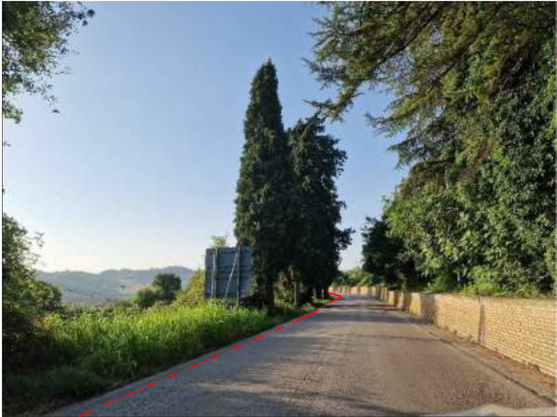
FOTOGRAFIA 55 - Strada Provinciale n. 491 (Comune di Montorio al Vomano)
