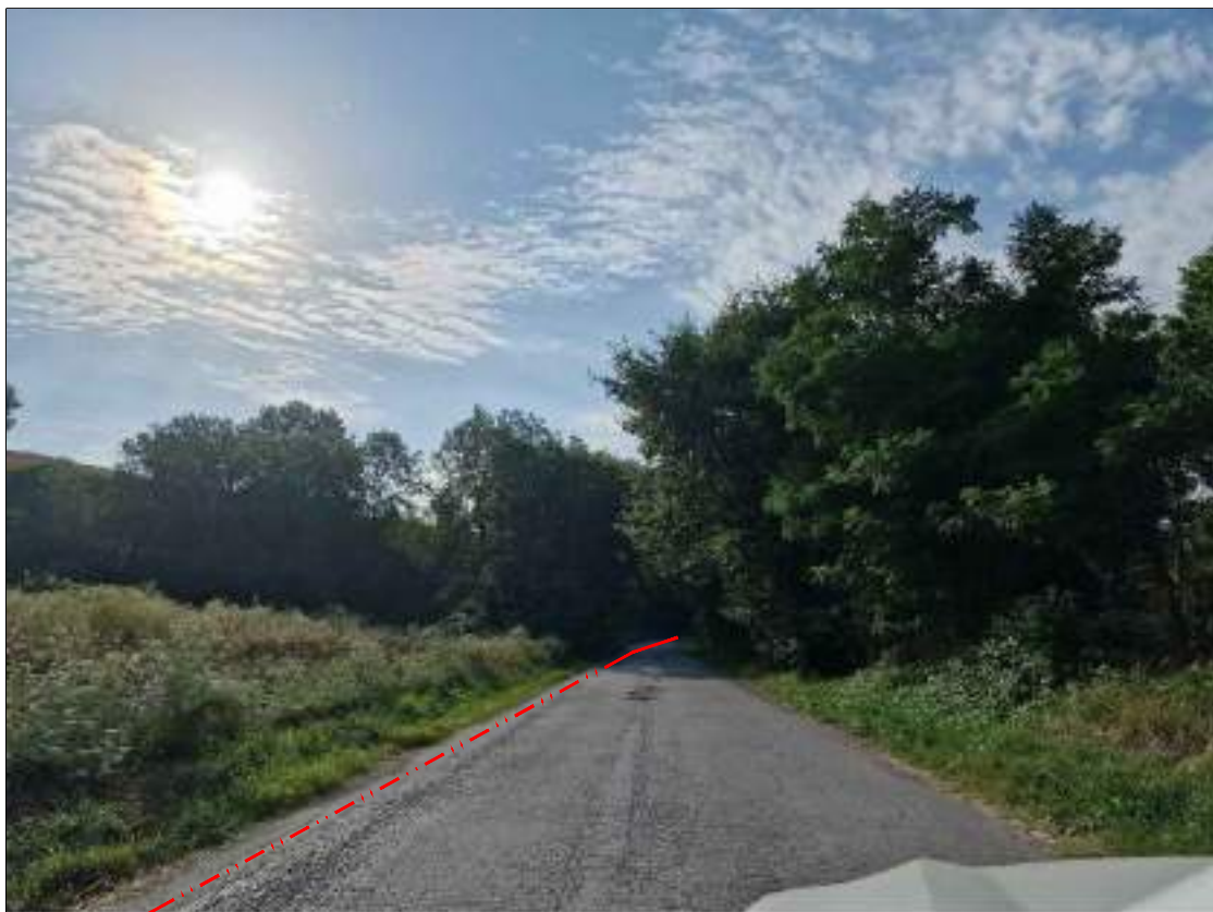
FOTOGRAFIA 16 - Strada Provinciale n. 19F (Comune di Teramo)
