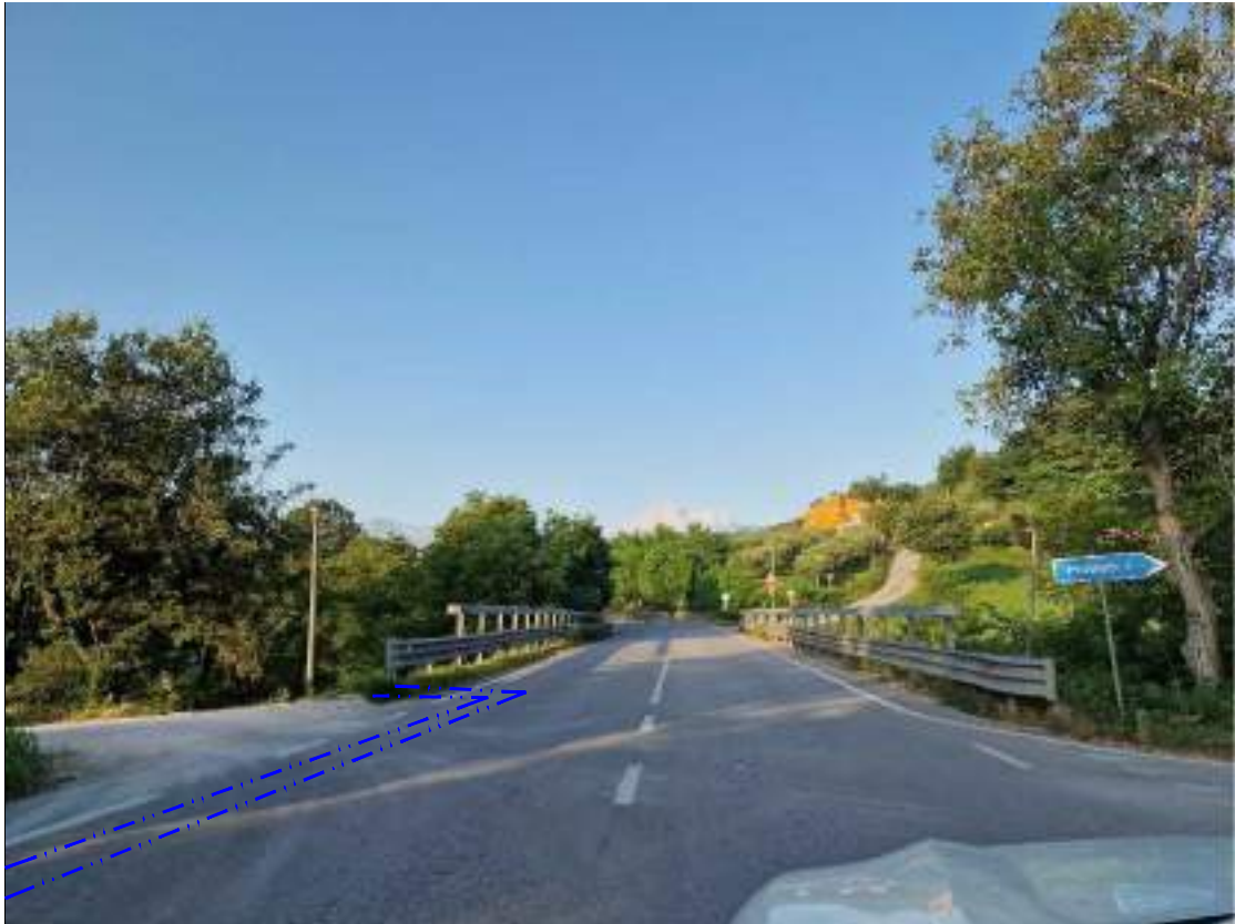
FOTOGRAFIA 41 - Strada Statale n. 150 (Comune di Teramo)
