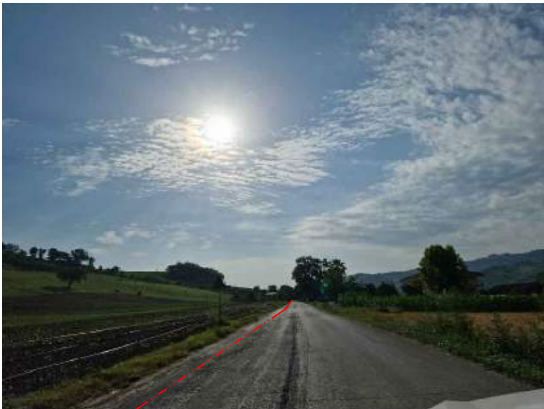
FOTOGRAFIA 18 - Strada Provinciale n. 19F (Comune di Teramo)
