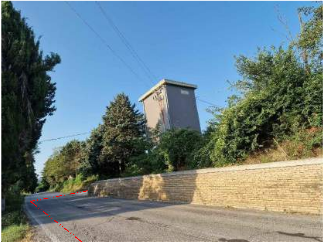
FOTOGRAFIA 57 - Strada Provinciale n. 491 (Comune di Basciano)
