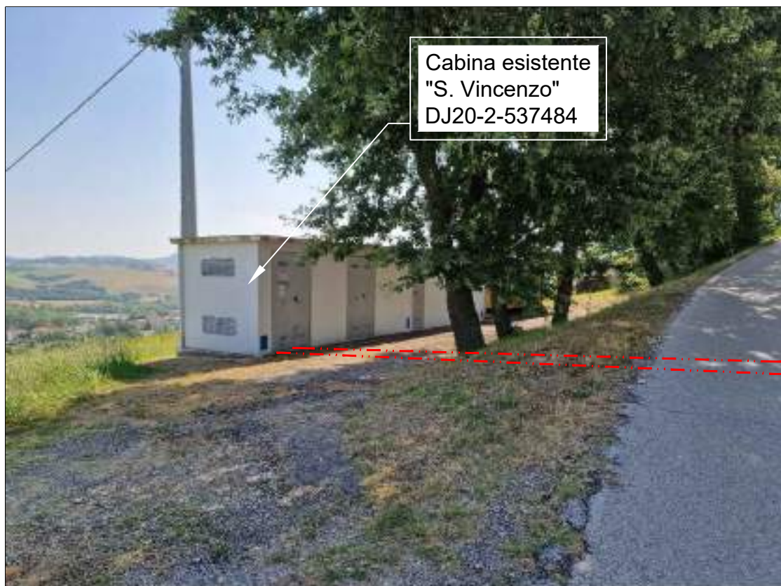
FOTOGRAFIA 66 - Via S. Giovanni (Comune di Basciano)
