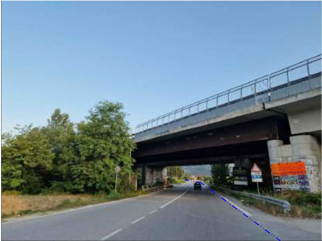
FOTOGRAFIA 23 - Strada Statale n. 150 (Comune di Basciano)
