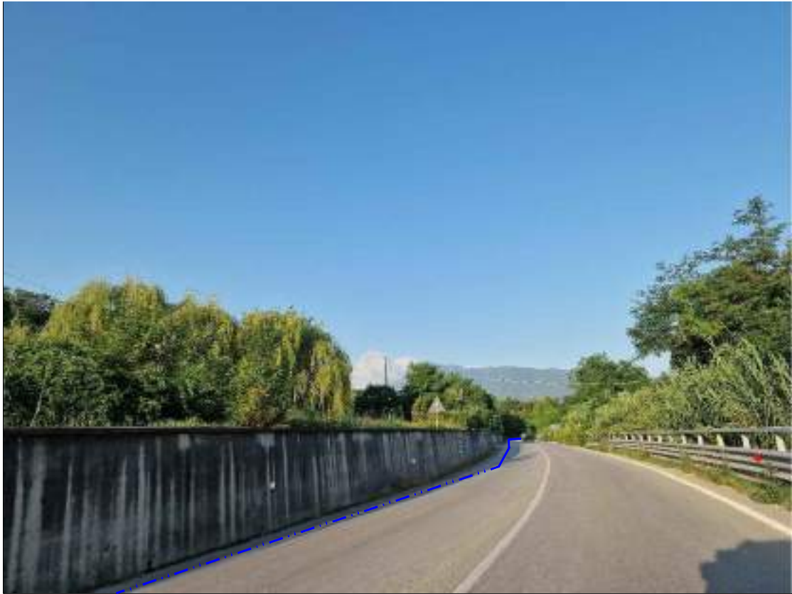
FOTOGRAFIA 49 - Strada Statale n. 150 (Comune di Montorio al Vomano)
