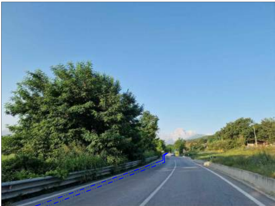
FOTOGRAFIA 40 - Strada Statale n. 150 (Comune di Teramo)
