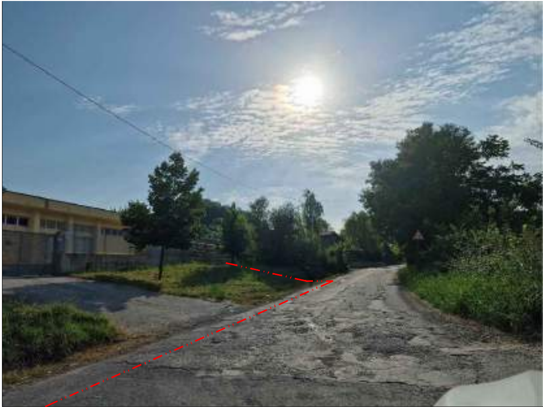
FOTOGRAFIA 19 - Strada Provinciale n. 19F (Comune di Teramo)
