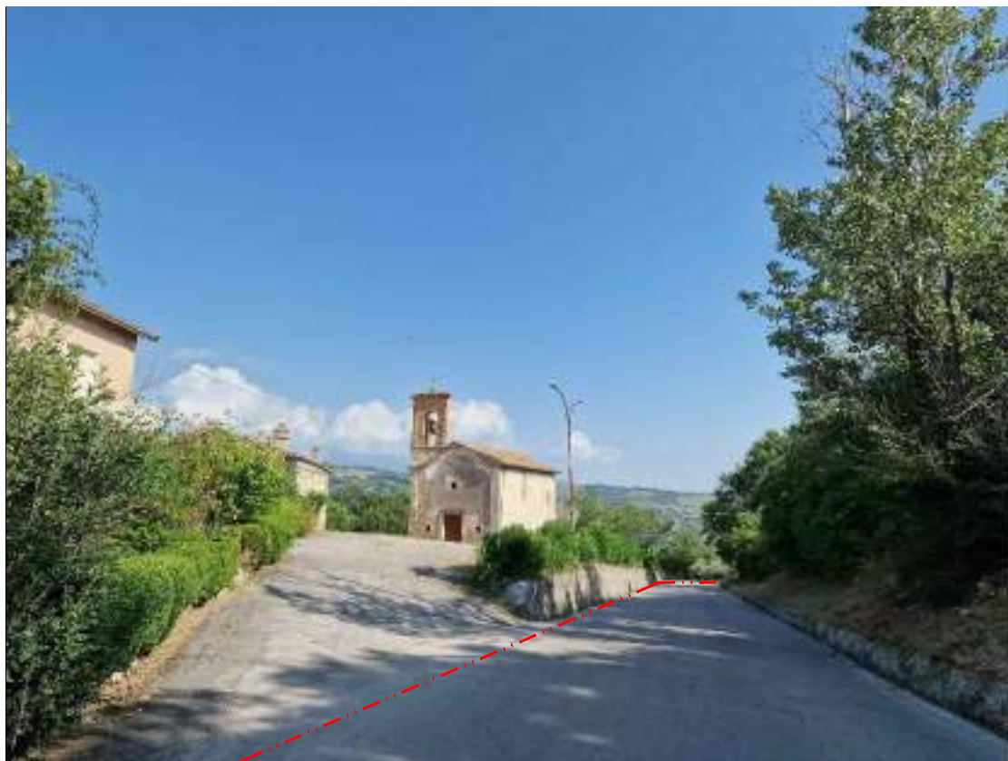
FOTOGRAFIA 67 - Via S. Giovanni (Comune di Basciano)
