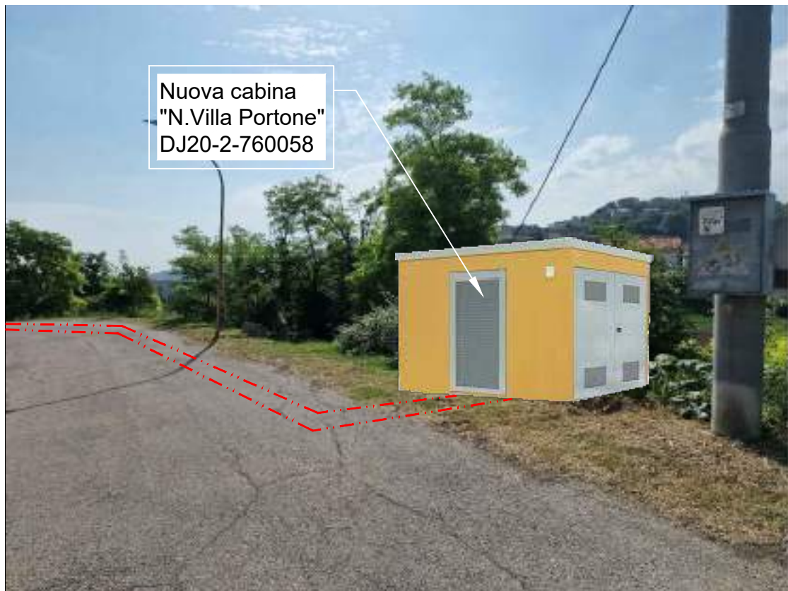
FOTOGRAFIA 69 - Strada Comunale Villa Portone (Comune di Basciano)
