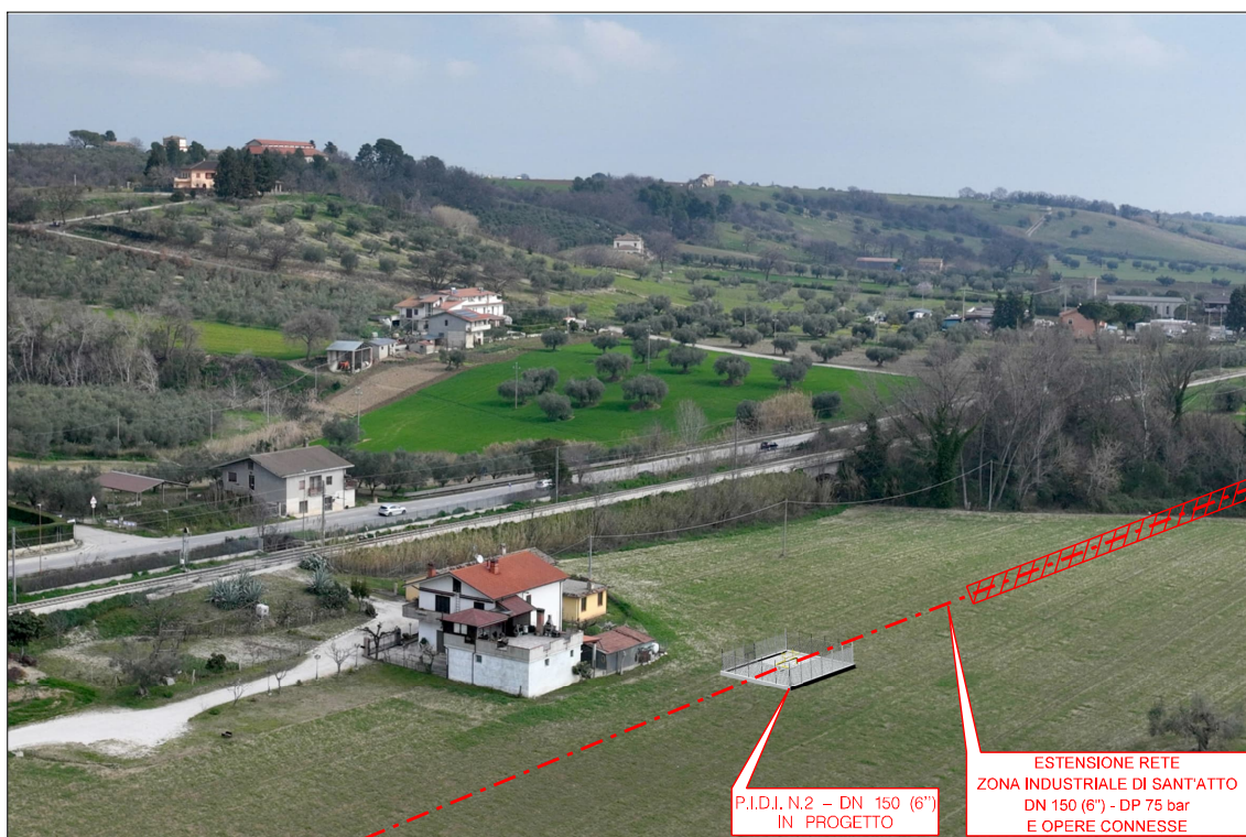
FOTO 6: P.I.D.I n.2 DN 150 POST OPERAM
