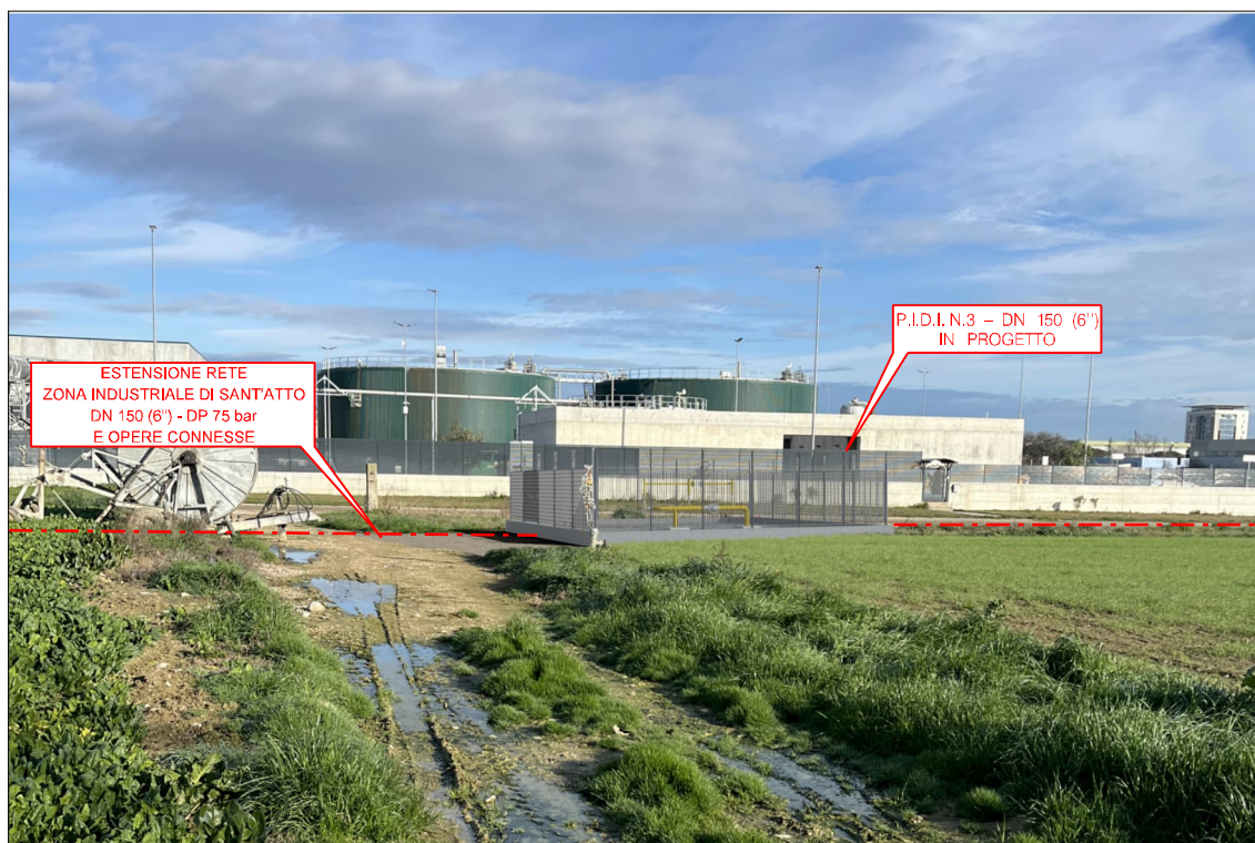
FOTO 8: P.I.D.I n.3 DN 150 POST OPERAM
