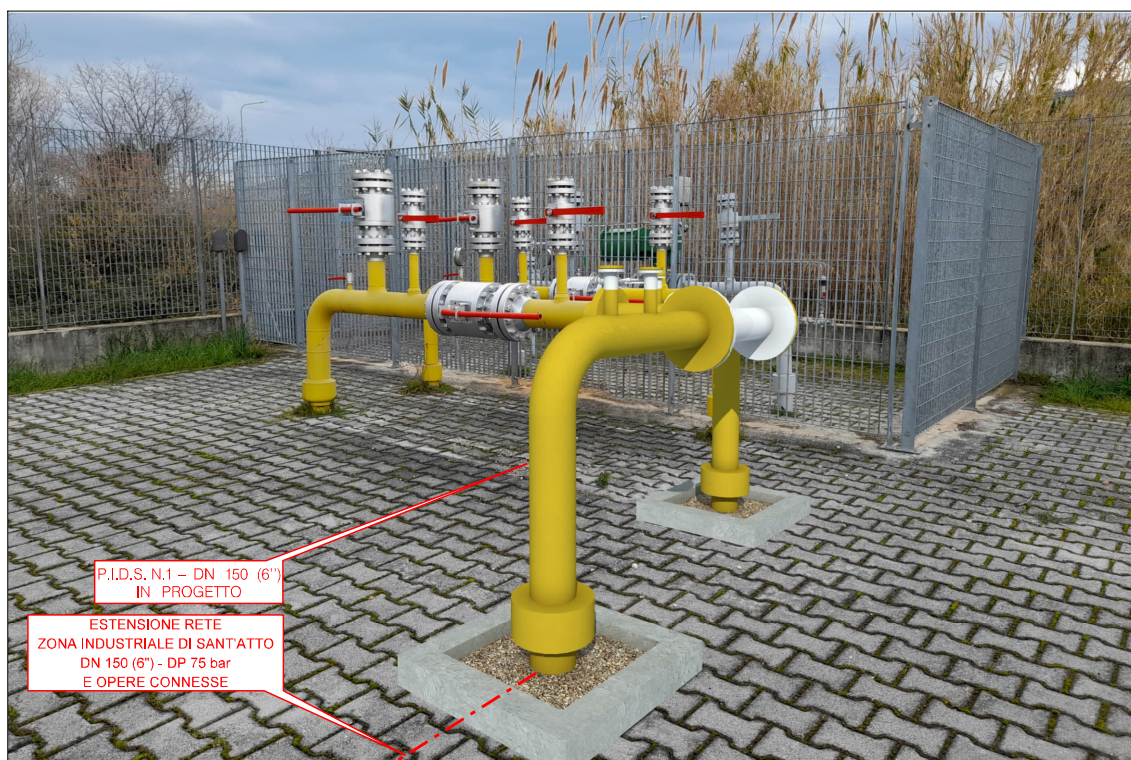
FOTO 2: P.I.D.I n.1 DN 150 POST OPERAM
