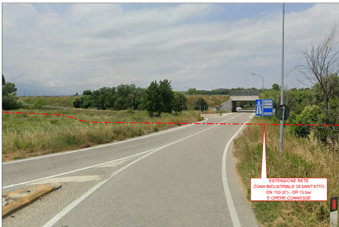
FOTO 18: Attraversamento Svincolo S.S. N. 80 Racc. "Superstrada Teramo - Mare"
