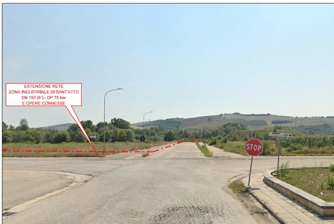
FOTO 32: Attraversamento strada di collegamento area industriale vista da Via del Lavoro
