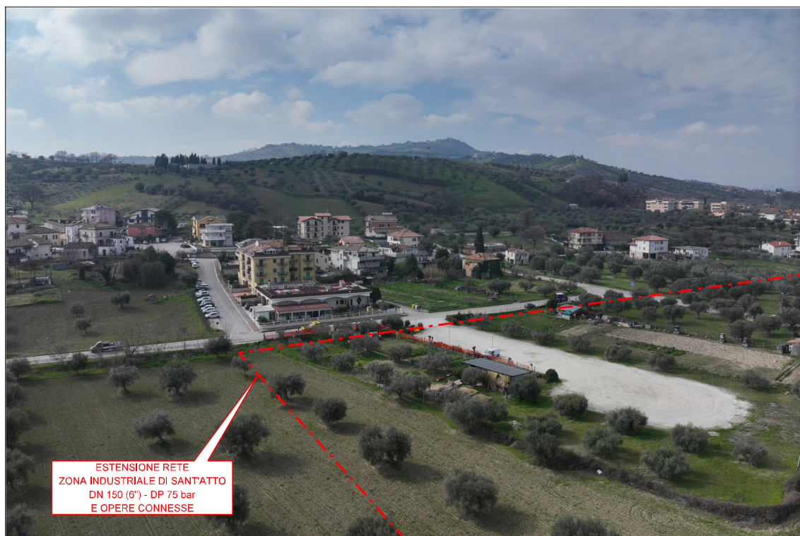
FOTO 14: Parallelismo Strada Provinciale N.25a
