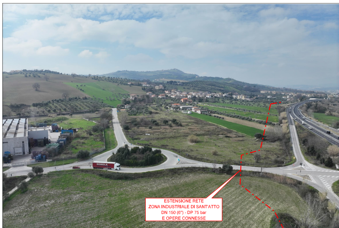
FOTO 17: Attraversamento svincolo S.S. N.80 Racc. "Superstrada Teramo - Mare"
