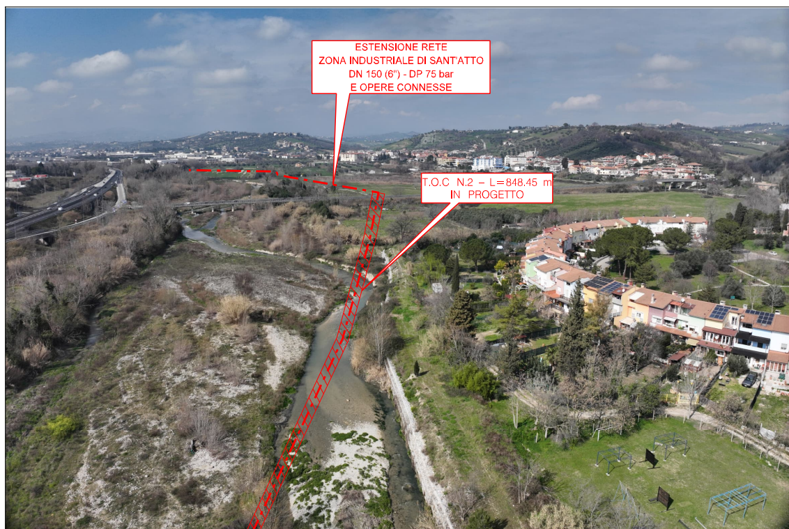
FOTO 10: Primo Attraversamento Fiume Tordino mediante Trivellazione Orizzontale Controllata (T.O.C. N.2 - L=856m)
