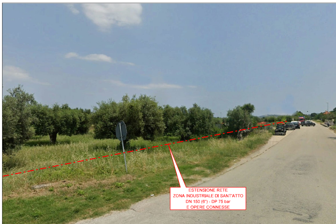
FOTO 12: Parallelismo Strada Provinciale N.25a
