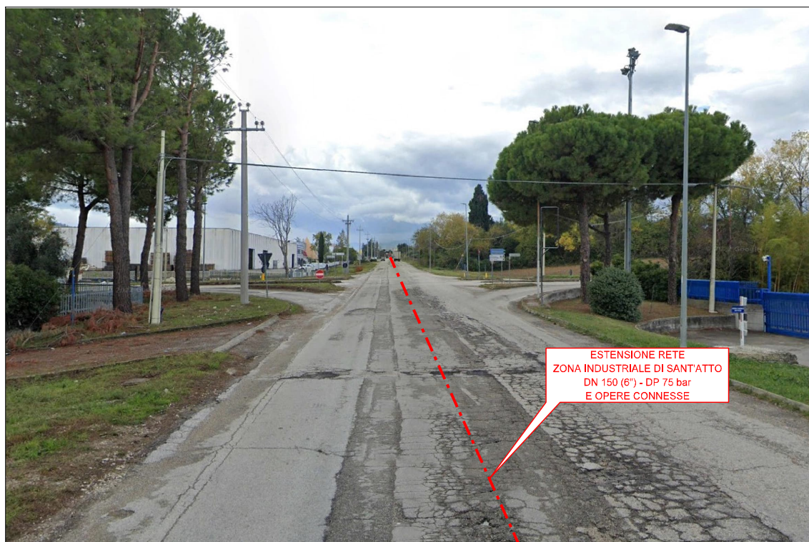
FOTO 4: Percorrenza in Via Prosepro Celli
