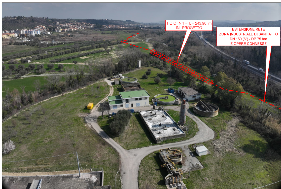
FOTO 7: Attraversamento Torrente Mazzone mediante Trivellazione Orizzontale Controllata (T.O.C. N.1 - L=250m) e parallelismo con impianto depurazione delle acque reflue
