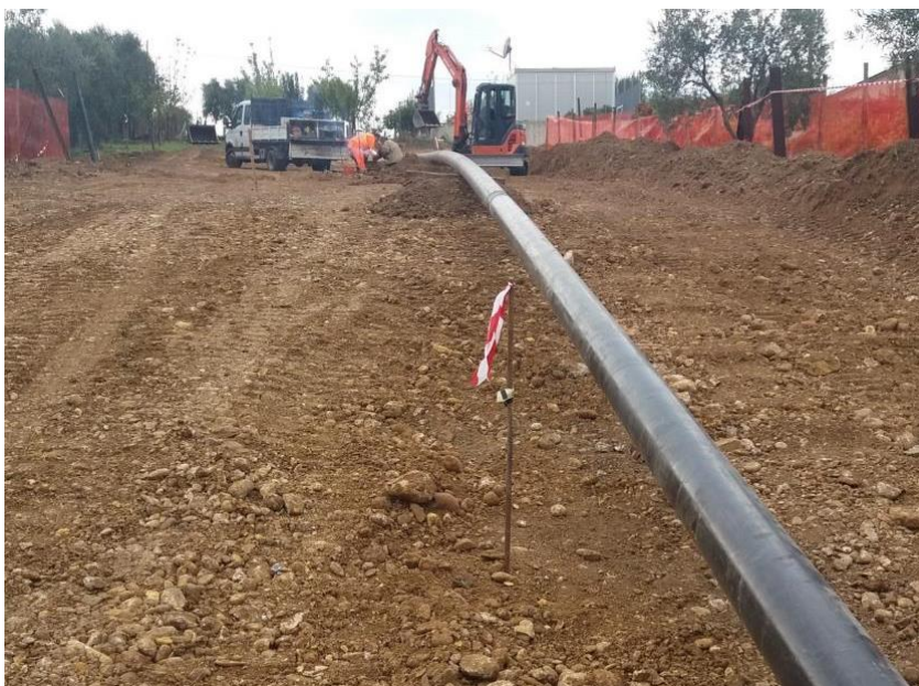
Fig. 6.5.1 - Saldatura della tubazione
