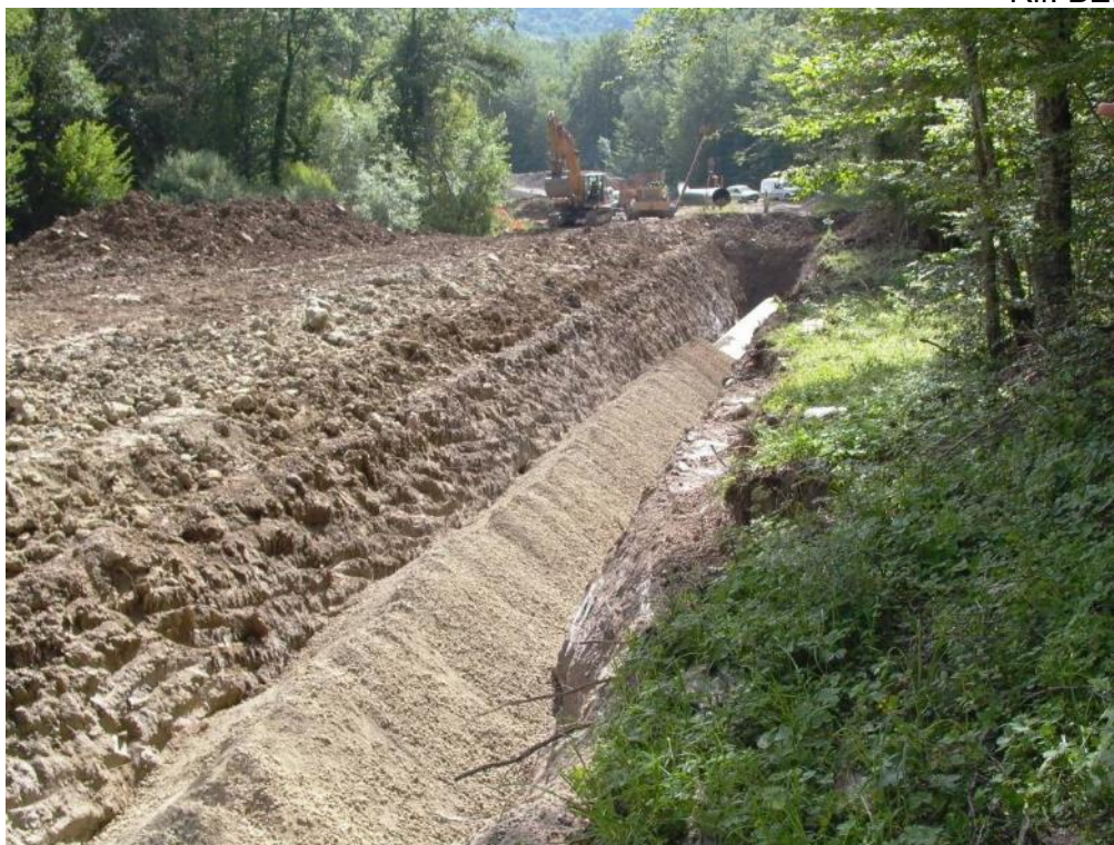
Fig. 6.12.1 – Posa e rinterro della condotta.
