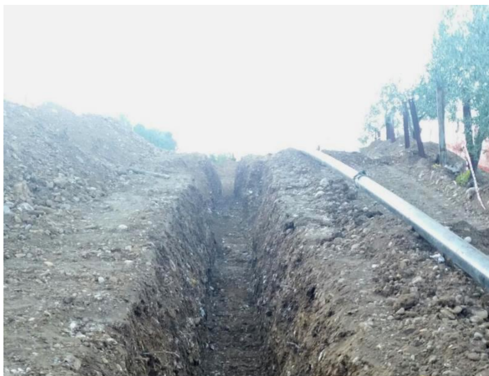
Fig. 6.7.1 - Scavo della trincea
