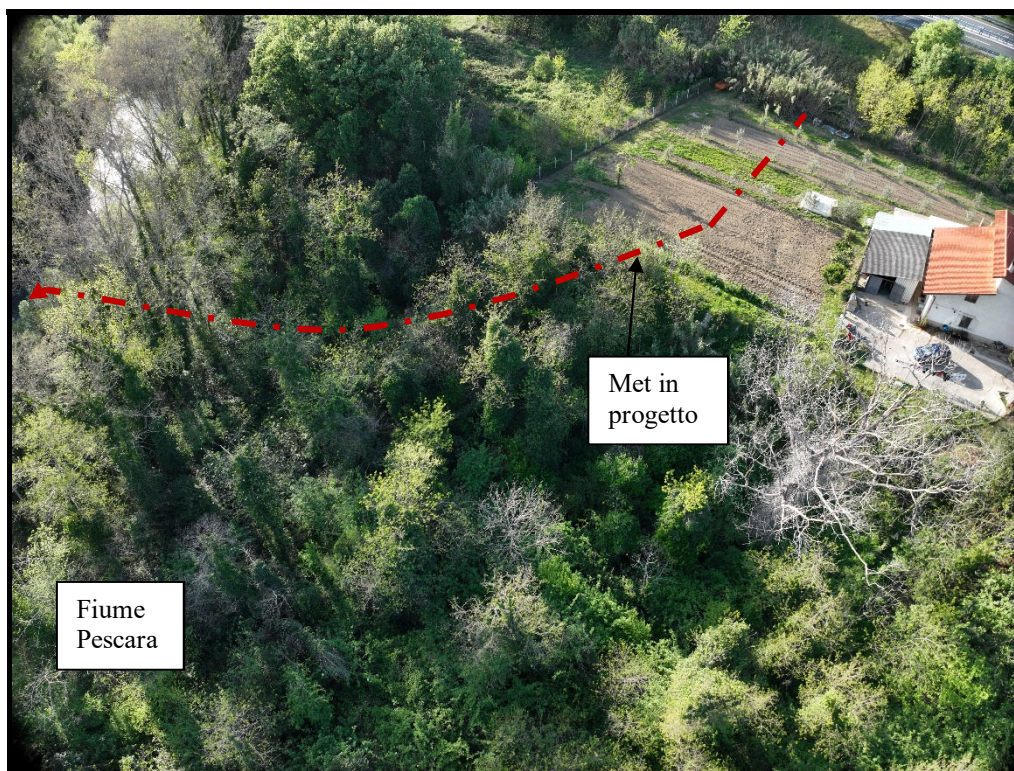
Figura 3 Vista del metanodotto in progetto in attraversamento Fiume Pescara (attraversamento in T.O.C.).
