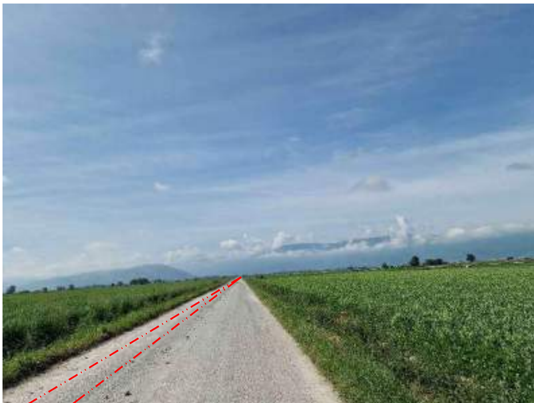
FOTOGRAFIA 18 - Strada 13 (Comune di Celano)
