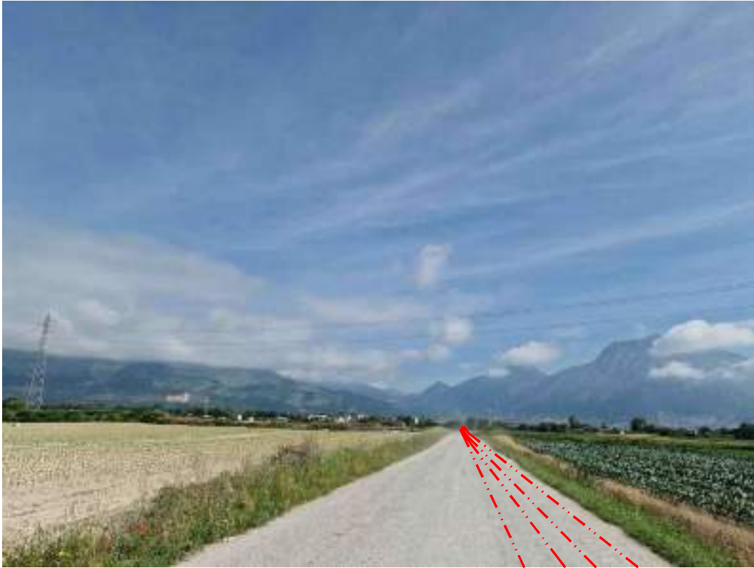
FOTOGRAFIA 27 - Strada 13 (Comune di Celano)
