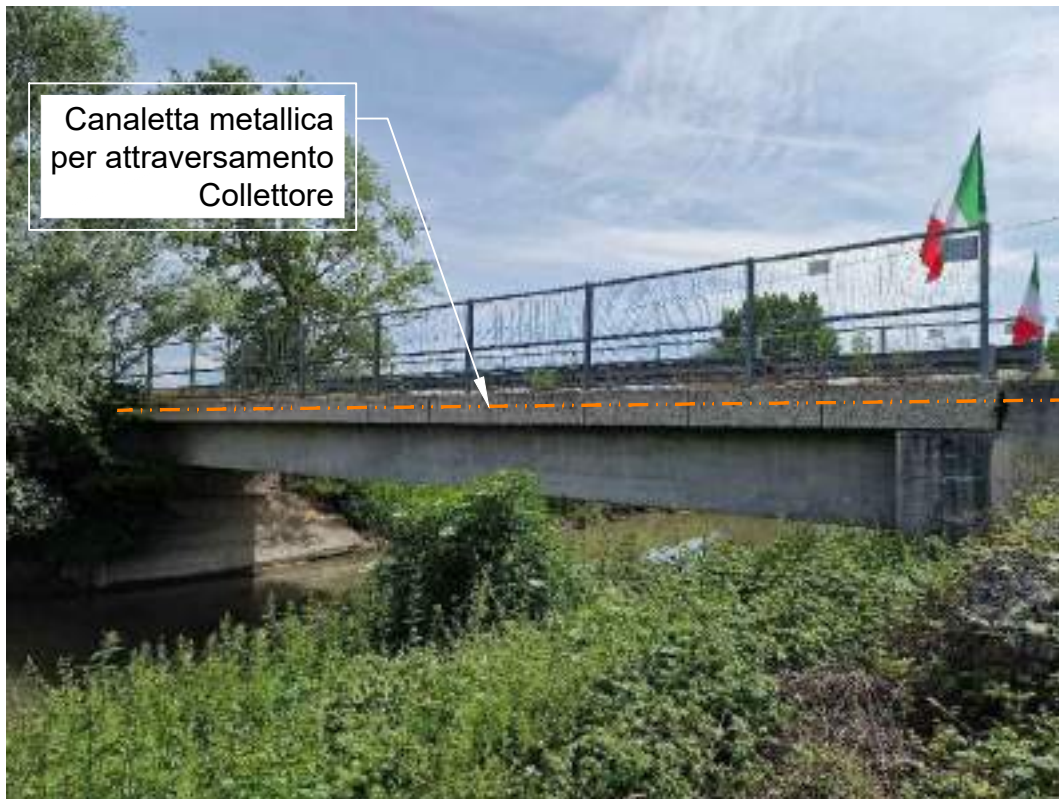
FOTOGRAFIA 5 - Attraversamento Collettore (Comuni di Luco dei Marsi ed Avezzano)
