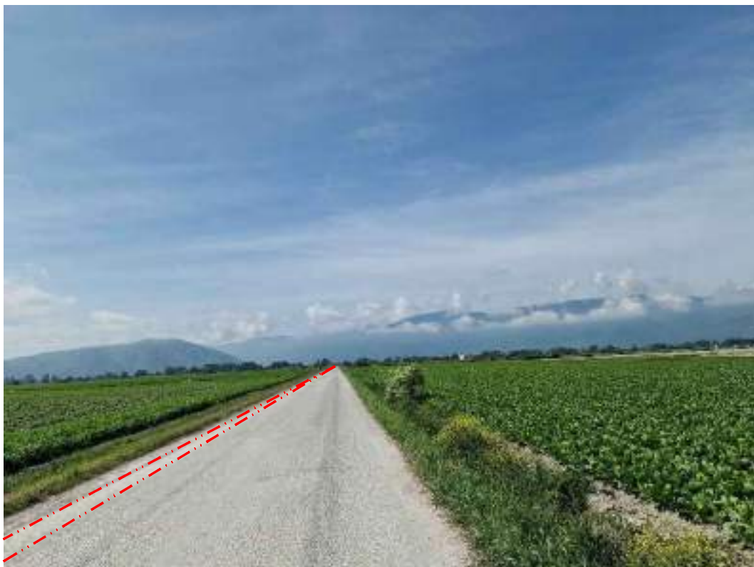
FOTOGRAFIA 14 - Strada 13 (Comune di Celano)
