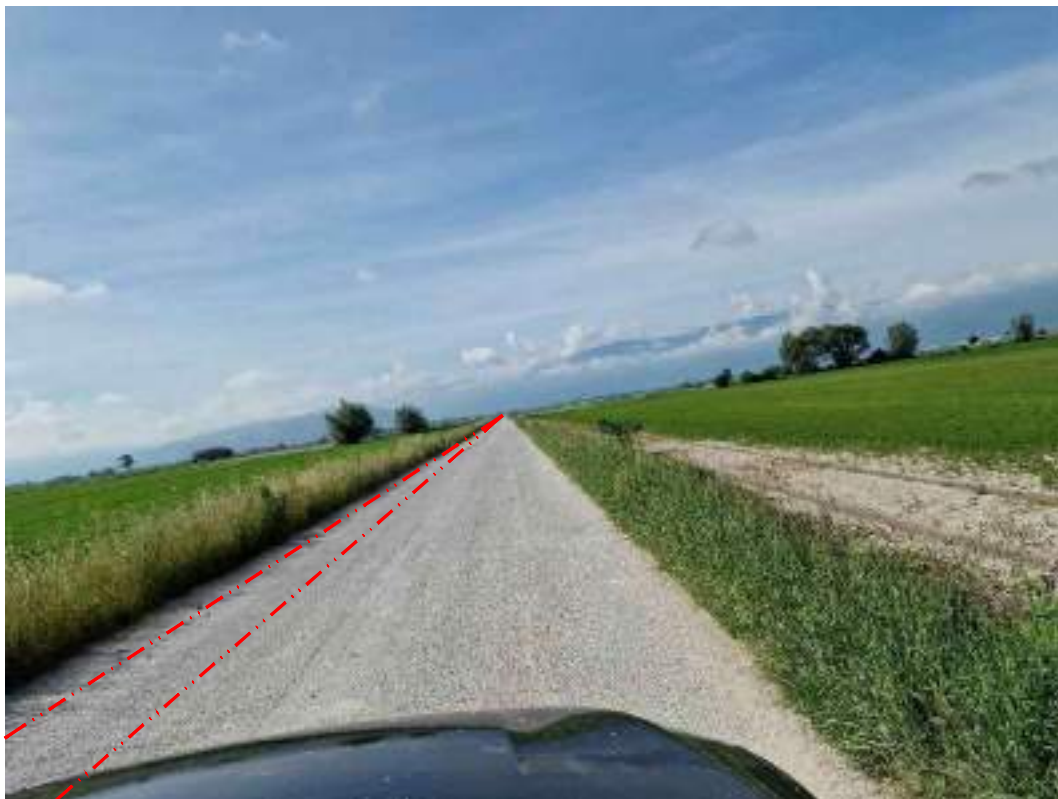
FOTOGRAFIA 19 - Strada 13 (Comune di Celano)
