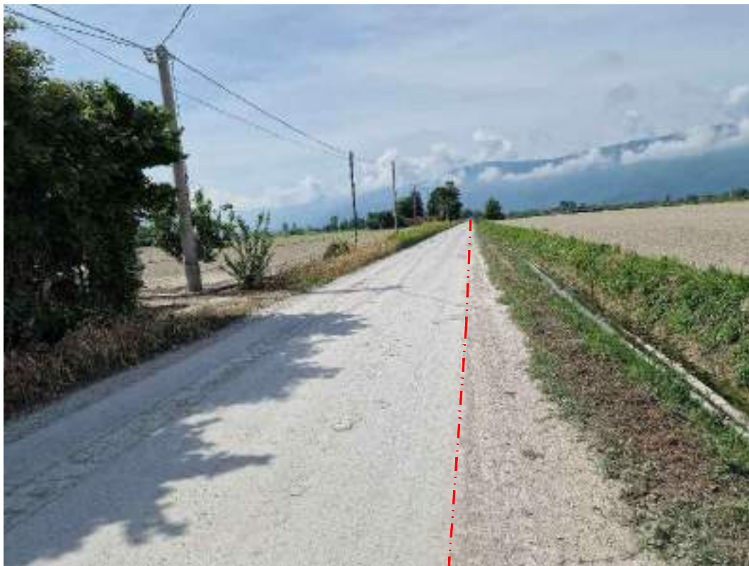
FOTOGRAFIA 11 - Strada 11 (Comune di Avezzano)
