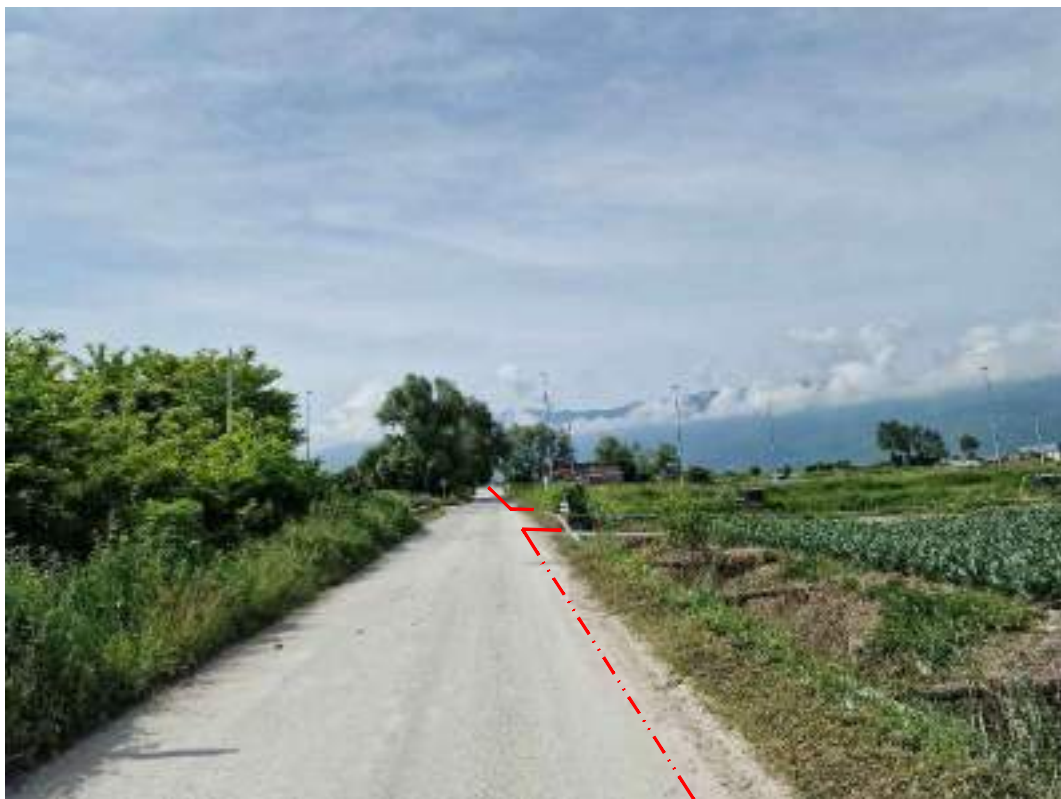
FOTOGRAFIA 8 - Strada 11 (Comune di Avezzano)
