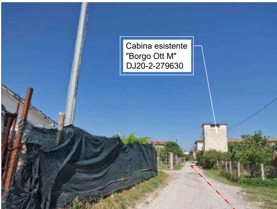
FOTOGRAFIA 50 - Via Collelongo (Comune di Celano)
