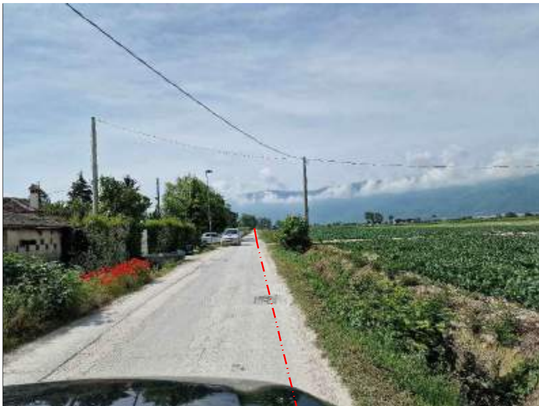
FOTOGRAFIA 9 - Strada 11 (Comune di Avezzano)
