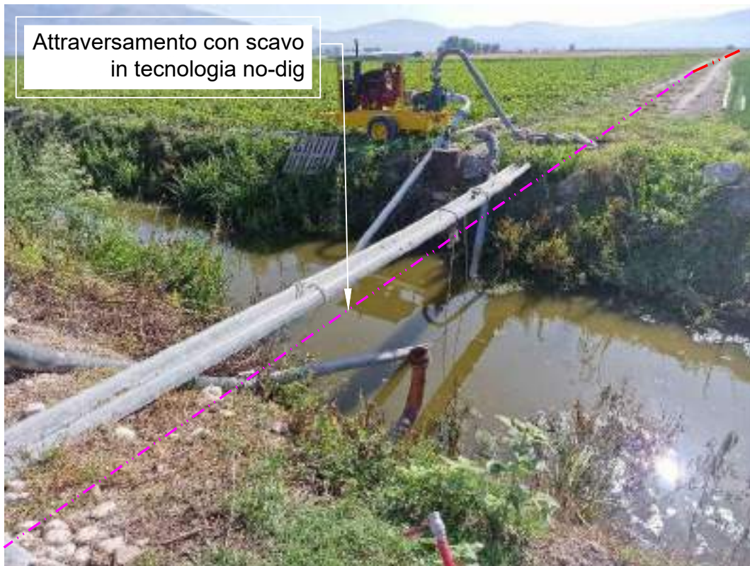
FOTOGRAFIA 43 - Attraversamento canale d'irrigazione (Comune di Celano)
