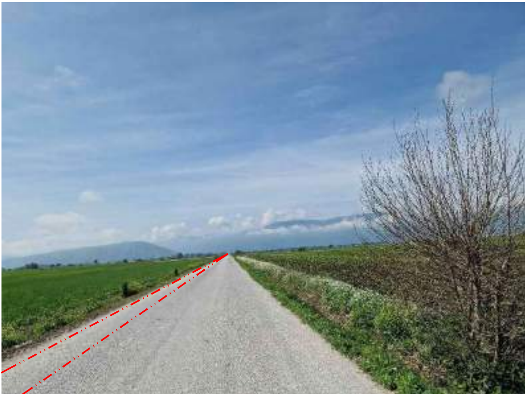
FOTOGRAFIA 16 - Strada 13 (Comune di Celano)
