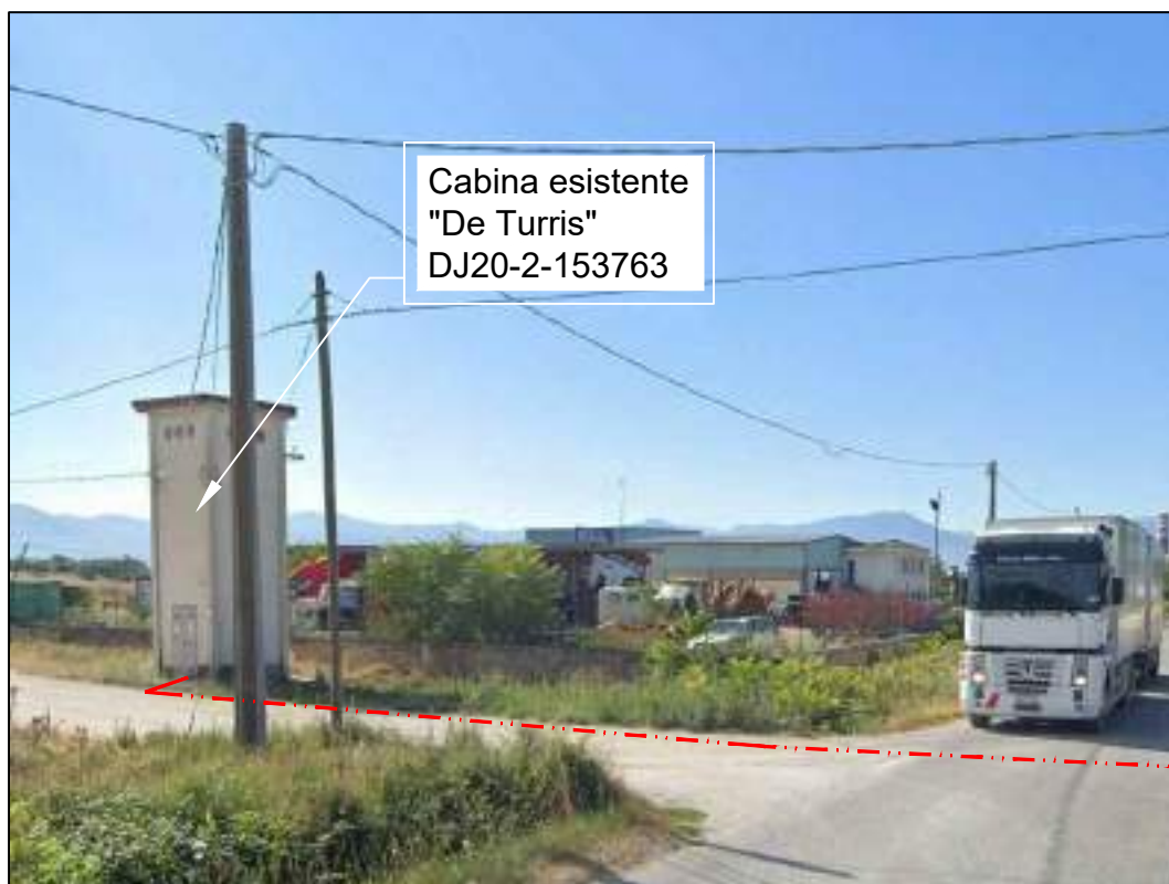
FOTOGRAFIA 57 - Strada Provinciale n. 19 incrocio via della Torre (Comune di Celano)
