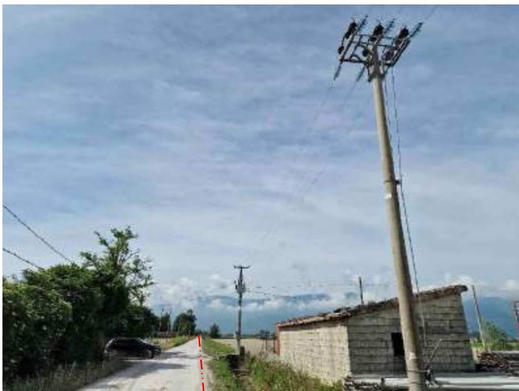
FOTOGRAFIA 12 - Strada 11 (Comune di Avezzano)
