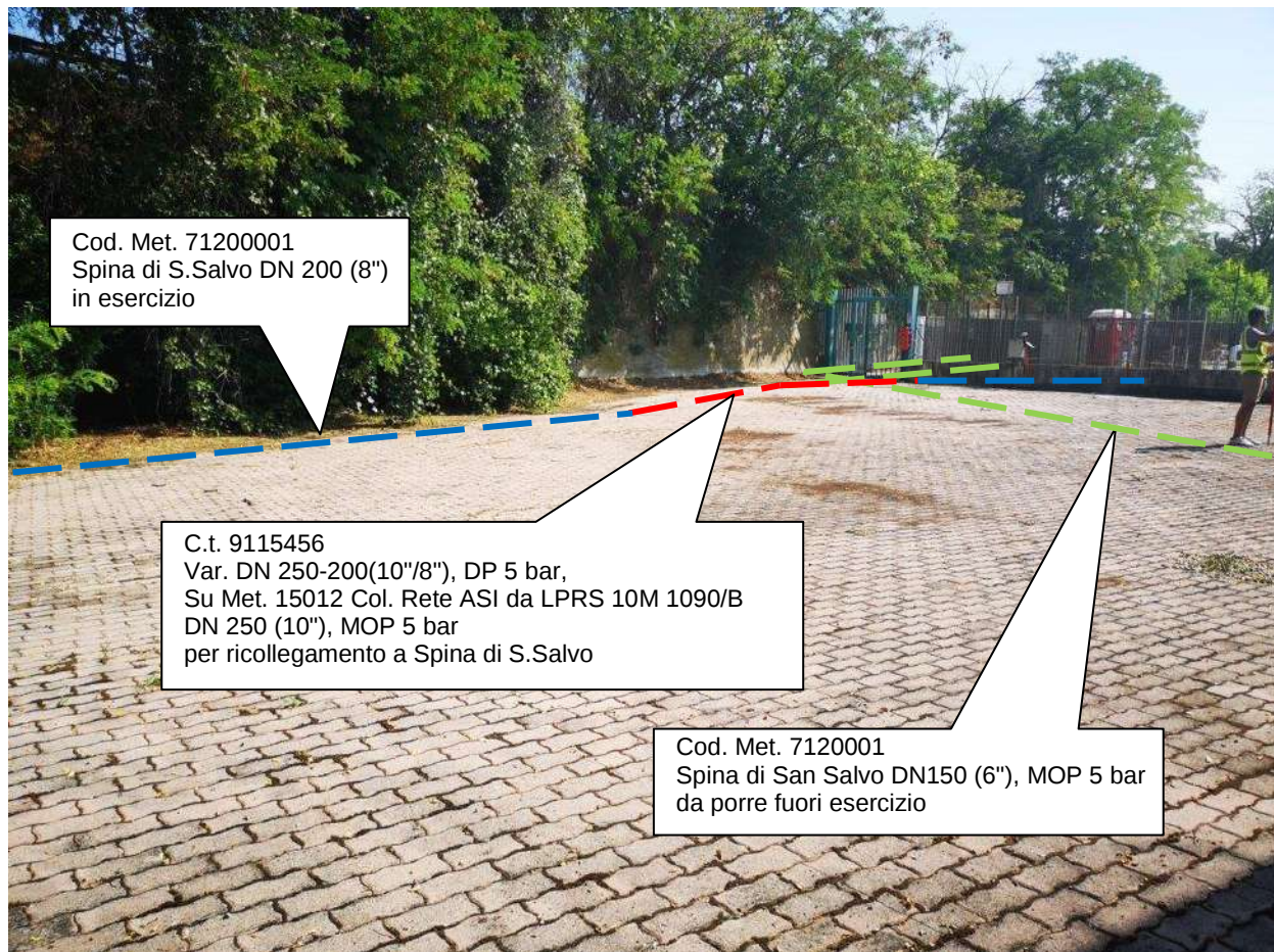
Foto 17 – collegamento metanodotto N.15012 col metanodotto N.7120001
