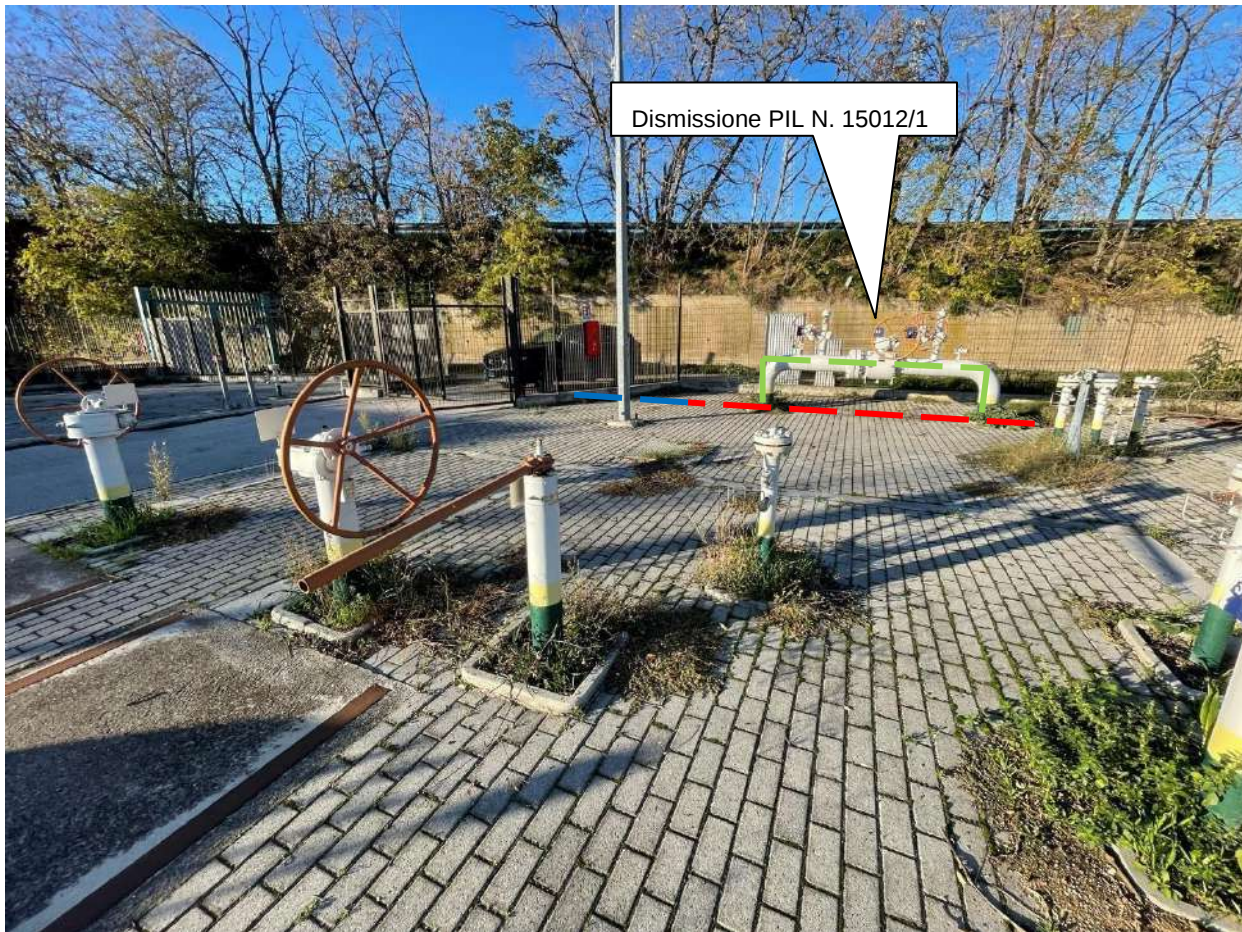
Foto 14 – ricollegamento al metanodotto DN 250 esistente – dismissione PIL N. 15012/1
