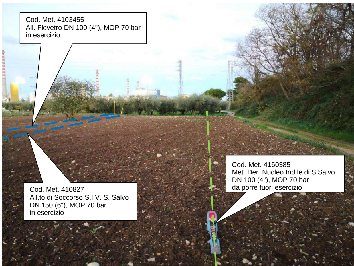
Foto 2 – dismissione metanodotto 4160385
