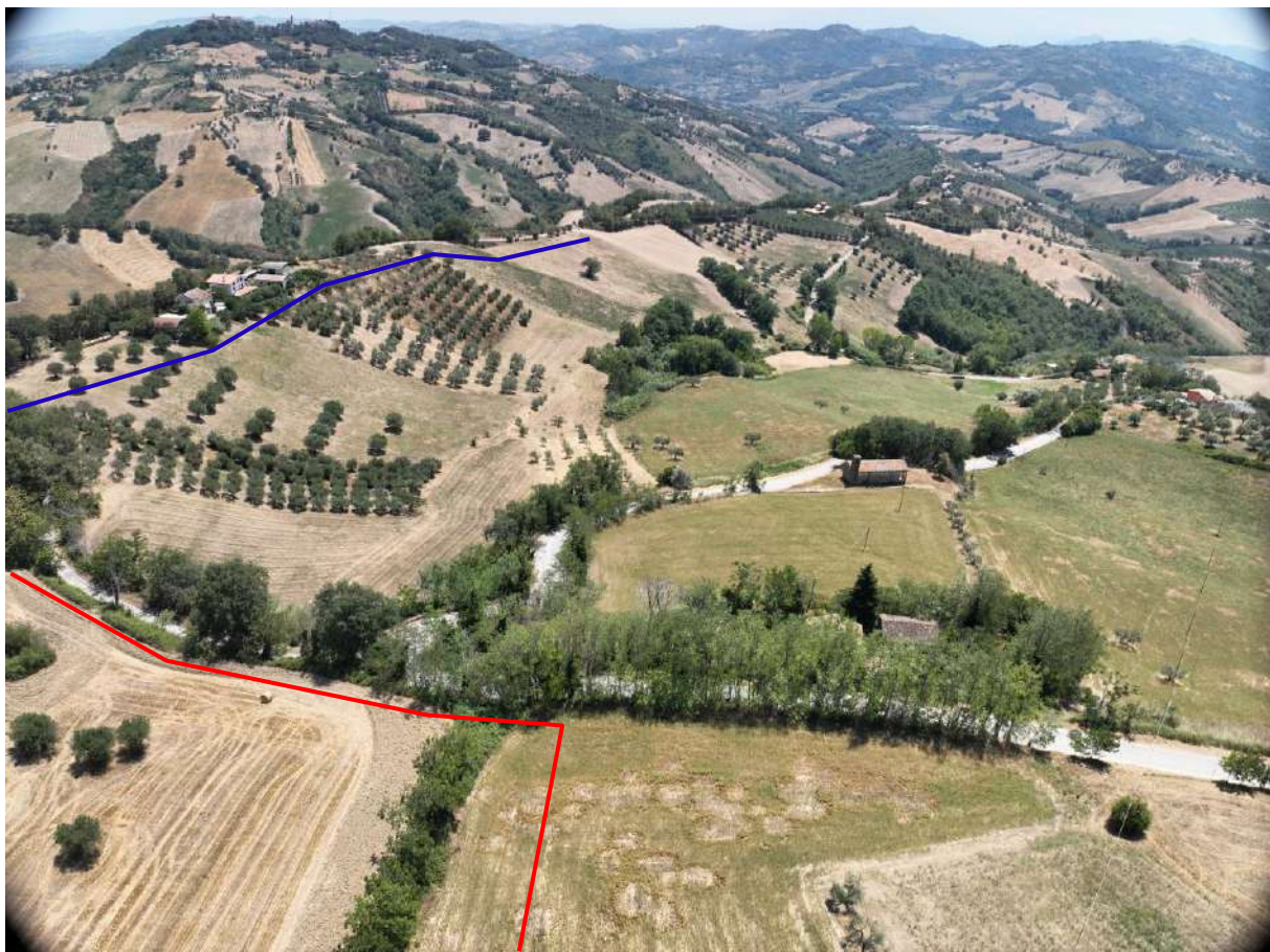
Foto 9: Percorrenza tratto terminale variante in progetto in Comune di Teramo
