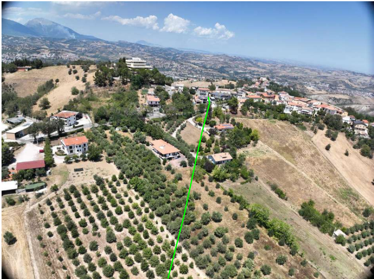
Foto 4: Tratto in dismissione in Comune di Teramo fraz. Poggio Cono
