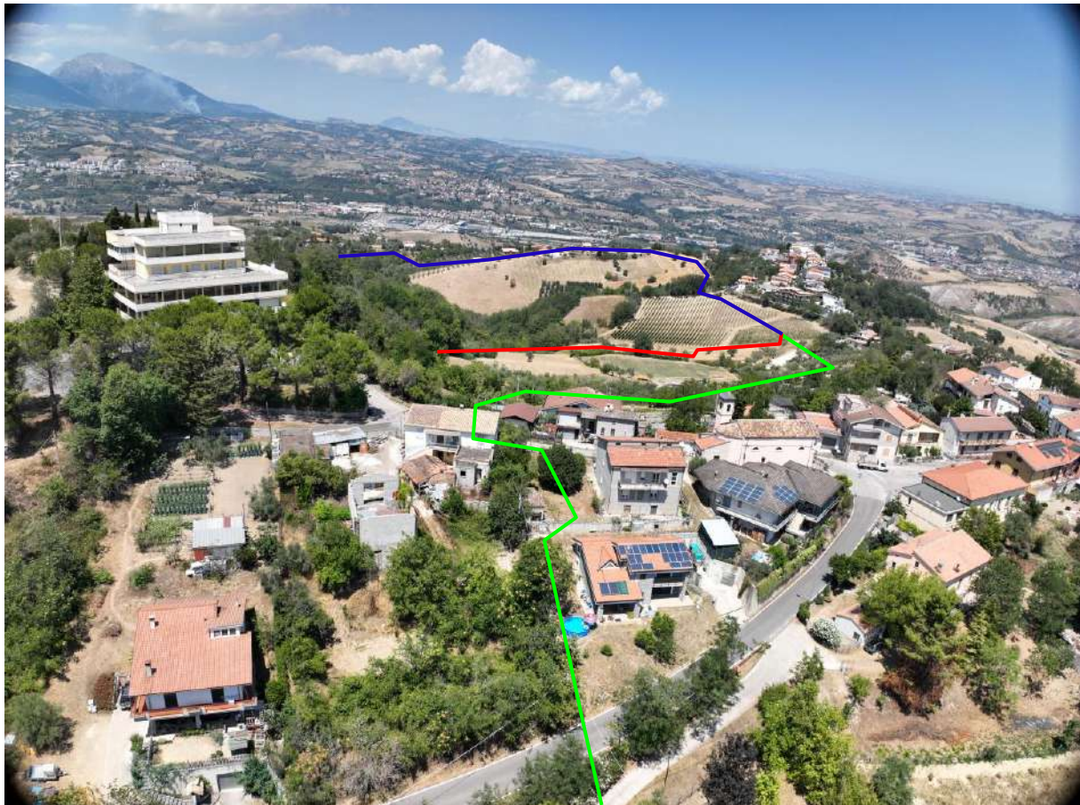
Foto 3 : Tratto in dismissione in Comune di Teramo fraz. Poggio Cono
