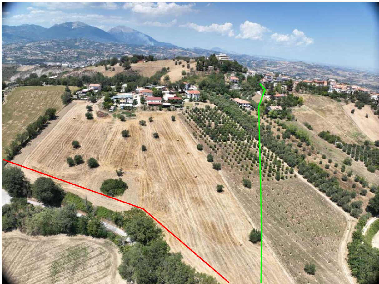
Foto 5: Tratto finale in dismissione in Comune di Teramo
