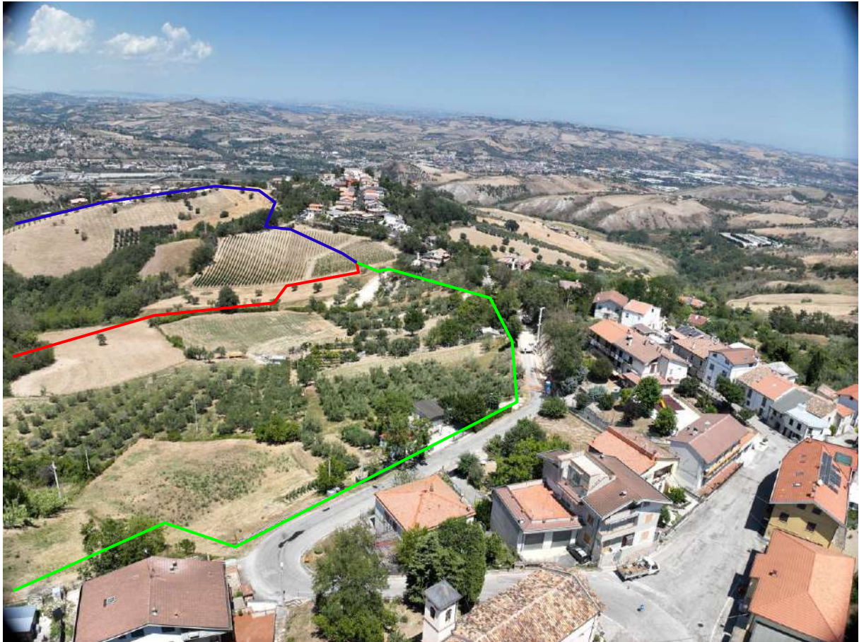
Foto 2: Tratto in dismissione lungo SP75 in Comune di Teramo
