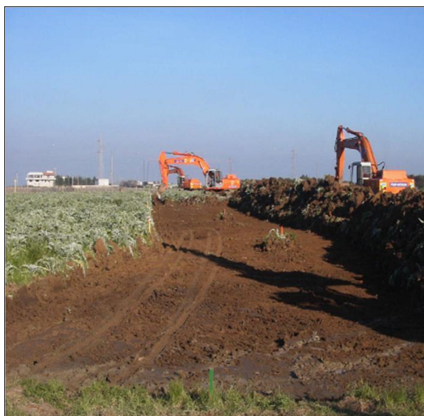
Fig. 2.2-A – Foto di apertura dell'area di passaggio
