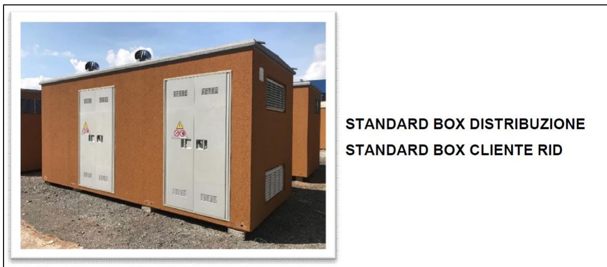
Figura 8 – Vista frontale della cabina di sezionamento tipo
