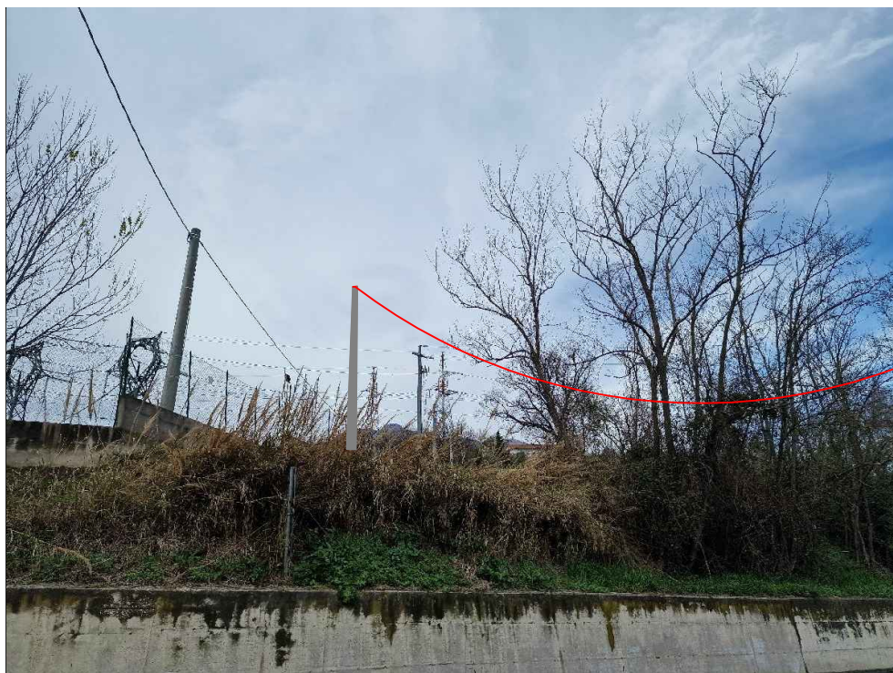
FOTOGRAFIA 1 - Cabina primaria Casoli
