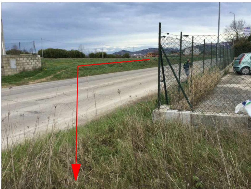
Attraversamento S.P. n.44
