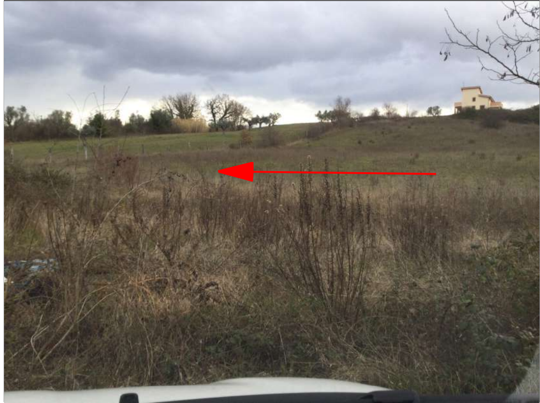
Punto di uscita trenchless (TOC Valle Carbone II)
