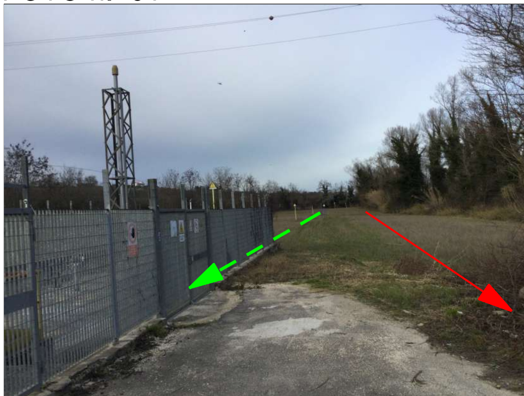
Passaggio in prossimità impianto esistente
