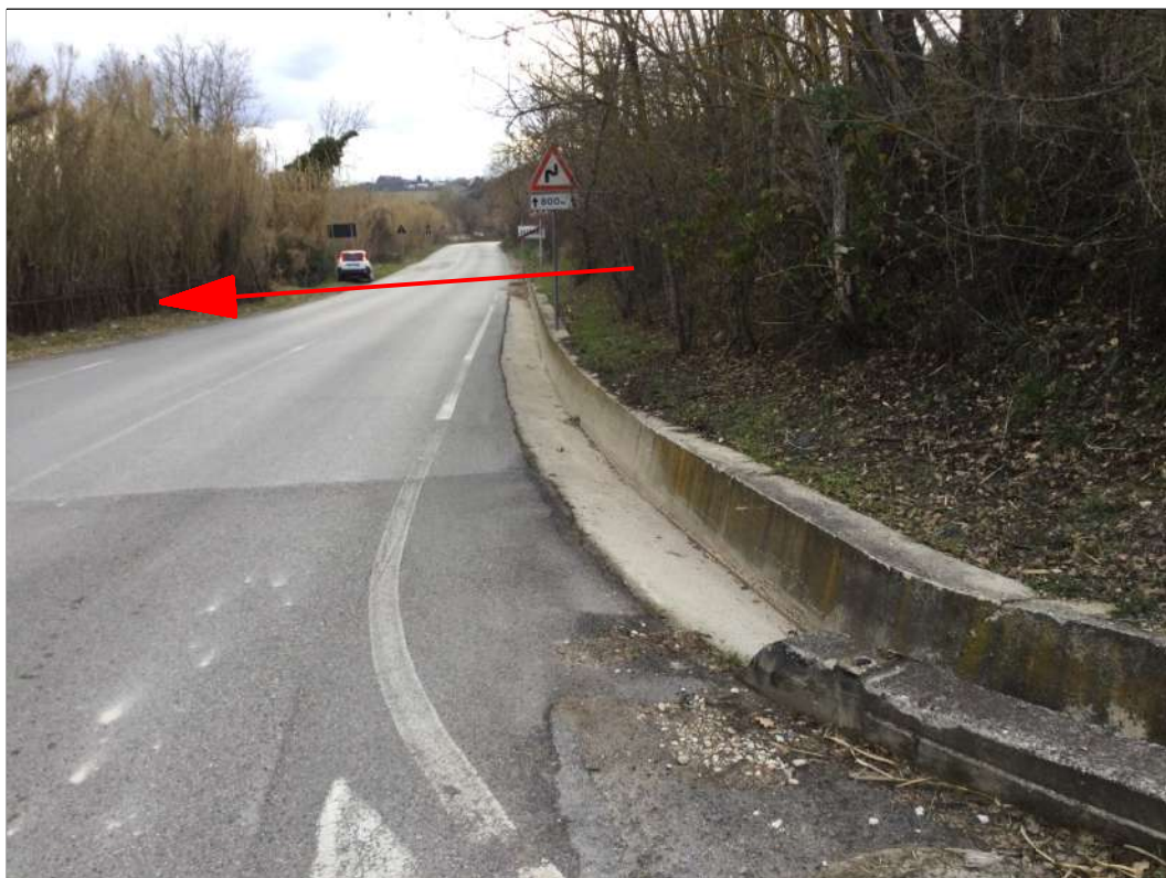
Attraversamento Via dei Frassini
