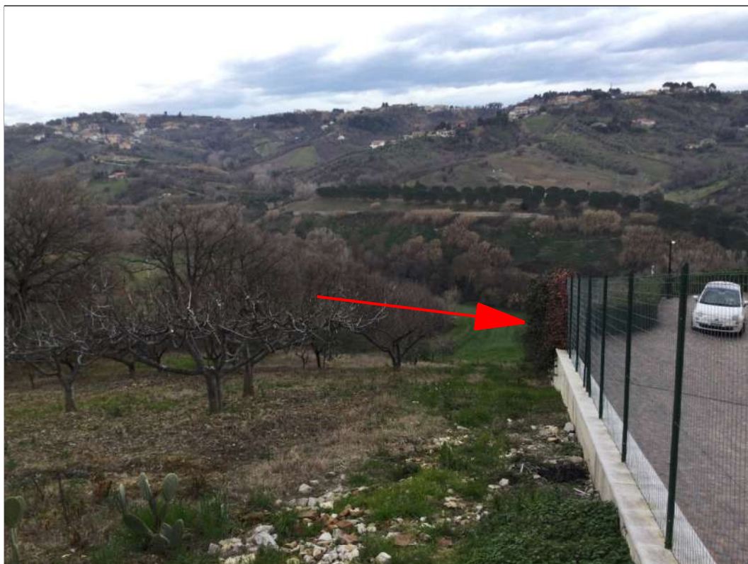
Punto di ingresso trenchless (TOC Valle Carbone II)
