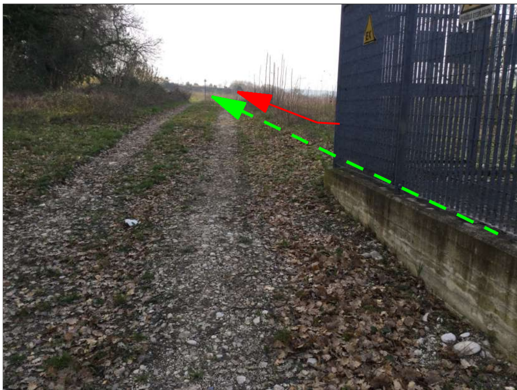
Passaggio in prossimità impianto esistente
