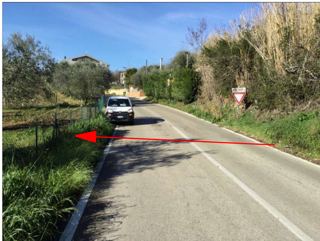
Attraversamento S.P. n.26
