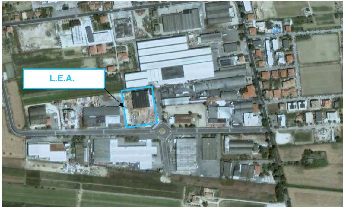
Fig. 1 - Foto satellitare con indicazione dello stabilimento
