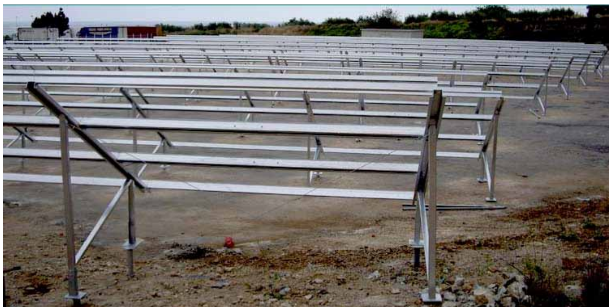
Figura 4.7 - Telaio visto da dietro con sistema di fissaggio senza cementazione
