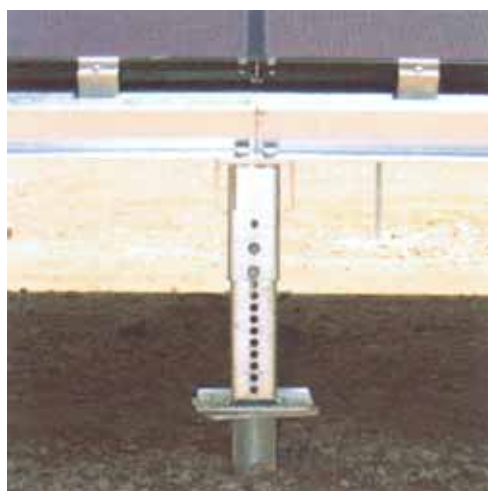
Regolazione del livello mediante sistema telescopico
