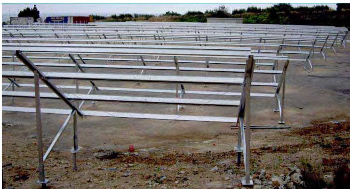
Figura 4.6 - Telaio a profilati in acciaio zincato orientato a sud e inclinato di 30°
