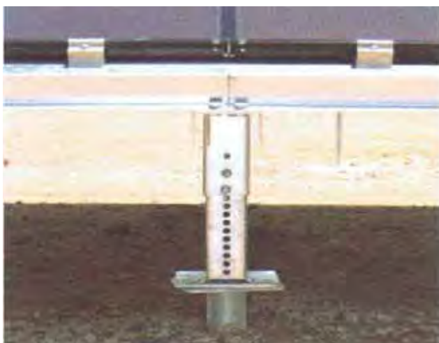
Regolazione del livello mediante sistema telescopico
