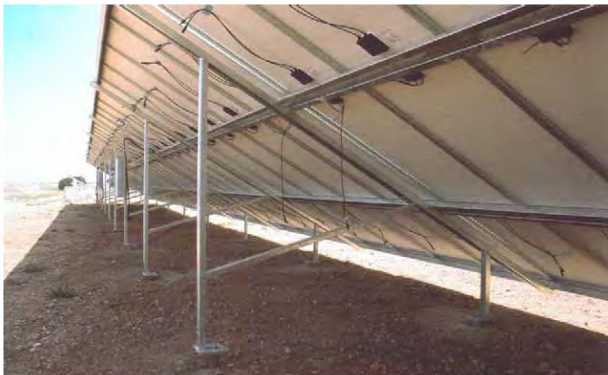
Figura 4.6 - Telaio a profilati in acciaio zincato orientato a sud e inclinato di 30°
