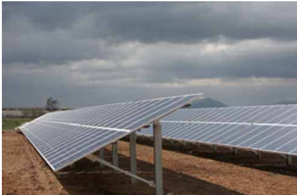
Figura 1: particolare struttura di sostegno
