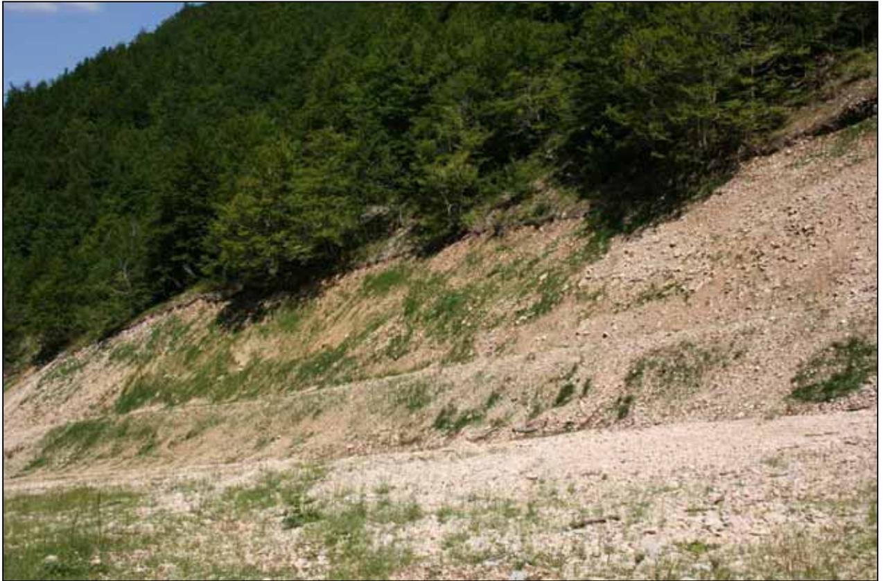
**Figura 35** - esempio di terrazzamento di consolidamento di un versante esposto della pista, con esemplari giovani di *Fagus sylvatica*
