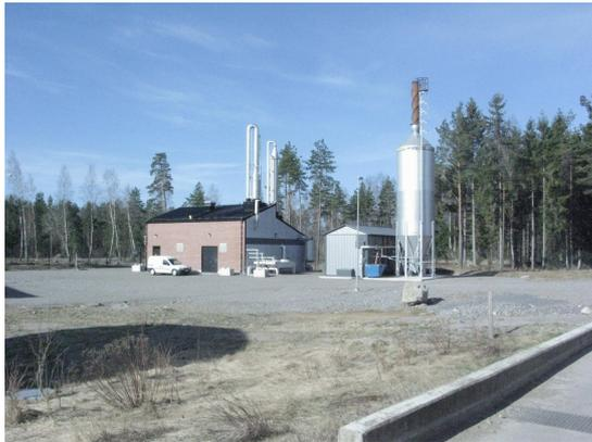
di Vaxjo ed è stato implementato per la produzione di biogas/biometano nell'ambito di un progetto più vasto che ha previsto la riduzione di CO<sub>2</sub> del 30% dal 1993 al 2006 e che ha come obiettivo una riduzione del 70 % di CO<sub>2</sub> al 2025. L'impianto è alimentato con fango proveniente dall'impianto di trattamento delle
