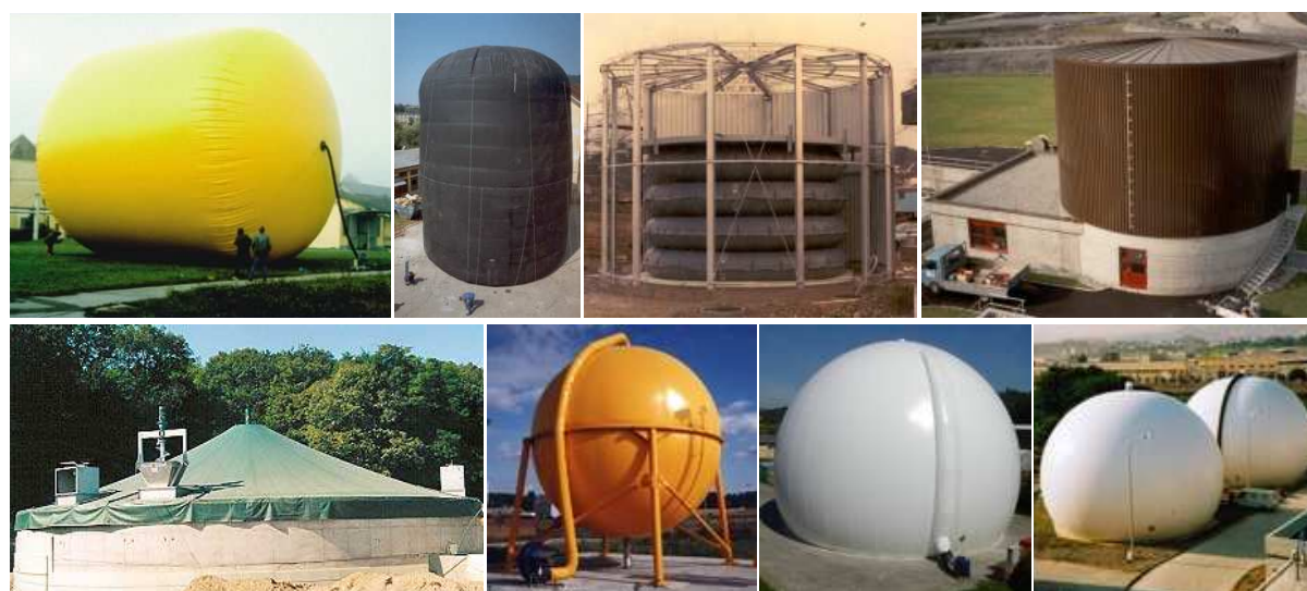
Figure 4: Sistema di stoccaggio del gas a bassa pressione: palla di stoccaggio del gas (fila in alto a sinistra); cuscino di stoccaggio (fila in alto destra); tetto a membranaper stoccaggio su
