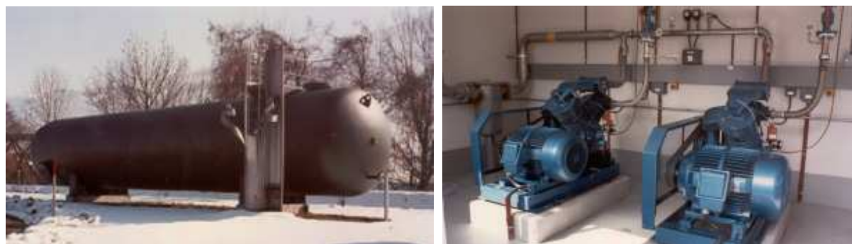
Figure 5: Sistema di stoccaggio di biogas grezzo ad alta pressione: stoccaggio gas (sinistra); unità di compressione ed espansione (destra); Fonte: Panaqua AG
