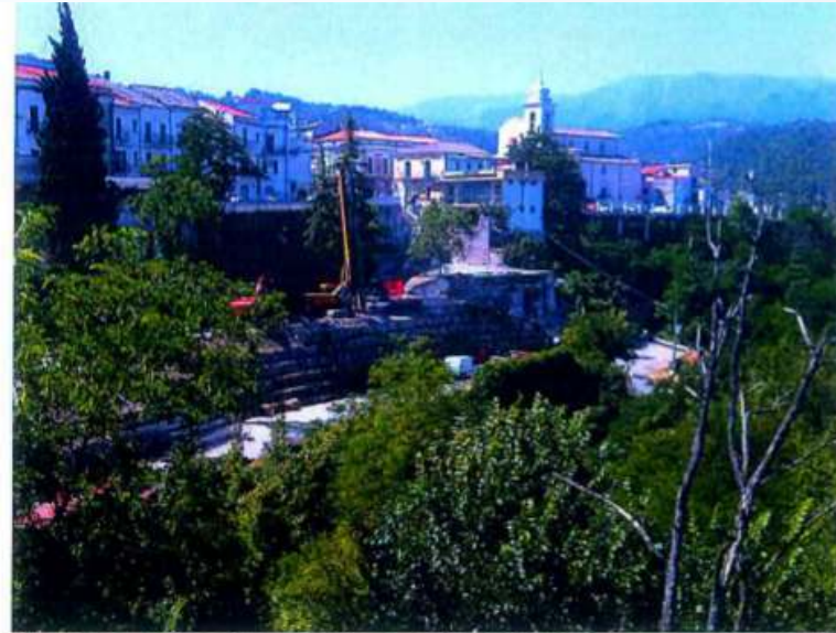
Figura 14 – Panoramica del versante oggetto di intervento e operazioni di cantiere
