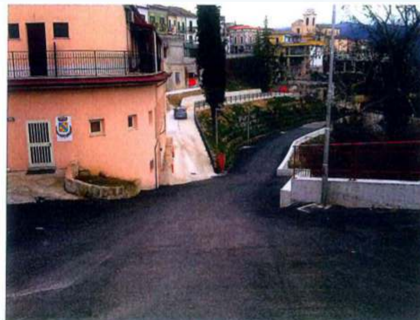
Figura 26 – Il cantiere a fine realizzazione delle opere
