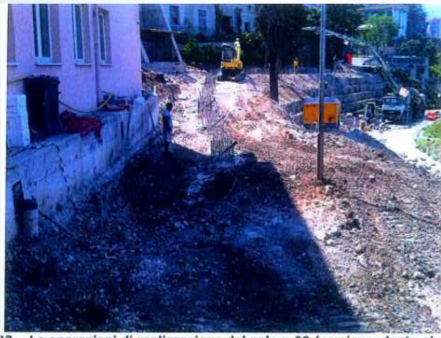
Figura 25 – Le operazioni di riqualificazione del viale n° 60 (completamento al 100%)
