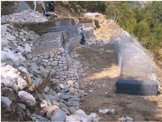
Foto post intervento
