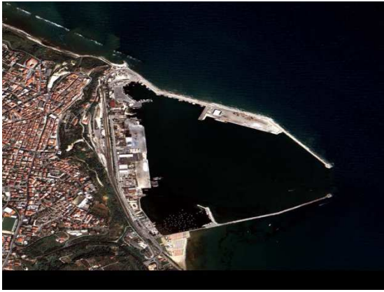
Foto pre intervento
