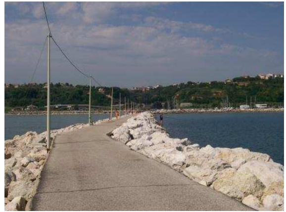
Foto pre intervento
