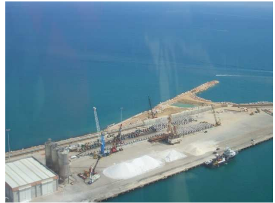
Foto post intervento
