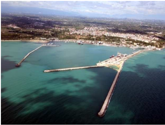
Foto post intervento
