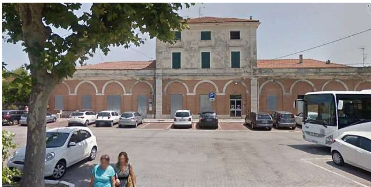
Stazione ferroviaria dismessa di Vasto Marina. Esterno prospetto ovest.
