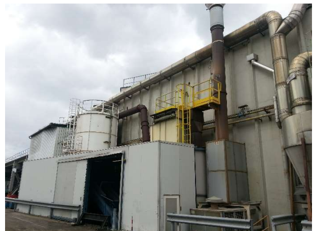
FOTO 10: PARTICOLARE CAMINO E24
