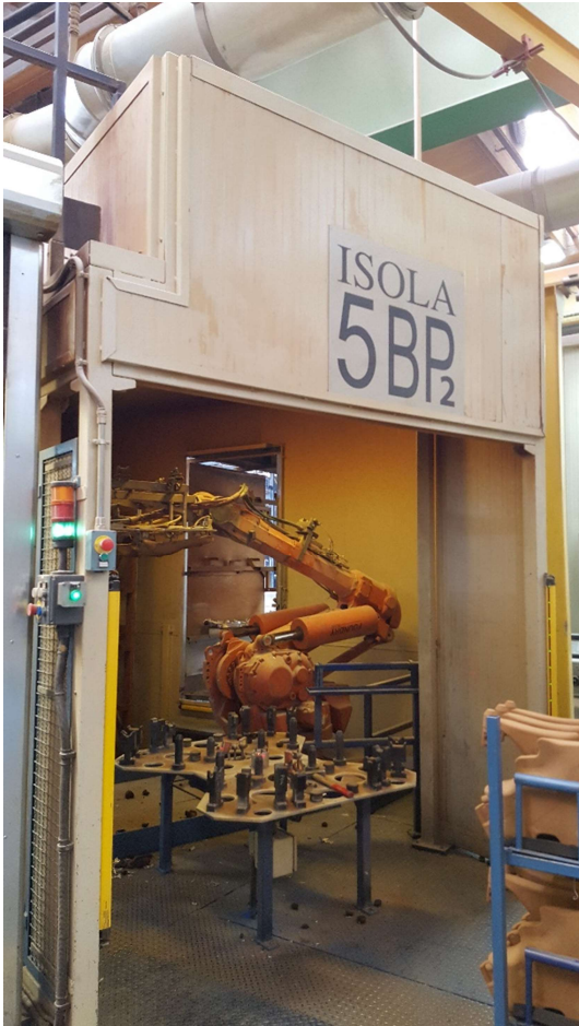
FOTO 7 : DETTAGLIO DELLA FASE DI COLATA
