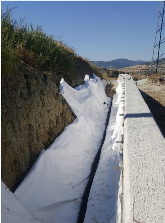
LA REALIZZAZIONE DEL DRENAGGIO DIETRO IL MURO DI RECINZIONE - FOTO 1 e 2
