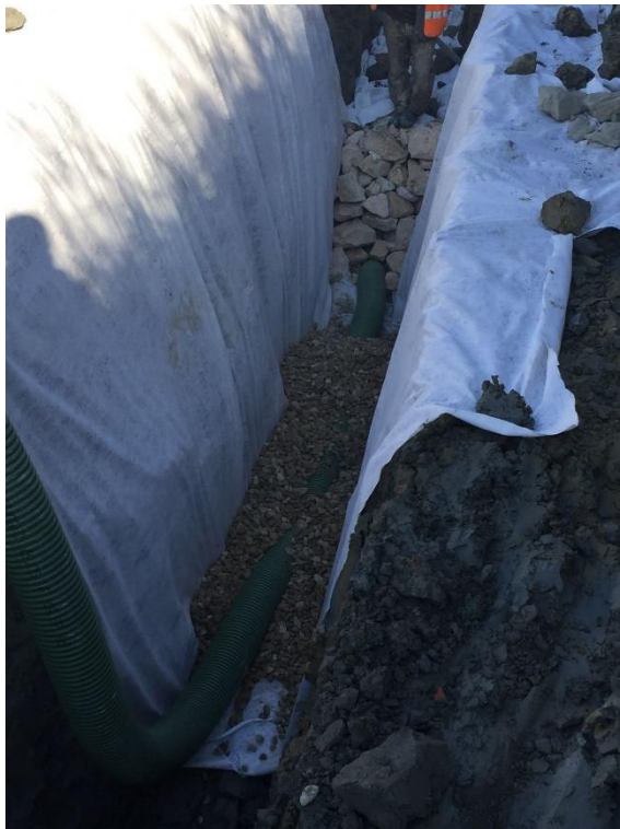
PARTICOLARE DRENAGGIO DIETRO RECINZIONE - FOTO 3 e 4
