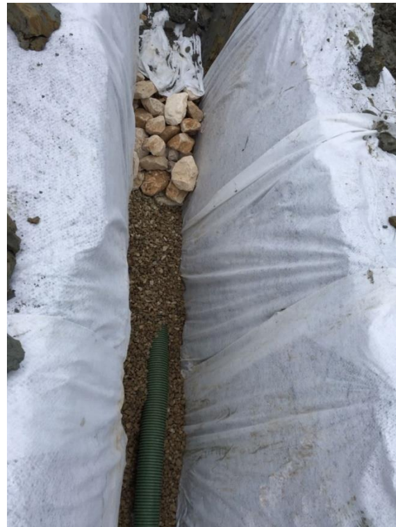
PARTICOLARE DRENAGGIO DIETRO RECINZIONE - FOTO 3 e 4
