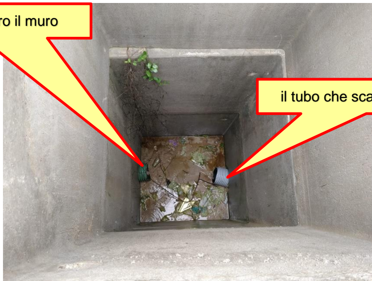
IL POZZETTO DI CONFLUENZA DEL DRENAGGIO RETRO MURO FOTO 5 e 6
