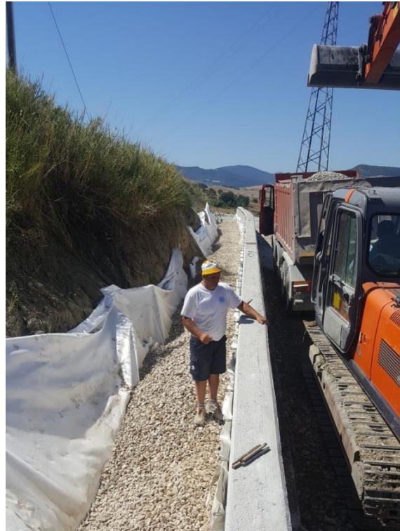
LA REALIZZAZIONE DEL DRENAGGIO DIETRO IL MURO DI RECINZIONE - FOTO 1 e 2
