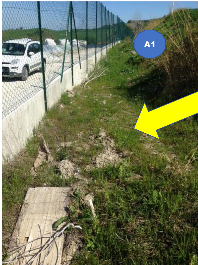
TRATTO NON CANALIZZATO COME DA PROGETTO DEFINITIVO
