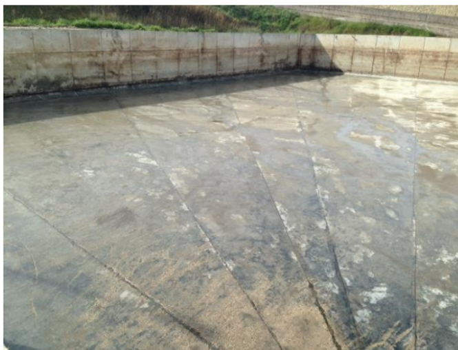
Vasca completamente svuotata da percolato e fanghi di sedimentazione
