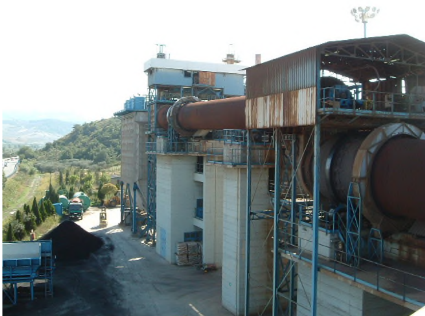
Figura 3: forno di essiccazione e cottura dell'argilla espansa
