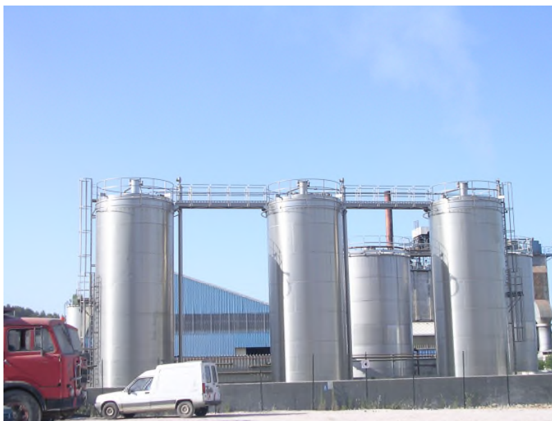
Figura 5: impianto di stoccaggio di solventi esausti
