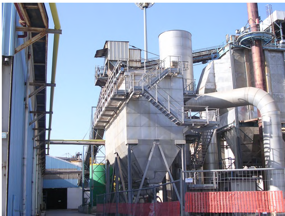
Figura 7: impianto di abbattimento delle polveri
