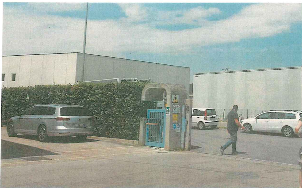
Foto 6 – Ingresso impianto lato Nord – Via dei Tipografi
