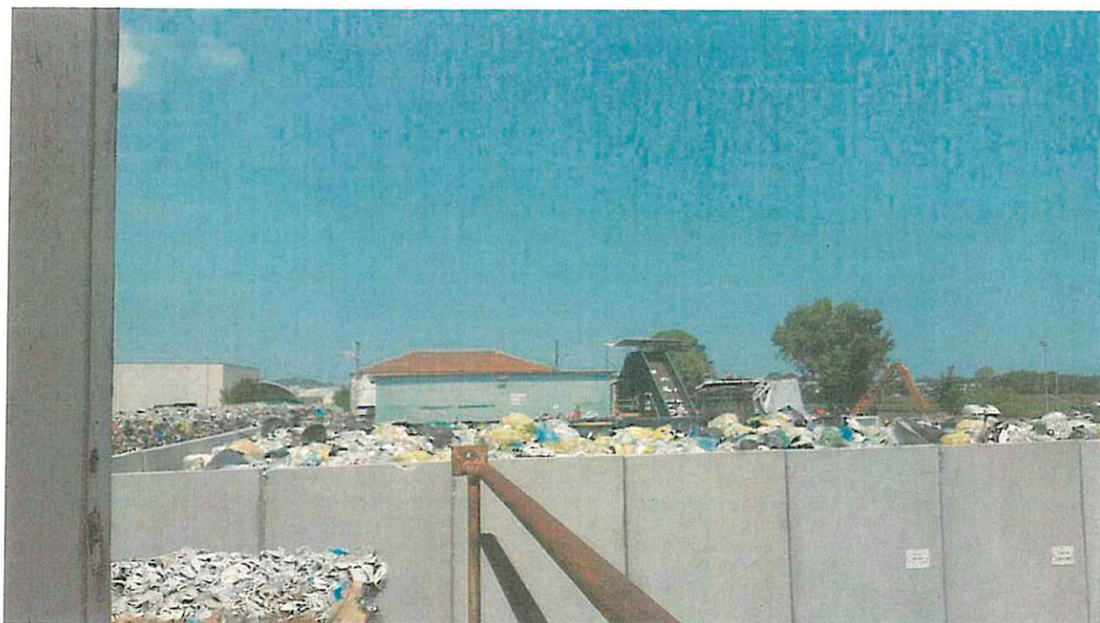
Foto 12 – Lato sud del piazzale – separazione delle aree con setti di cemento
