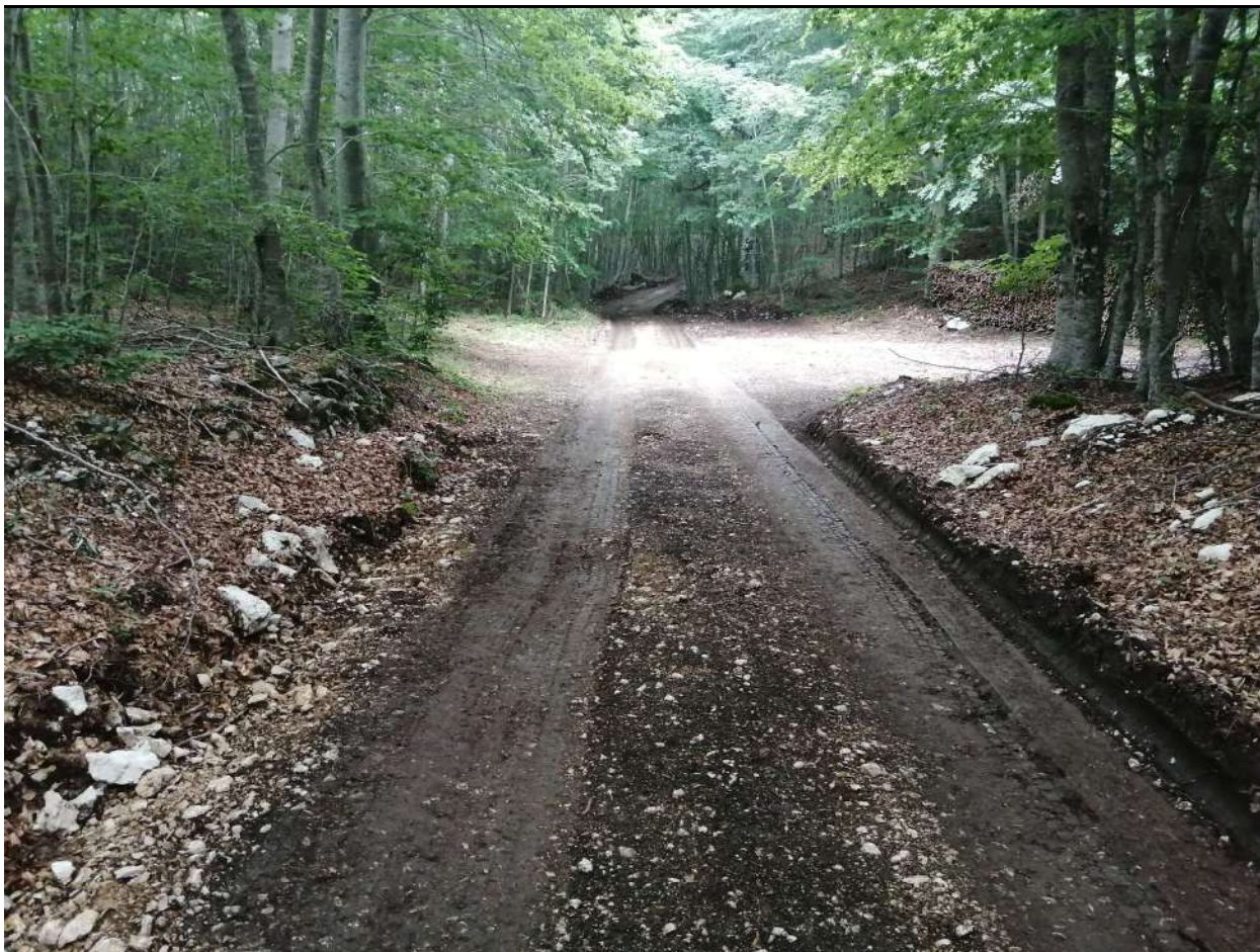
Foto n. 13 – La strada camionabile a fondo migliorato di servizio al bosco, verrà percorsa dagli autocarri addetti al trasporto del legname; ai lati i piazzali esistenti dove verrà posizionato l'imposto per il caricamento.
