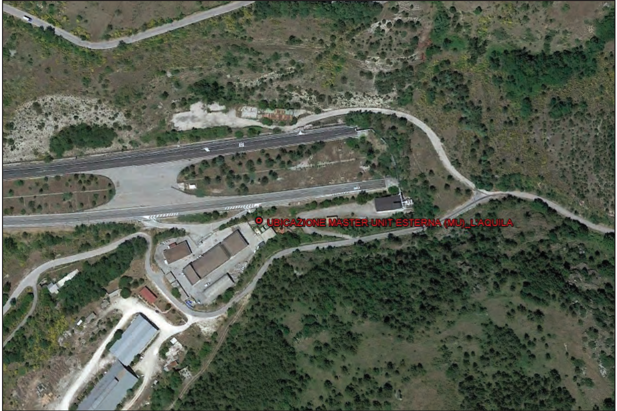
Foto 2_TUNNEL "GRAN SASSO"_ FORNICI LATO L'AQUILA _ AREA FUTURA INSTALLAZIONE APPARATO MASTER (MU) e ANTENNE DONATRICI
