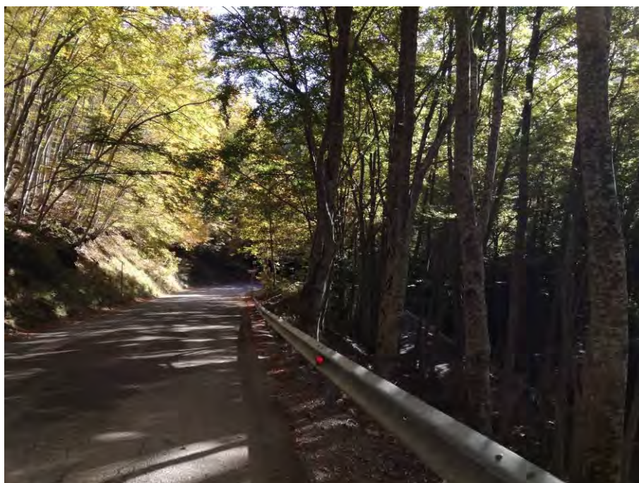
Figura 21 – Vista da monte del tornante al km 14+850
