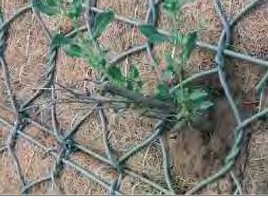
PARTICOLARE TIPO PROTEZIONE CORTICALE
