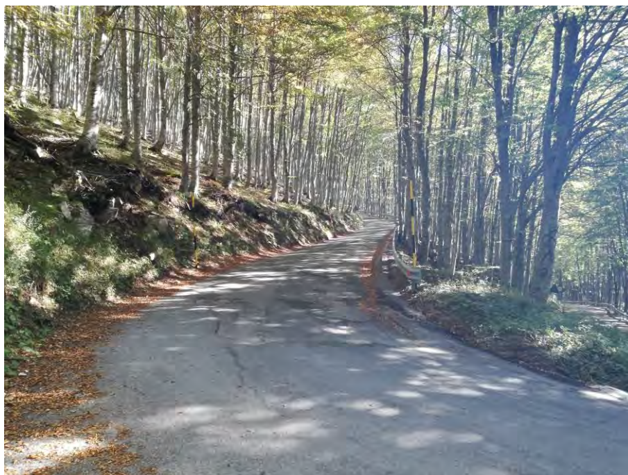
Figura 23 – Vista da valle del tornante al km 15+100
