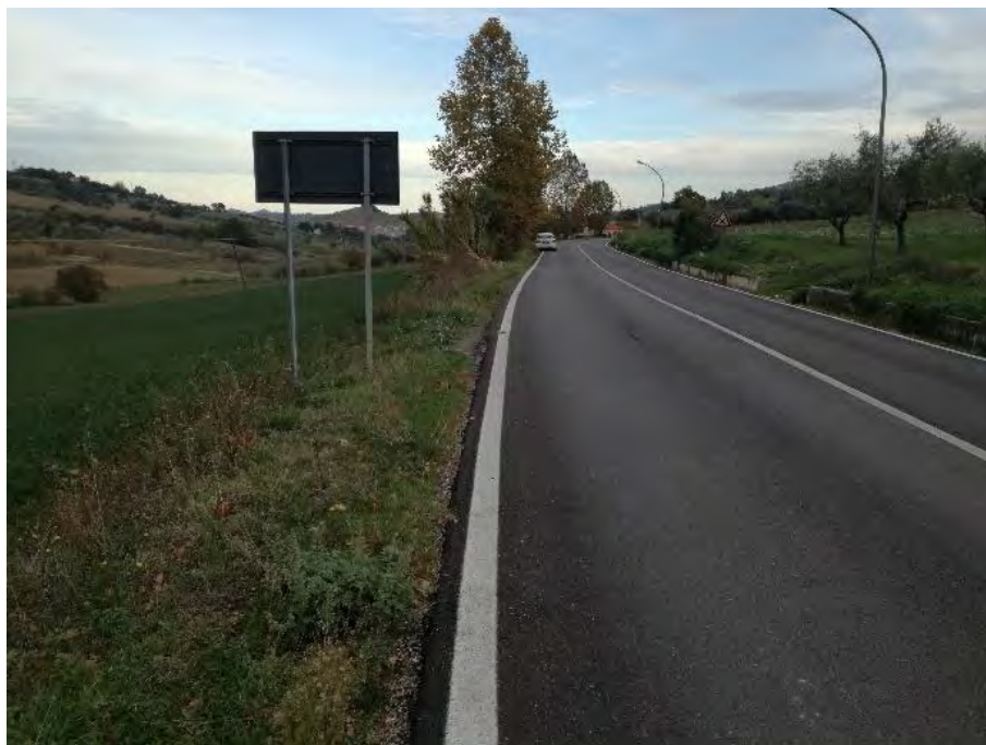
Figura 29 – Fessure trattive sulla sede stradale
