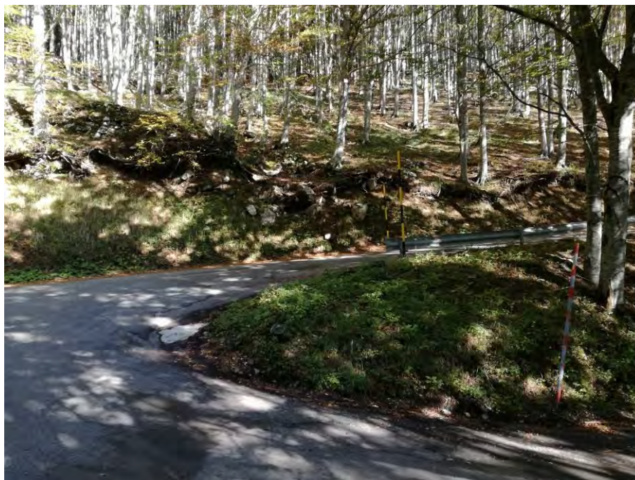
Figura 22 – Vista da valle del tornante al km 15+100
