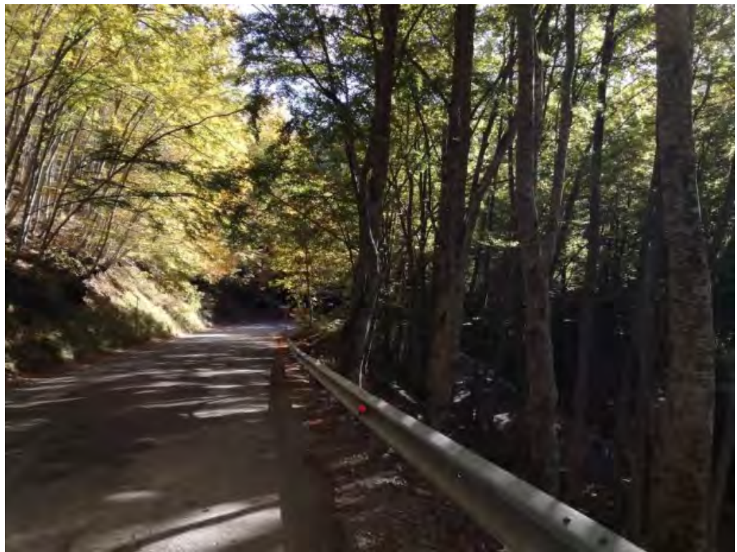
Vista da monte del tornante al Km 14+850
