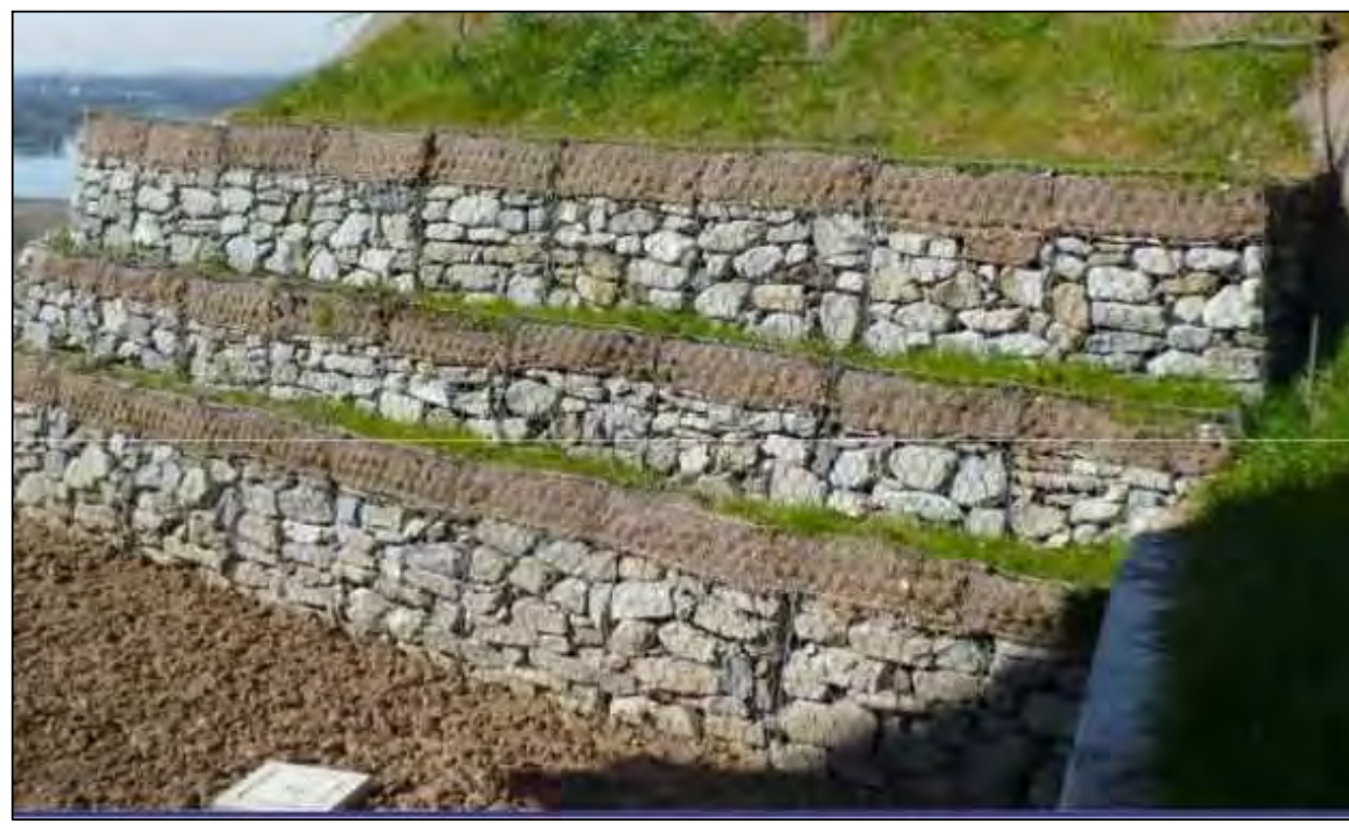
PARTICOLARI TIPO TERRAMESH SYSTEM
