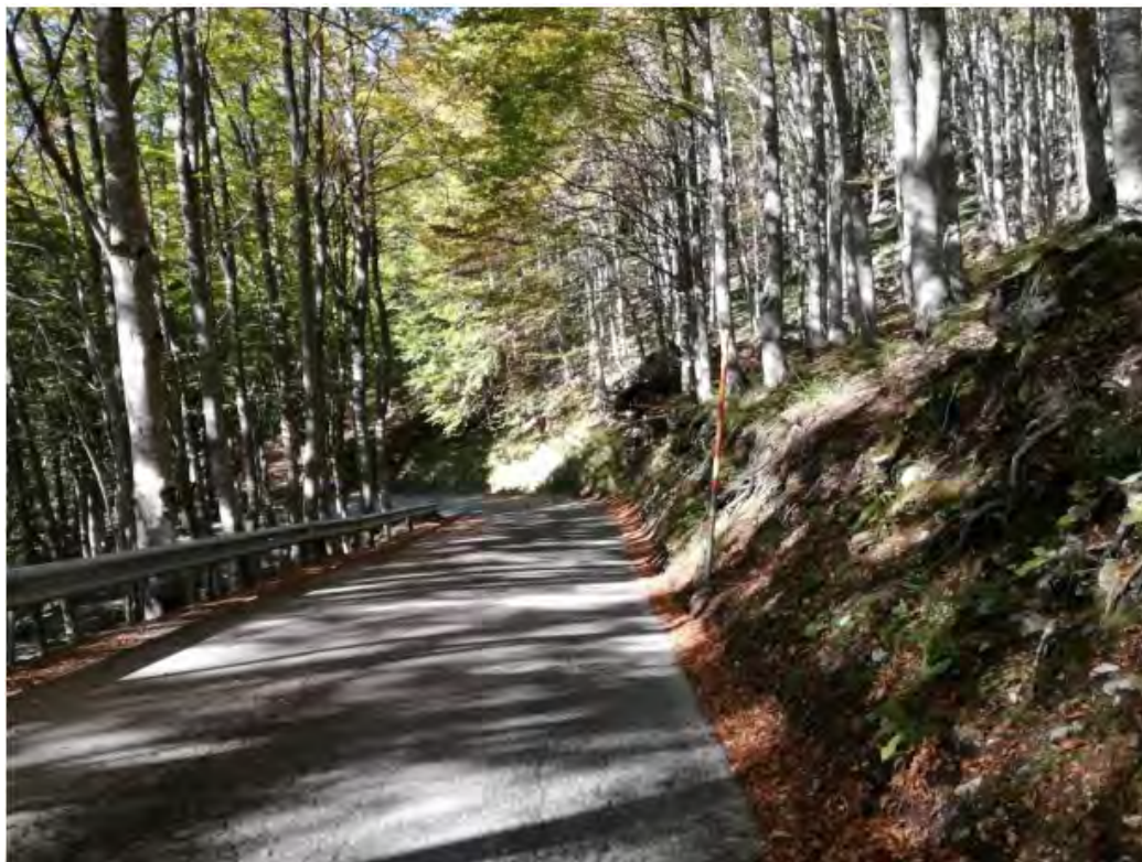
Vista da monte del tornante al Km 15+100
