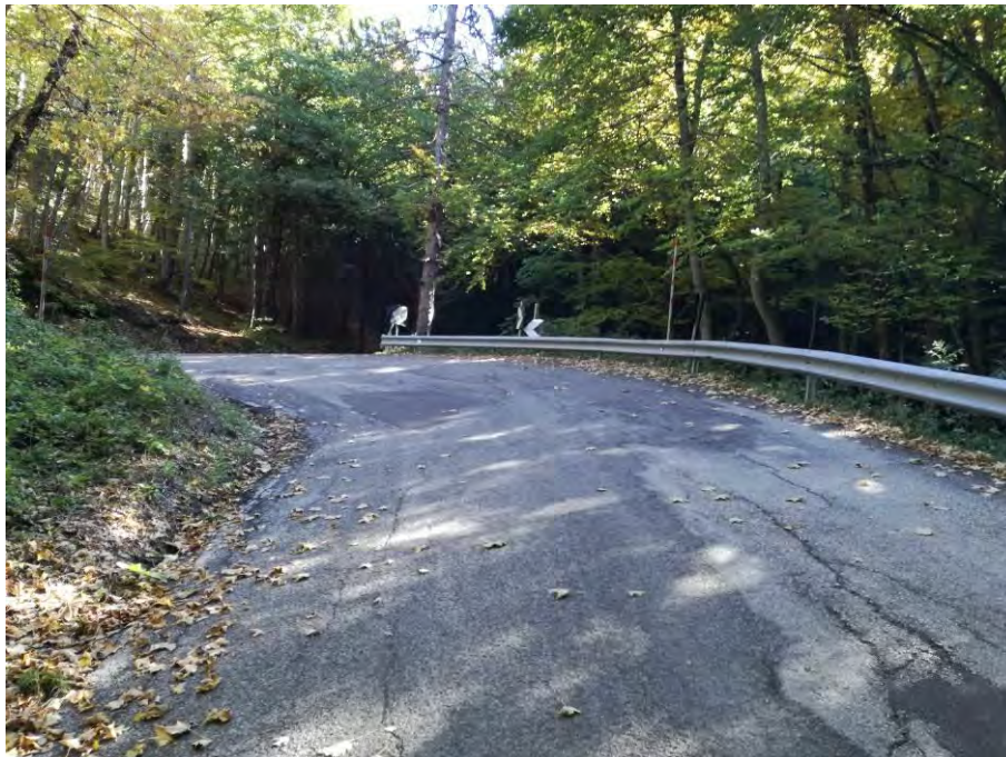
Figura 19 - Vista da valle del tornante al km 14+850
