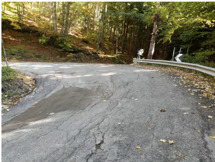
Figura 20 – Vista da valle del tornante al km 14+850
