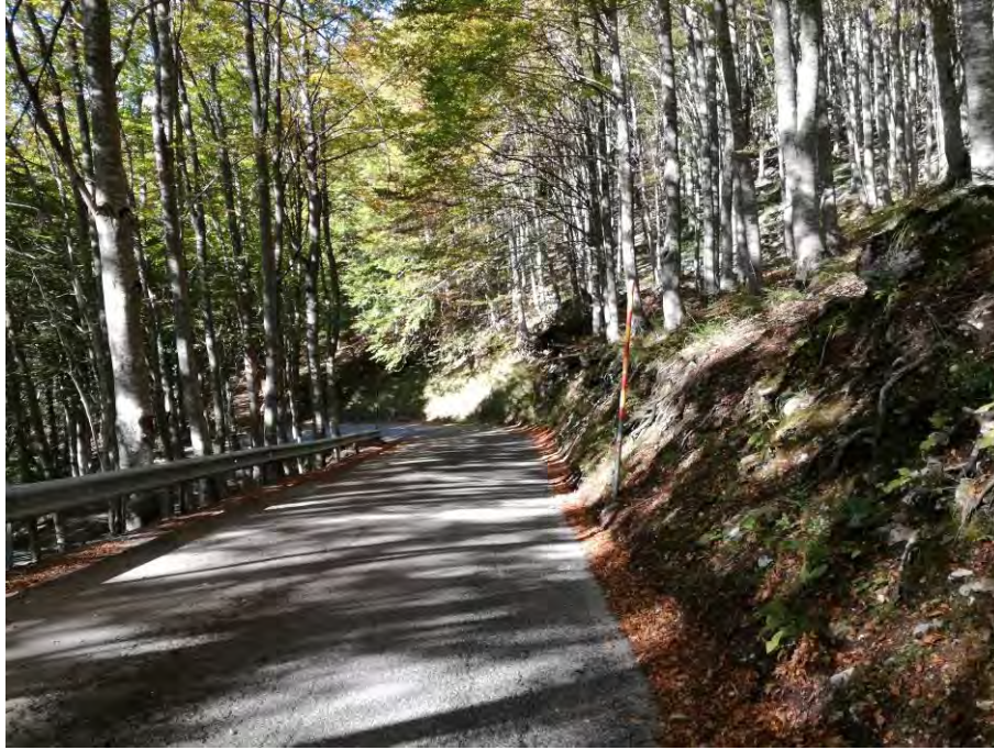
Figura 24 – Vista da monte del tornante al km 15+100
