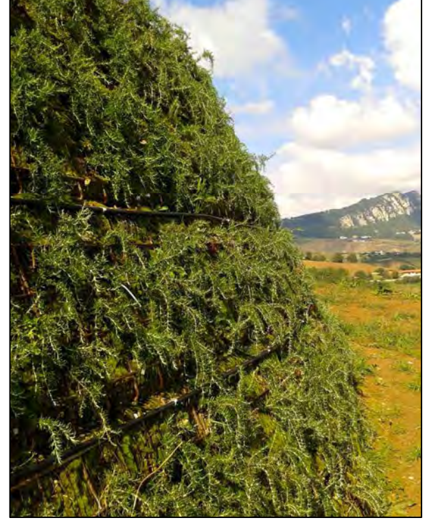
PARTICOLARE TIPO RINVERDIMENTO SCARPATA
