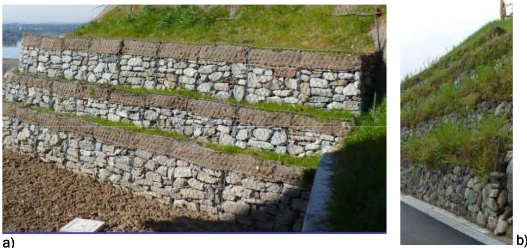
**Figura 12** - Esempio di intervento in terramesh: **a)** in fase di realizzazione e parziale inverdimento. **b)** completamente rinverdita
