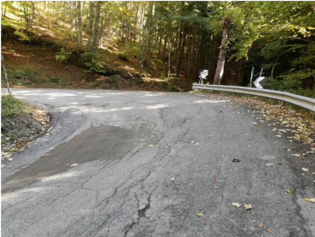
Vista da valle del tornante al Km 14+850
