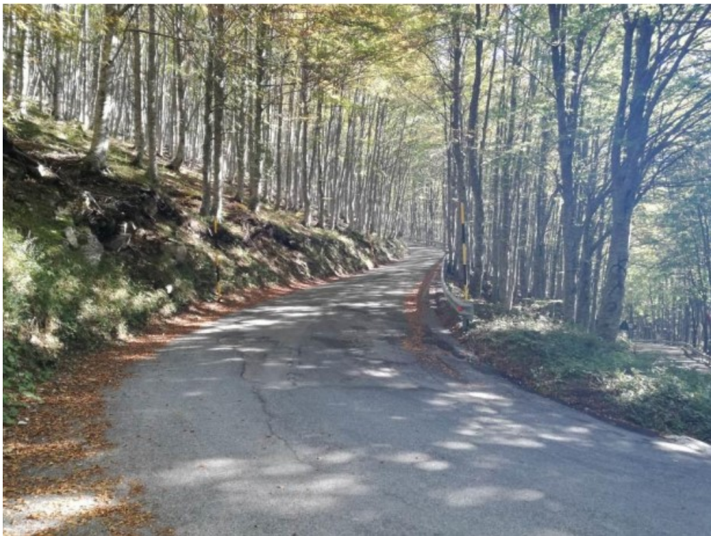
Vista da valle del tornante al Km 15+100
