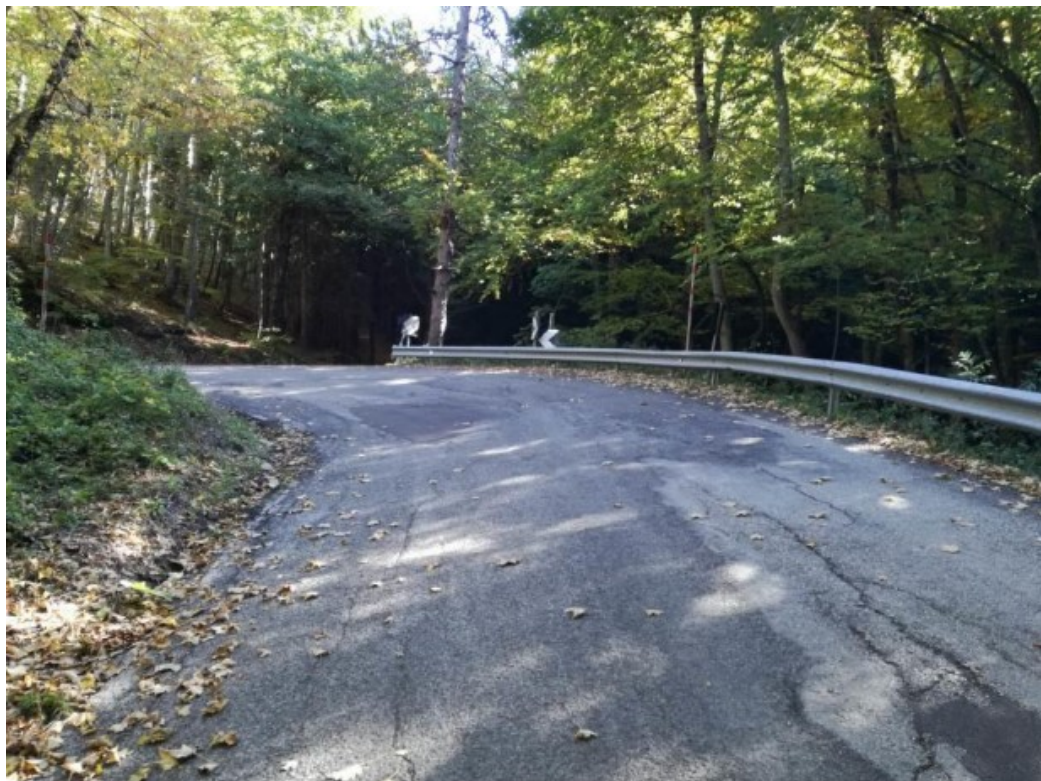
Vista da valle del tornante al Km 14+850
