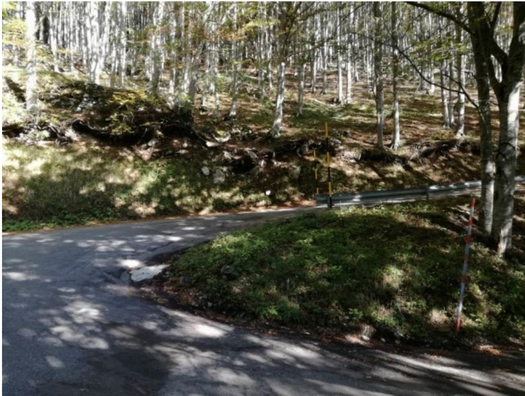
Vista da valle del tornante al Km 15+100
