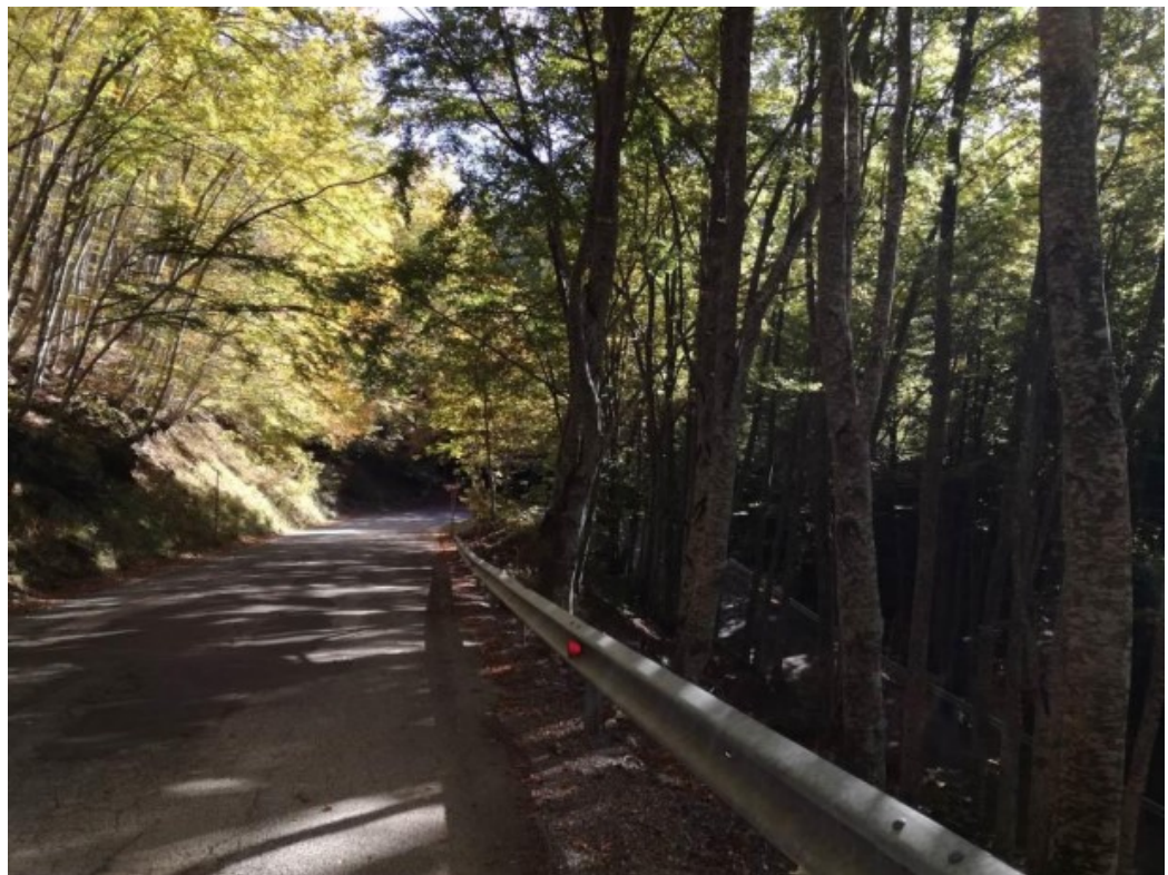
Vista da monte del tornante al Km 14+850
