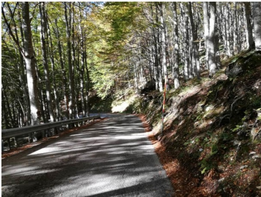
Vista da monte del tornante al Km 15+100
