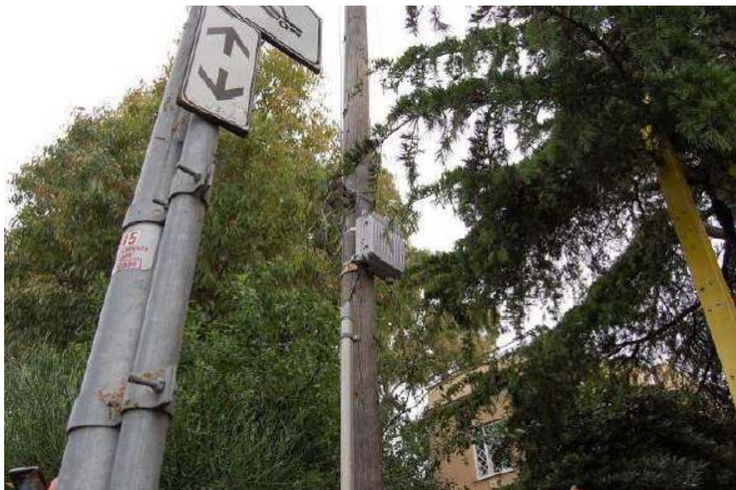
Figura 51: Esempio di posizionamento ROE su palifica
