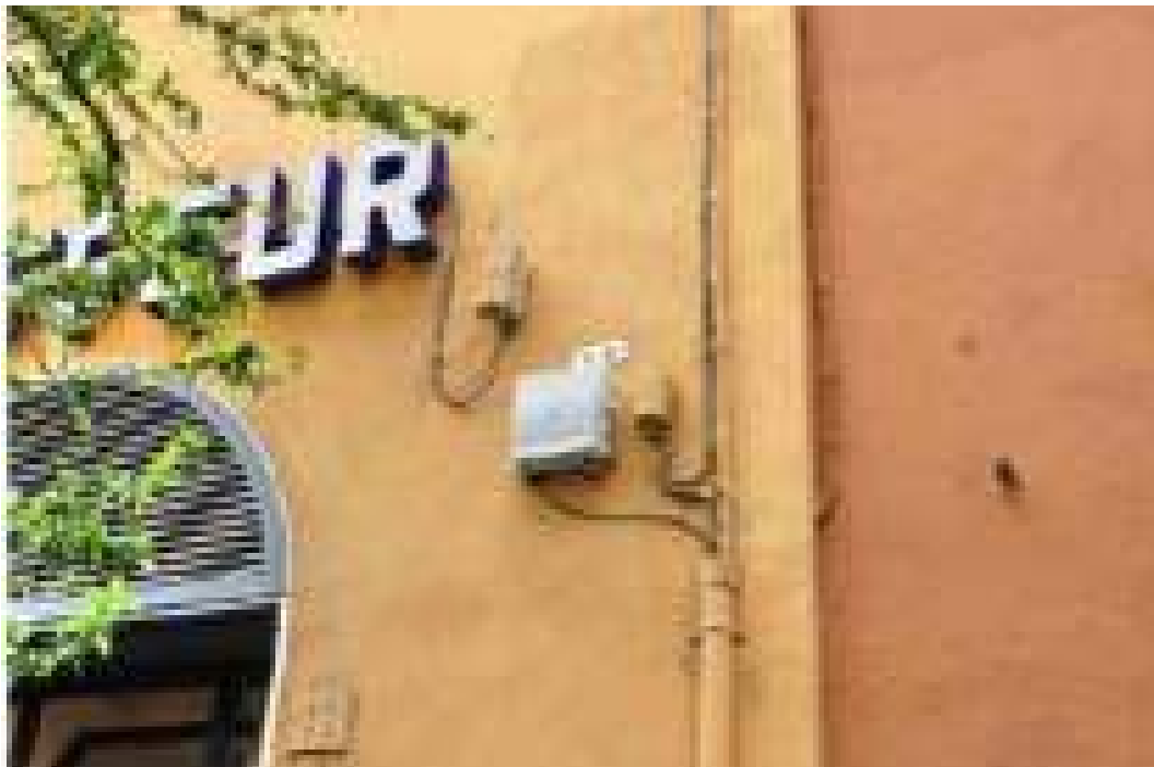
Figura 50: Esempio di posizionamento ROE in facciata di edificio
