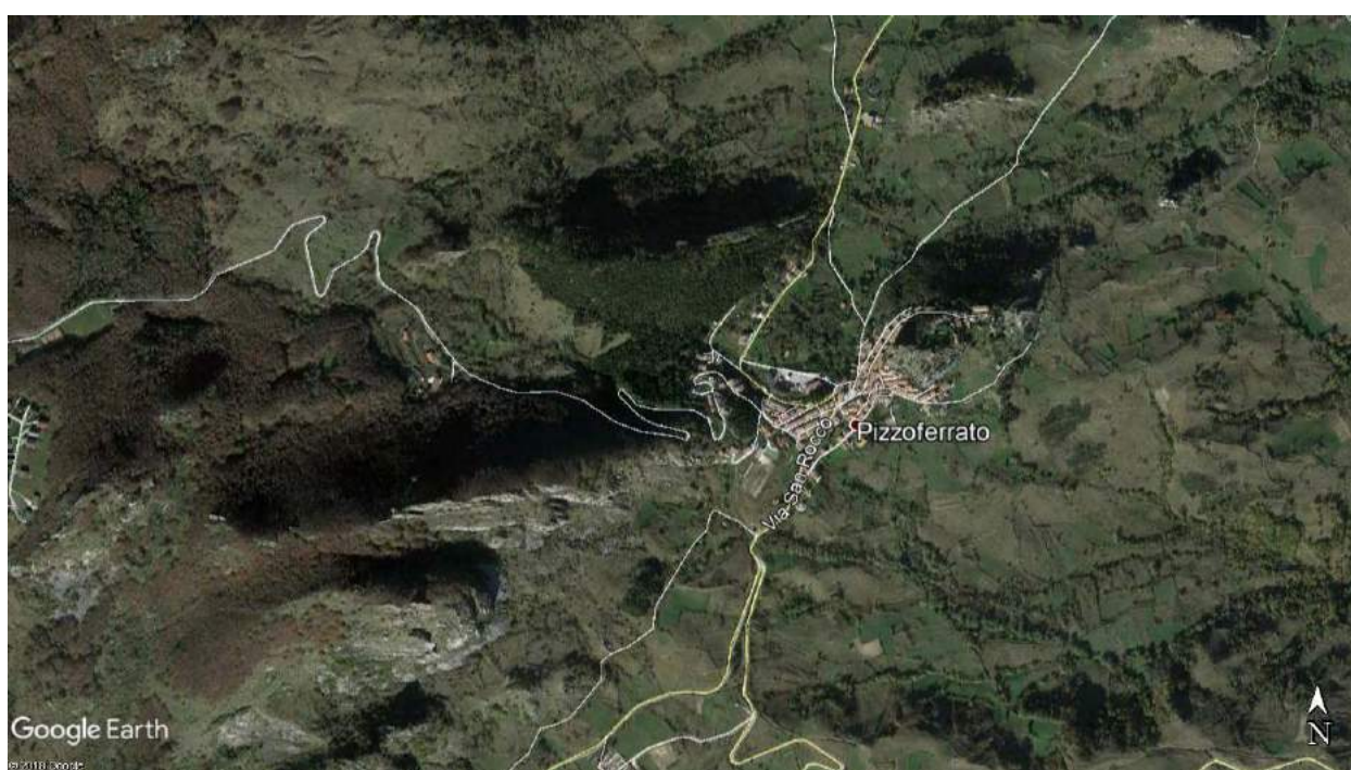
Figura 29: Localizzazione del Comune di Pizzoferrato su foto aerea
