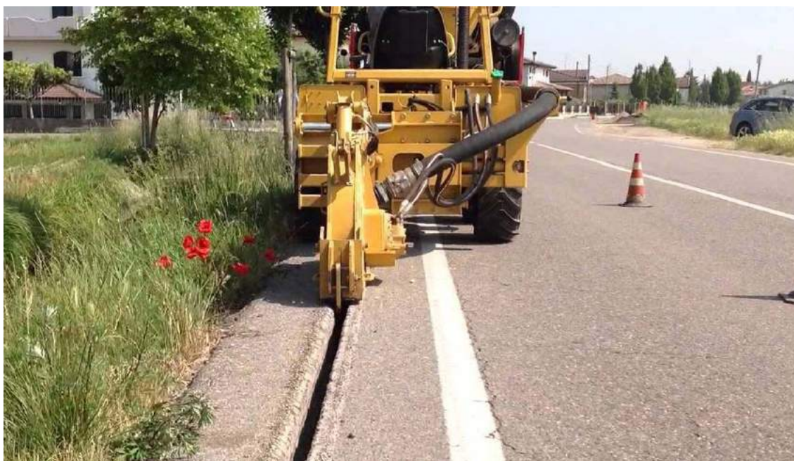
Figura 45: Esempio di realizzazione di scavo in minitrincea
