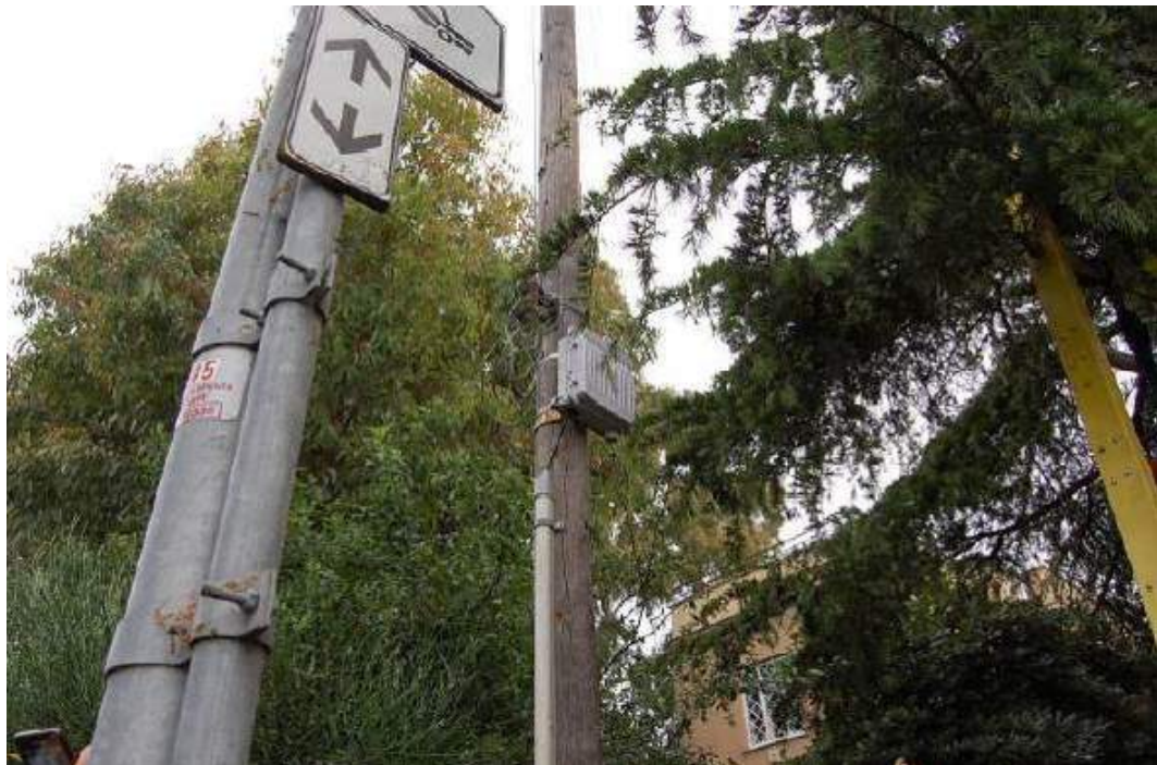
Figura 29: Esempio di posizionamento ROE su palifica
