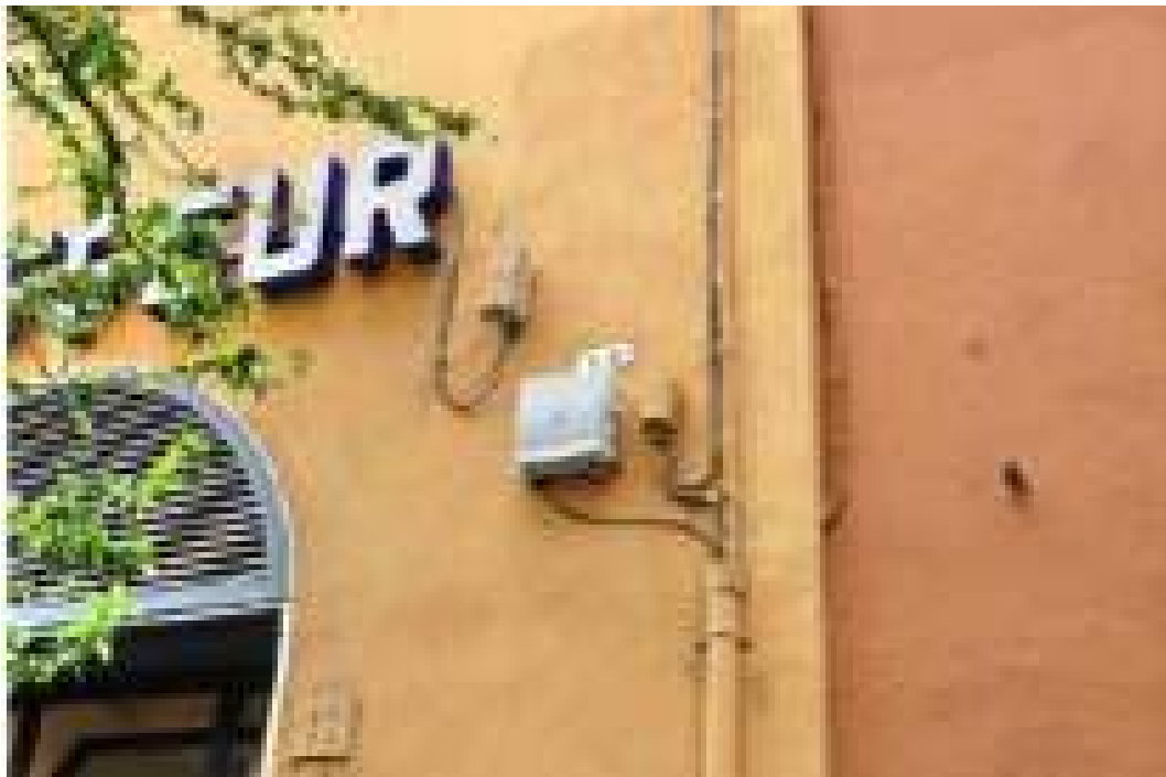
Figura 28: Esempio di posizionamento ROE in facciata di edificio
