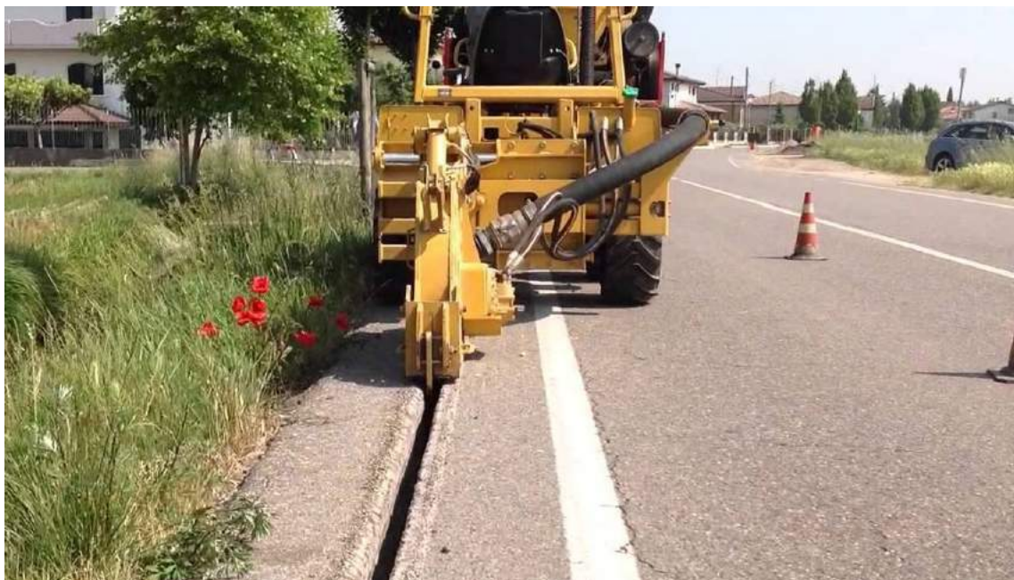
Figura 17: Esempio di realizzazione di scavo in minitrincea
