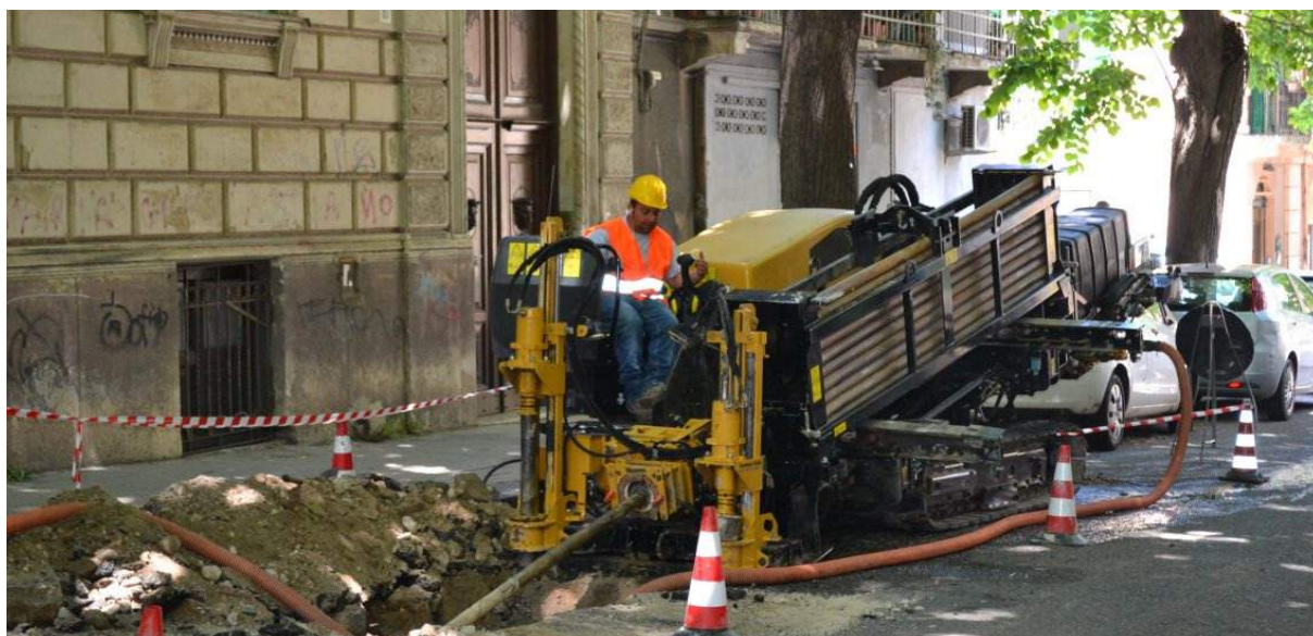
Figura 21: Vista di macchina perforatrice tipo al lavoro
