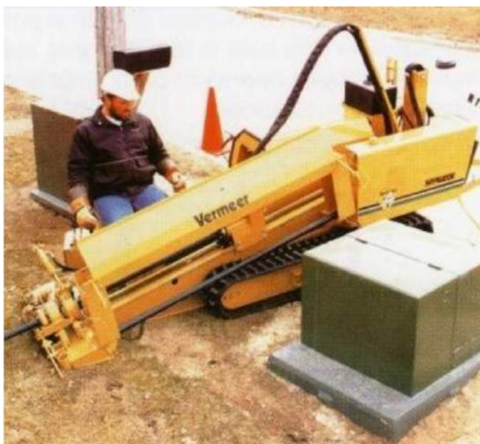
Figura 19: Vista di macchina perforatrice Min Rig al lavoro
