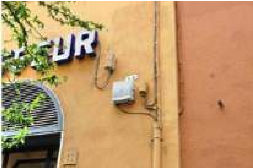
Figura 25: Esempio di posizionamento ROE in facciata di edificio
