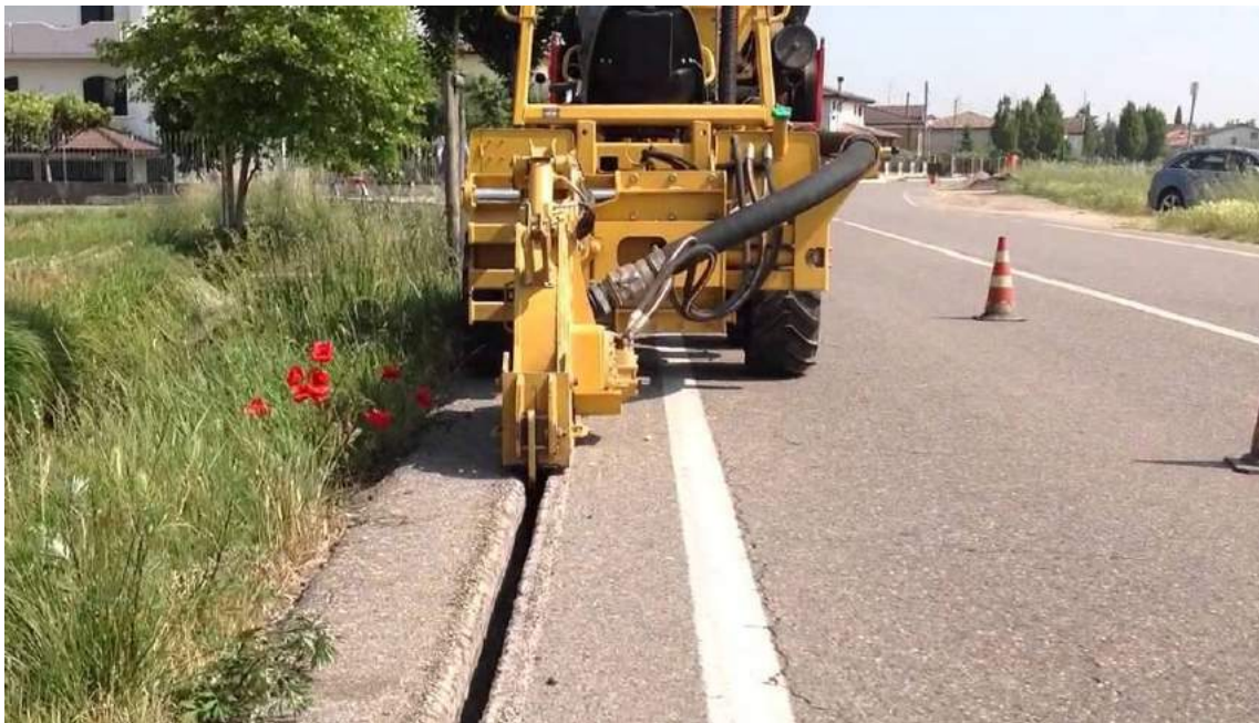
Figura 14: Esempio di realizzazione di scavo in minitrincea
