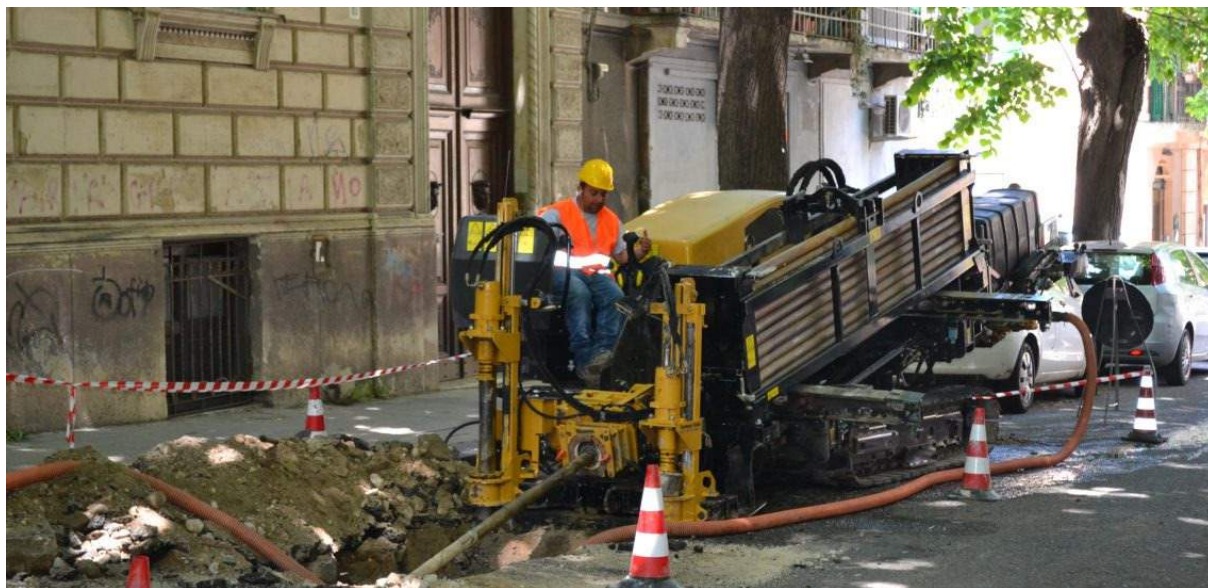
Figura 18: Vista di macchina perforatrice tipo al lavoro
