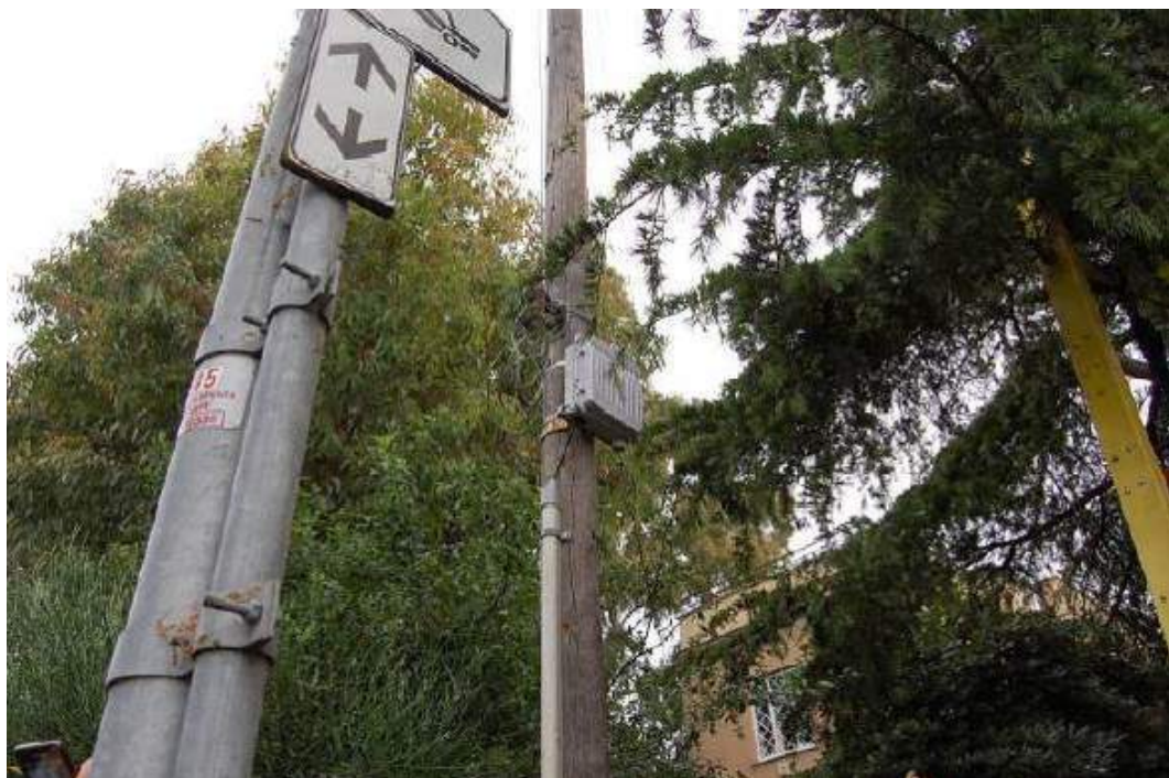
Figura 26: Esempio di posizionamento ROE su palifica
