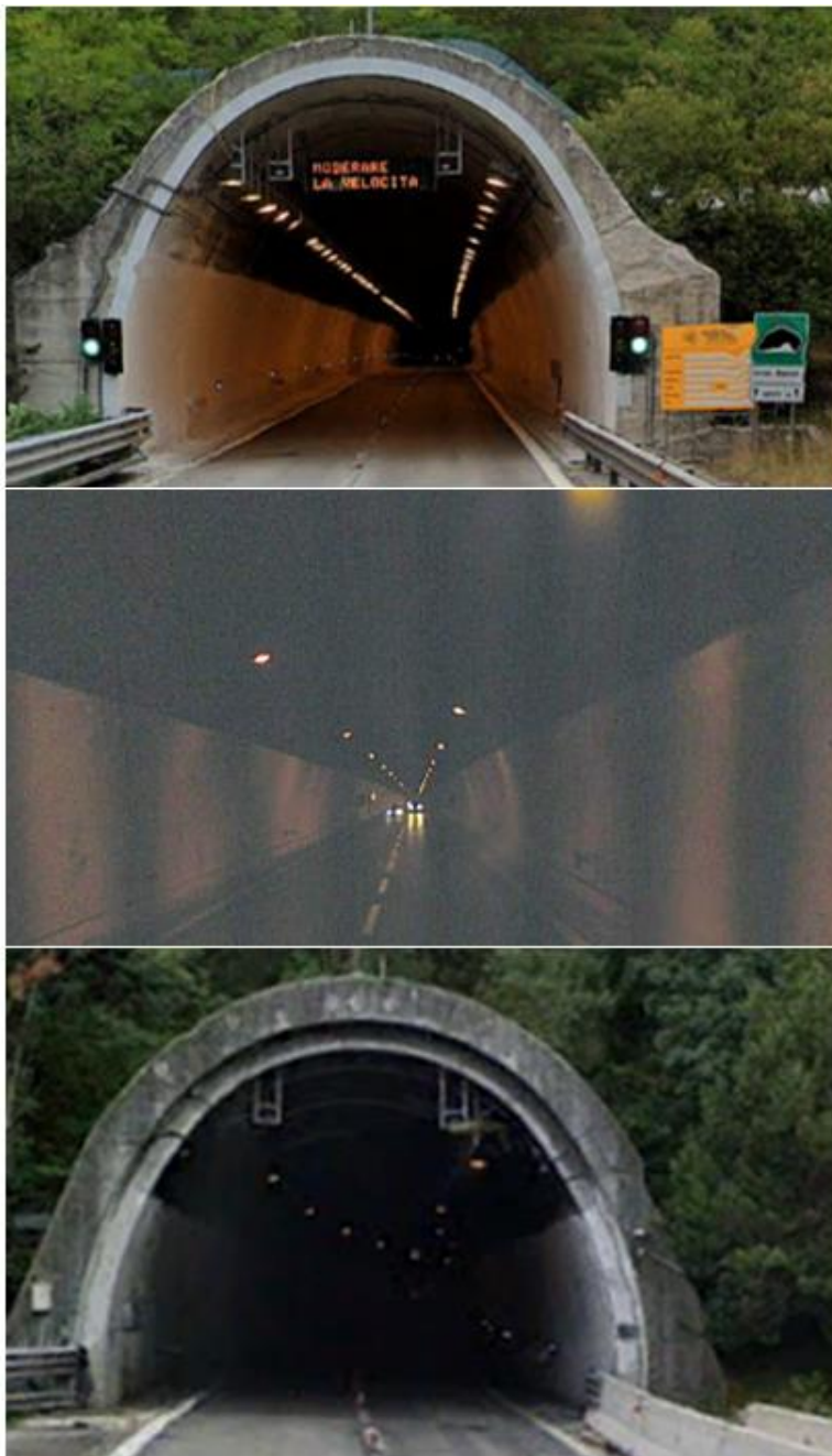
Figura 8-1 Carreggiata Nord della galleria autostradale del Gran Sasso (Fonte: Google street view)
