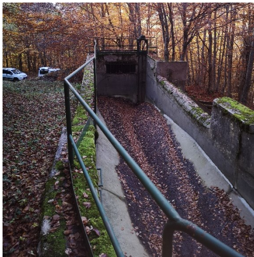
Detriti all'interno delle opere idrauliche
