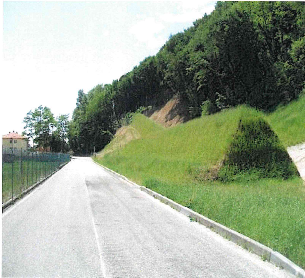
Ambientazione a ridosso di infrastruttura viaria
