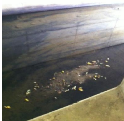
sistema di raccolta acque meteoriche con punti di stagnazione al piano stradale di via Cervana
