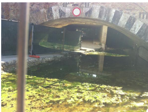
sistema di raccolta acque meteoriche con punti di stagnazione al piano stradale di via Cervana
