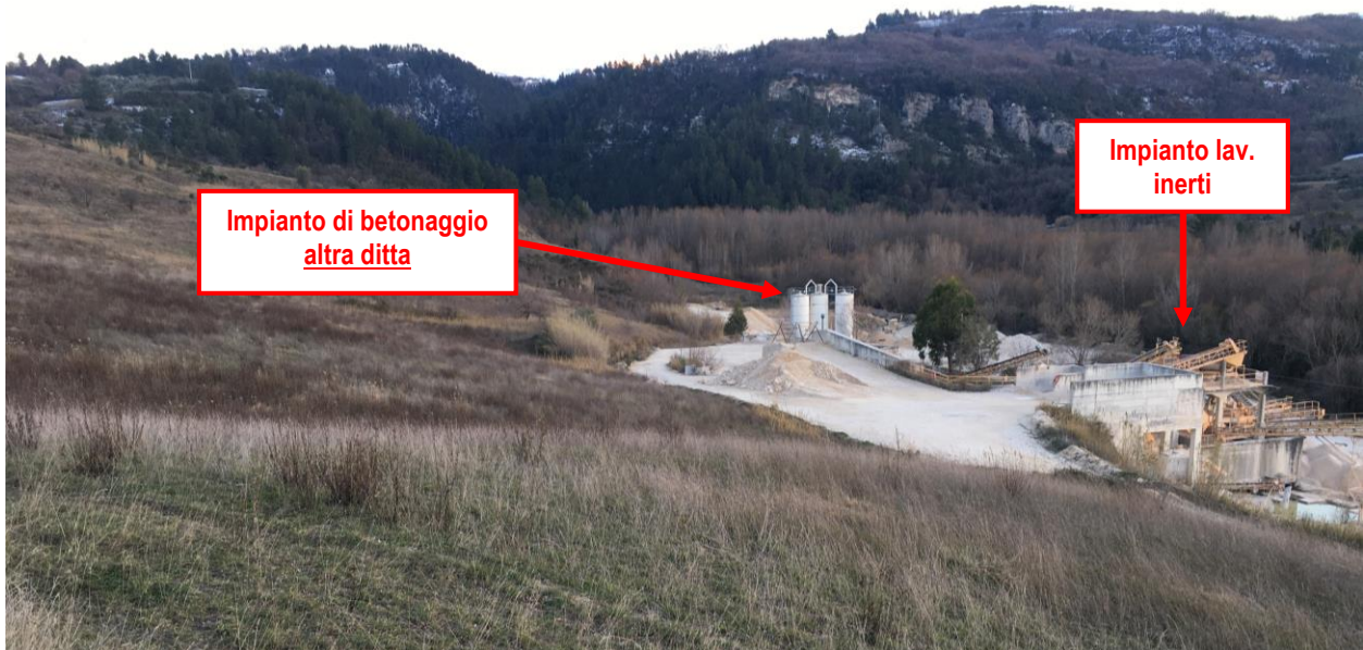
Foto 5 – Vista dell'area di proprietà dalla strada pubblica che conduce a San Valentino
